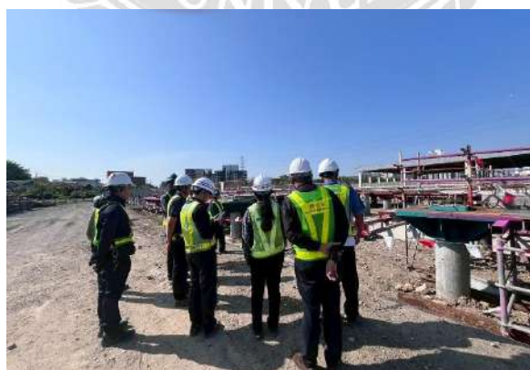
ภาพที่ 3.34 การตรวจเยี่ยมด้านความปลอดภัยฯ (Day Audit) โครงการก่อสร้างรถไฟฟ้าขนส่งมวลชน สายสีส้ม (ตะวันตก)
