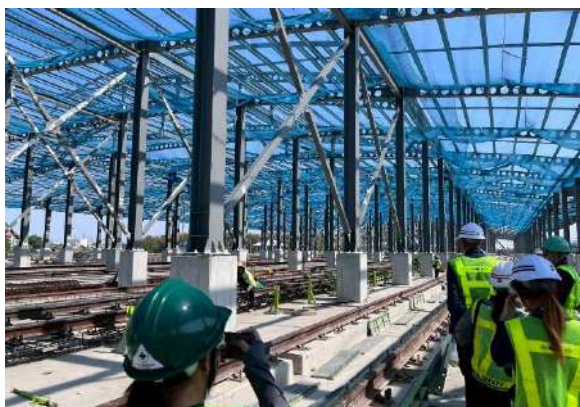
ภาพที่ 3.31 การตรวจเยี่ยมด้านความปลอดภัยฯ (Day Audit) โครงการก่อสร้างรถไฟฟ้าขนส่งมวลชน สายสีม่วง (ใต้) ช่วงเตาปูน-ราษฎร์บูรณะ สัญญาที่ 5 และ 6
