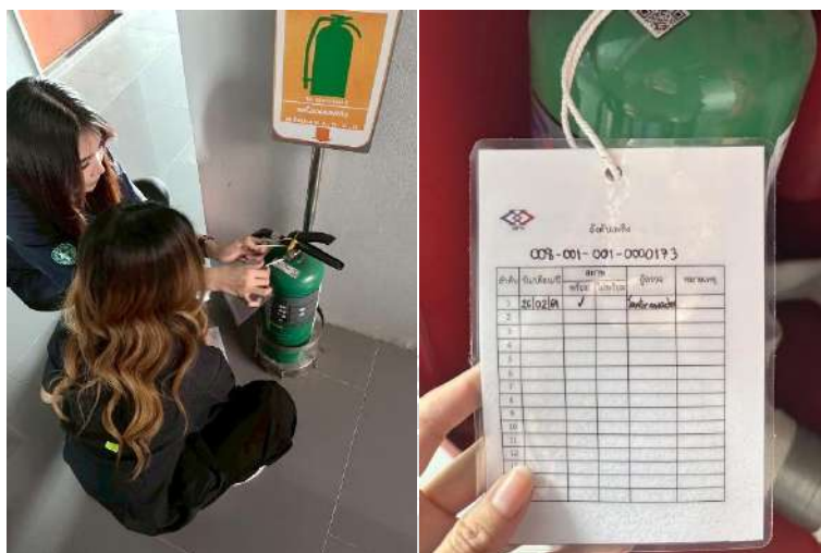
ภาพที่ 3.29 การตรวจสอบ และตรวจเช็คสภาพถังดับเพลิงประจำเดือน
