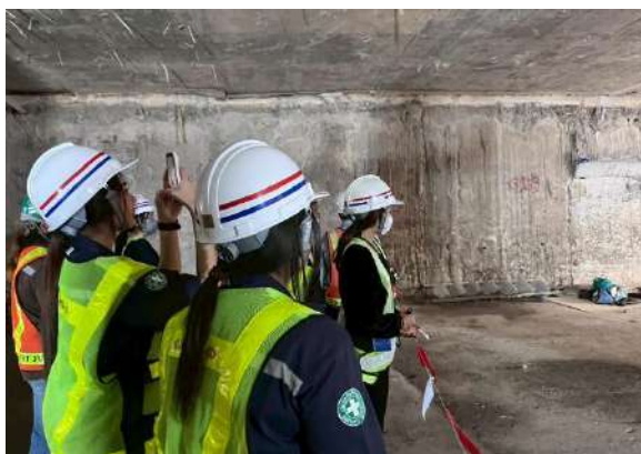
ภาพที่ 3.21 การตรวจเยี่ยมด้านความปลอดภัยฯ (Day Audit) โครงการก่อสร้างรถไฟฟ้าขนส่งมวลชน สายสีม่วง (ใต้) ช่วงเตาปูน-ราษฎร์บูรณะ สัญญาที่ 3 และ 4
