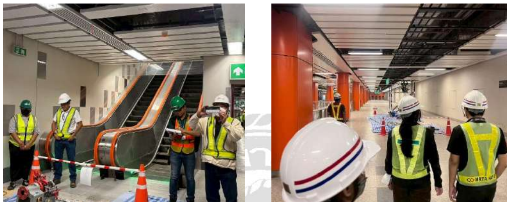
ภาพที่ 3.35 การตรวจเยี่ยมด้านความปลอดภัยฯ (Day Audit) โครงการก่อสร้างรถไฟฟ้าขนส่งมวลชนสายสีส้ม (ตะวันออก)
