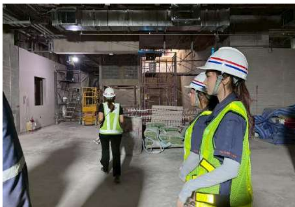
ภาพที่ 3.19 การตรวจเยี่ยมด้านความปลอดภัยฯ (Day Audit) โครงการก่อสร้างรถไฟฟ้าขนส่งมวลชน สายสีม่วง (ใต้) ช่วงเตาปูน-ราษฎร์บูรณะ สัญญาที่ 1 และ 2
