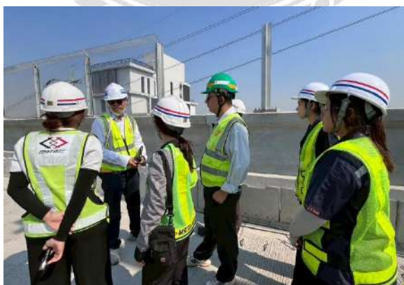
ภาพที่ 3.18 การตรวจเยี่ยมด้านความปลอดภัยฯ (Day Audit) โครงการก่อสร้างรถไฟฟ้าขนส่งมวลชน สายสีม่วง (ใต้) ช่วงเตาปูน-ราษฎร์บูรณะ สัญญาที่ 5 และ 6
