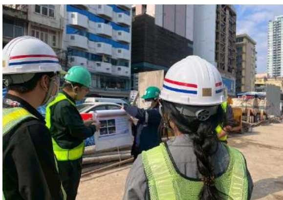
ภาพที่ 3.17 การตรวจเยี่ยมด้านความปลอดภัยฯ (Day Audit) โครงการก่อสร้างรถไฟฟ้าขนส่งมวลชน สายสีส้ม(ตะวันตก)
