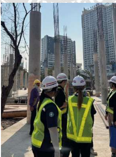
ภาพที่ 3.12 การตรวจเยี่ยมด้านความปลอดภัยฯ (Day Audit) โครงการ ITF
