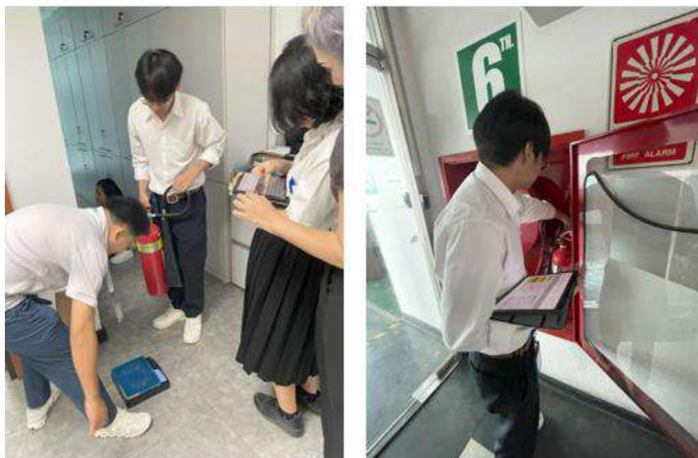
รูปที่ 3.15 ตรวจสอบสภาพถังดับเพลิงตามที่กฎหมายกำหนด
