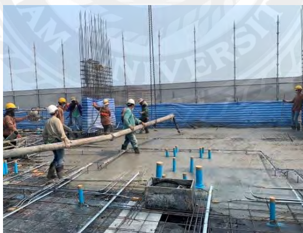
รูปที่ 4.4 การเทคอนกรีตพื้นโครงสร้าง
