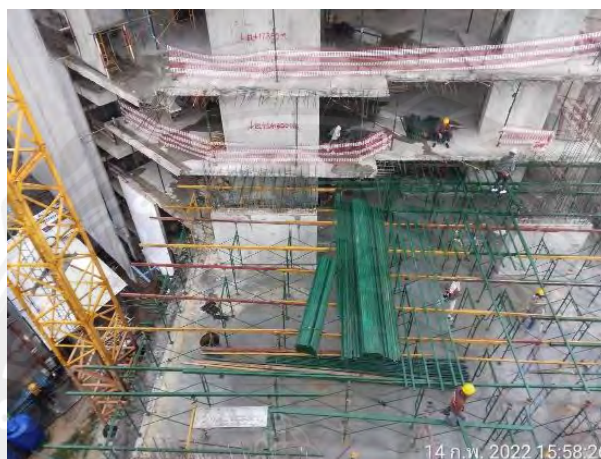
รูปที่ 4.1 การติดตั้งนั่งร้านและค้ำยัน
