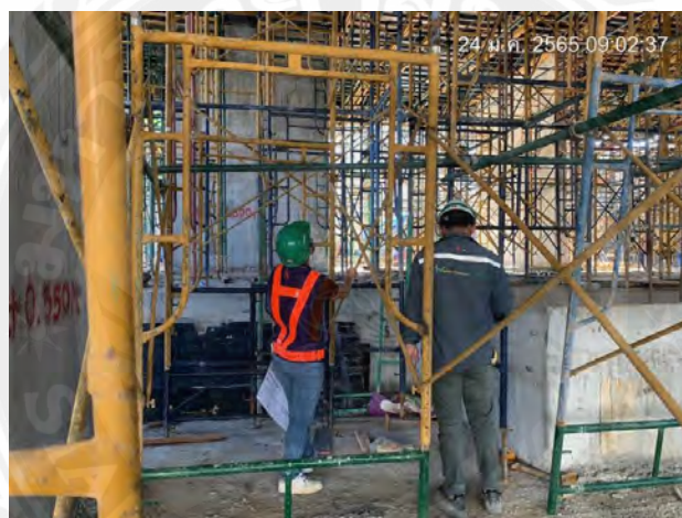
ร่วมตรวจสอบนั่งร้านและค้ำยันนั่งร้านก่อนเทคอนกรีตพื้น
