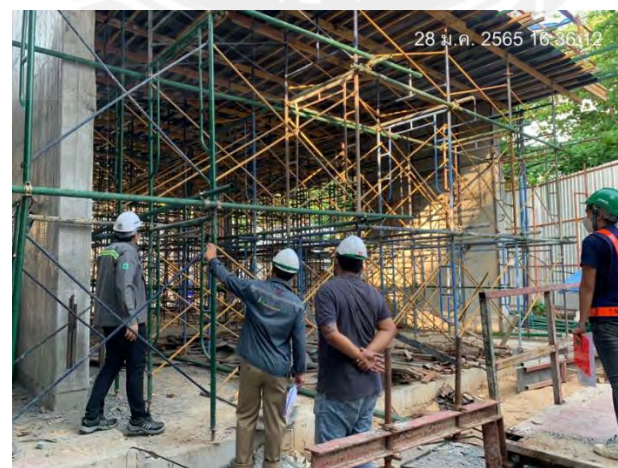
ร่วมตรวจสอบนั่งร้านและค้ำยันนั่งร้านก่อนเทคอนกรีตพื้น
