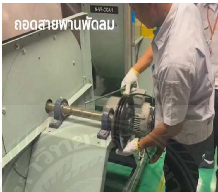
รูปที่ 4.19 ถอดสายพานพัคลม
