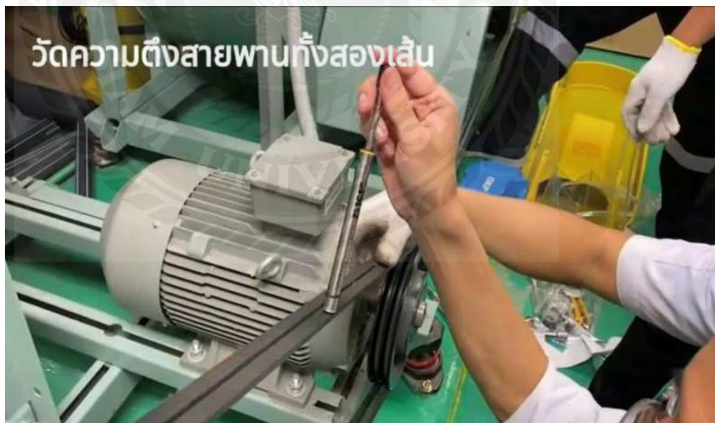
รูปที่ 4.28 วัดความตึงของสายพานทั้งสองเส้น
