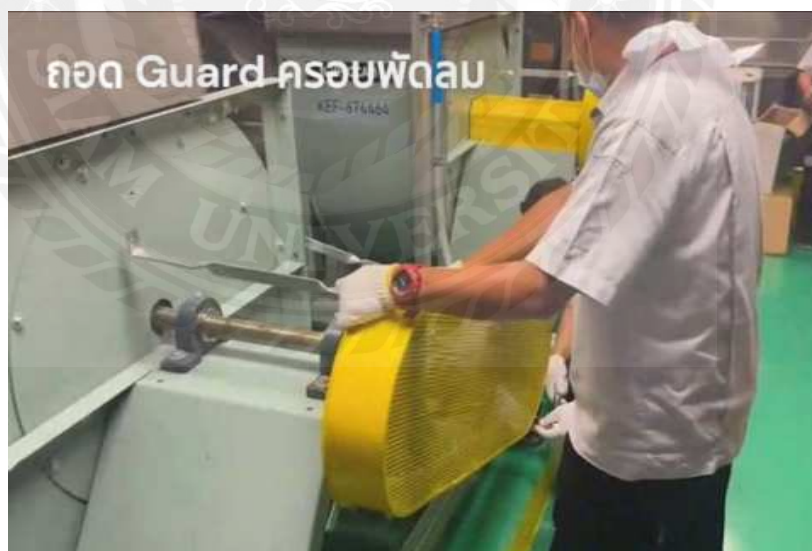
รูปที่ 4.18 ถอดฝาครอบพัดลม
