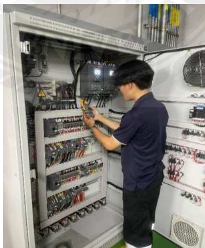
รูปที่ 4.7 วัดค่ากระแสไฟฟ้าของมอเตอร์
