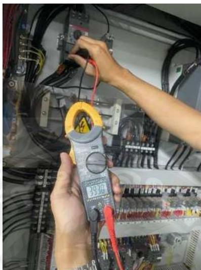
รูปที่ 4.6 วัดค่าแรงดันไฟฟ้าของตู้ควบคุมมอเตอร์
