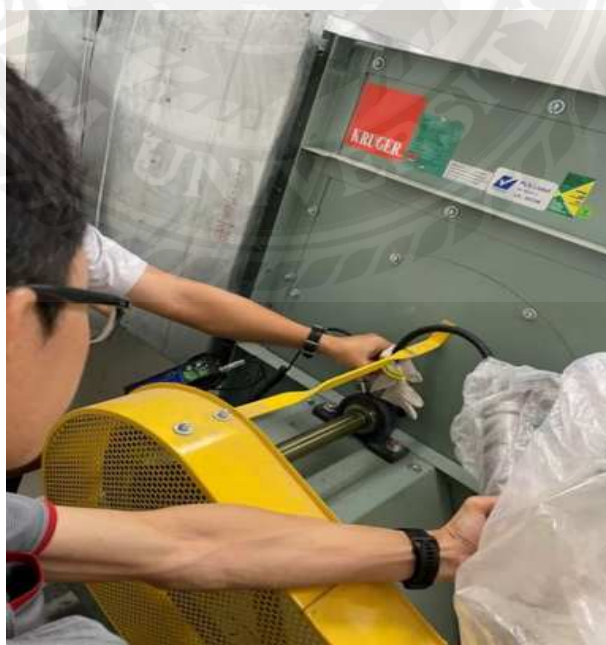
รูปที่ 4.15 การอัดจาระบีลูกปืน
