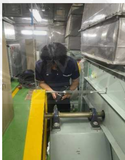
รูปที่ 4.9 การวัดความเร็วรอบของมอเตอร์
