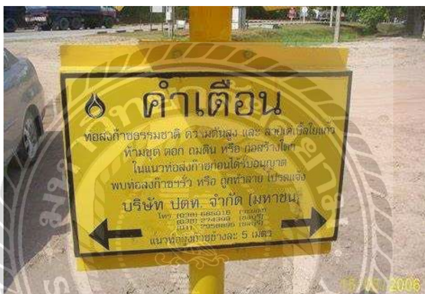
รูปที่ 2.9 ป้ายเตือนท่อฝังใต้ดิน (ของ ปตท.)
