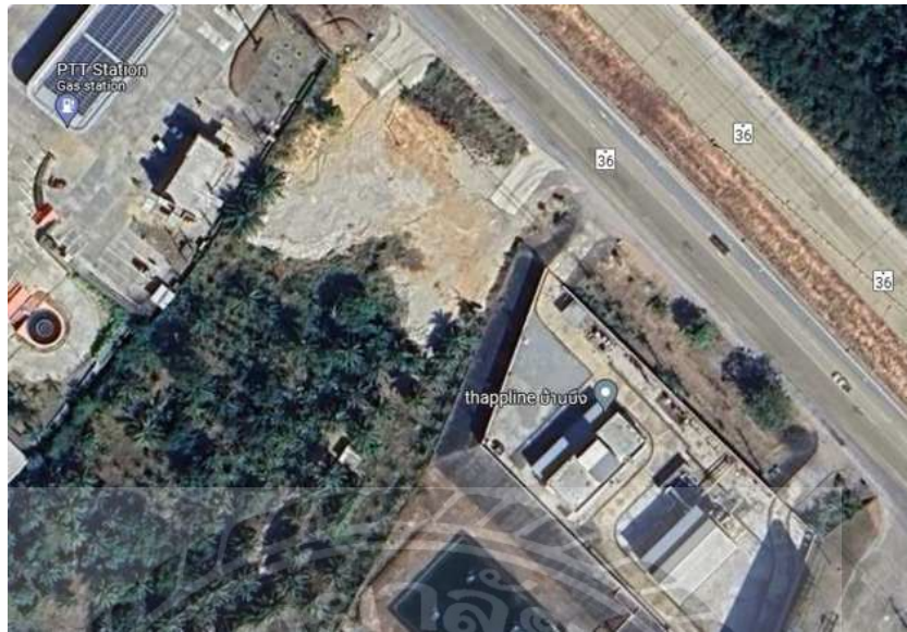
รูปที่ 4.15 ตำแหน่งที่ทำการ Survey สถานีควบคุมระบบท่อที่ 652
