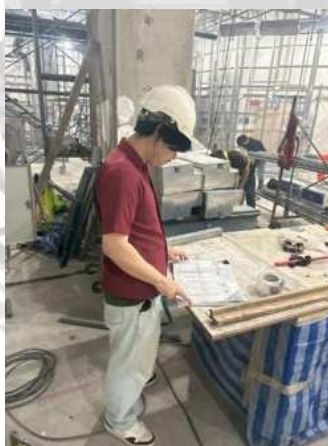
รูปที่ 4.4 ตรวจสอบแบบการติดตั้ง
