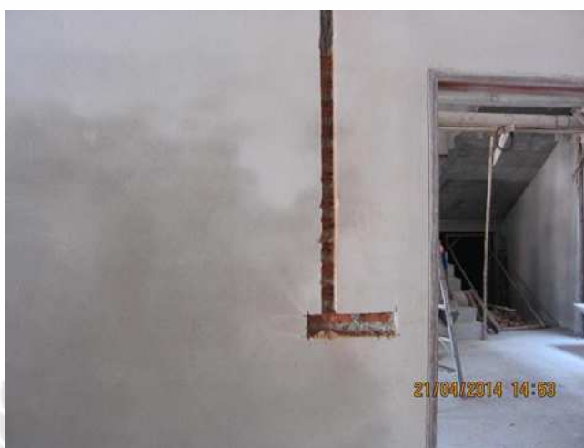
รูปที่ 2.5 การเจาะผนังเพื่อวางตำแหน่งท่อร้อยสายไฟ
