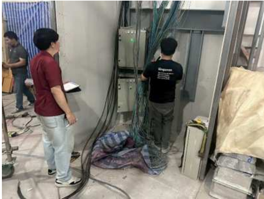
รูปที่ ก.1 ตรวจสอบการต่อสายตู้คอลโทร
