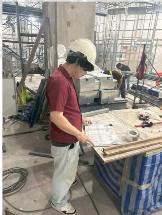
รูปที่ ก.4 ตรวจสอบแบบการติดตั้ง
