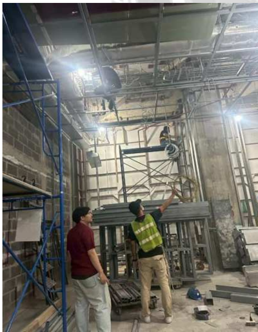
รูปที่ ก.6 ตรวจสอบเช็คแนวทางการเดินท่อร้อยสายไฟ
