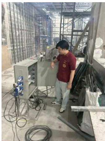
รูปที่ 4.5 เช็คและตรวจสอบตู้พาวเวอร์ปลั๊ก
