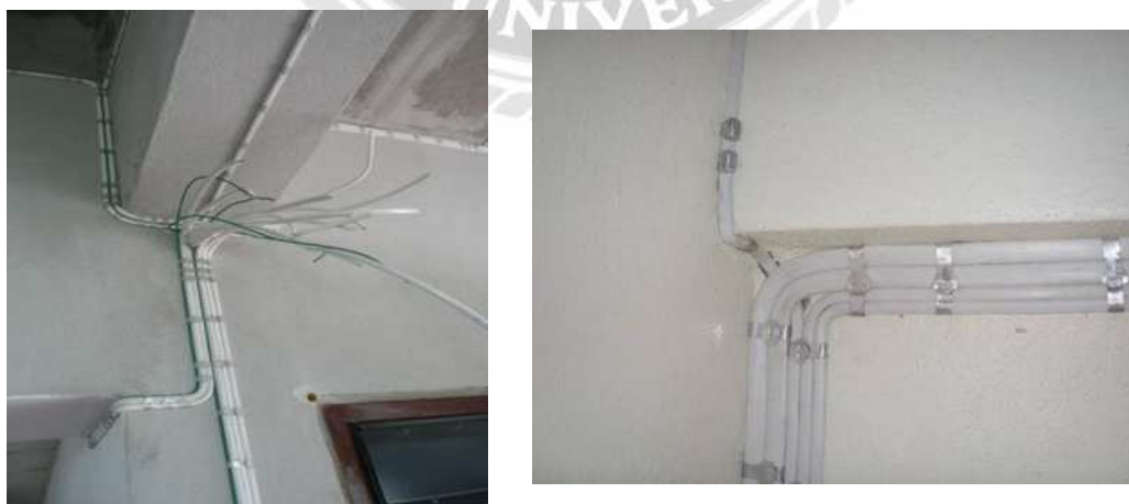
รูปที่ 2.4 การเดินสายไฟแบบเปิด (เดินลอย)
