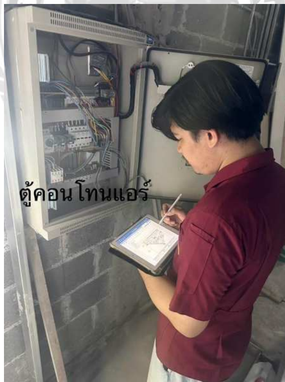
รูปที่ ก.2 ตรวจสอบการต่อสายตู้คอลโทรแอร์
