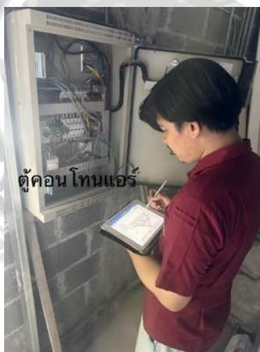
รูปที่ 4.2 ตรวจสอบการต่อสายตู้คอนโทรลแอร์
