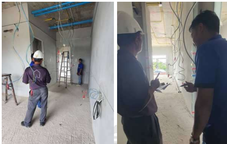
รูปที่ 4.8 ทดสอบความถูกต้องของวงจรแสงสว่าง เต้ารับ และโหลดวงจรย่อยอื่นๆ ก่อนทำการติดตั้งแผ่นฝ้าเพดาน
