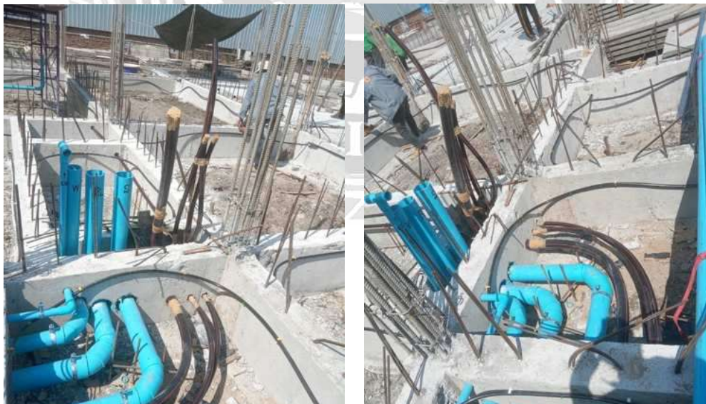
รูปที่ 4.3 ติดตั้งท่อเมนระบบไฟฟ้ากำลัง ไฟฟ้าสื่อสารและระบบอื่นๆที่อยู่ใต้ดิน
