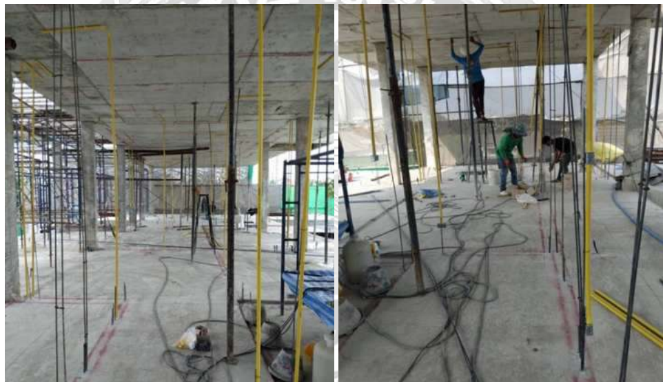
รูปที่ 4.5 ติดตั้งท่อระบบไฟฟ้าที่อยู่ในตำแหน่งแนวผนัง หลังจาก Surveyor เข้าตีแนวก่อผนัง
