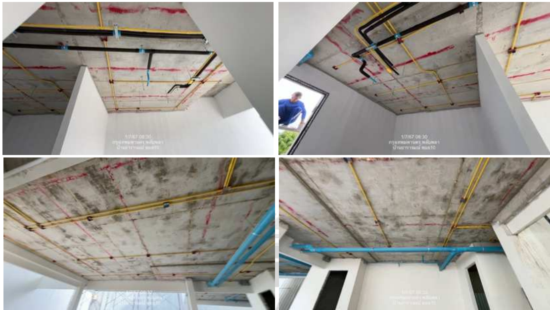
รูปที่ 4.6 ติดตั้งท่อระบบไฟฟ้าที่อยู่ในตำแหน่งท้องพื้น
