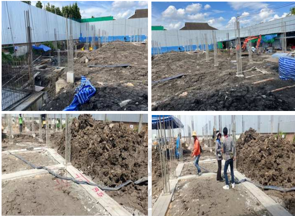
รูปที่ 4.2 สํารวจหน้างานเพื่อวางแผน Sleeve คานชั้น 1 งานระบบต่างๆที่อยู่ใต้ดิน
