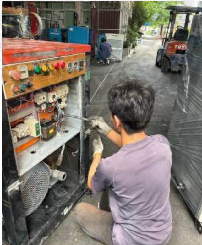
รูปที่ ก 6 ทำการต่อระบบไฟเข้าเครื่องปั๊มลม
