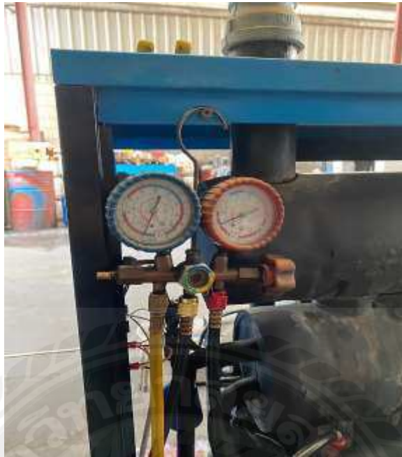
รูปที่ 4.12 เซ็กระบบแรงดันน้ำยาของระบบ Air Dryer
