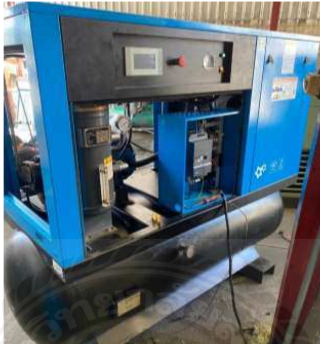
รูปที่ 4.26 ทำการต่อสายลมเข้าปั๊มลมสกรูให้ทำงานคู่กับปั๊มลมสายพาน
