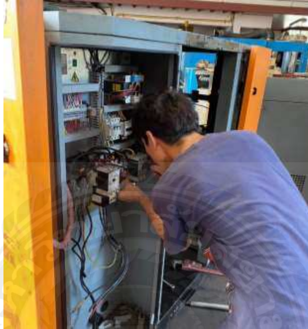
รูปที่ 4.20 ทำการถอดแมกเนติกคอนแทคเตอร์
