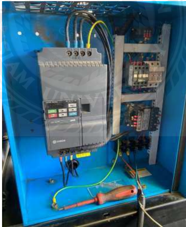
รูปที่ 4.27 ทำการต่อระบบสายไฟเข้าตู้ควบคุมเพื่อจ่ายไฟ
