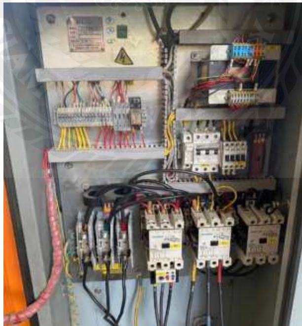
รูปที่ 4.21 ทำการเปลี่ยนแมกเนติกคอนแทคเตอร์เสร็จสิ้น
