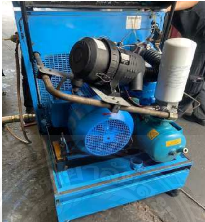
รูปที่ 4.18 ติดตั้งมอเตอร์อุปกรณ์อื่น ๆ ของปั๊มลม
