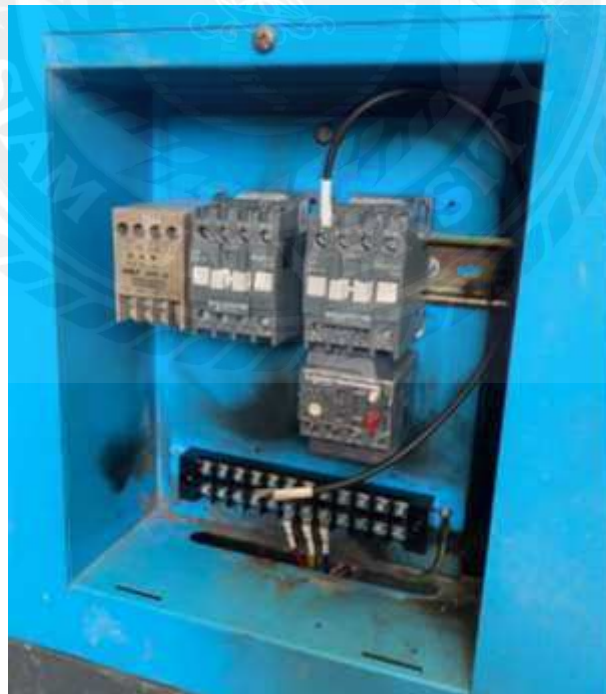
รูปที่ 4.13 รูปก่อนเดินสายไฟ
