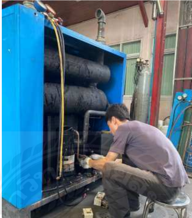
รูปที่ ก 5 ทำการเปลี่ยนเพรสเซอร์คอนโทรล
