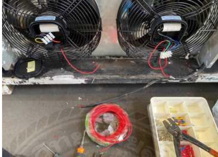
รูปที่ 4.8 ทำการตัดต่อสายไฟพัดลม
