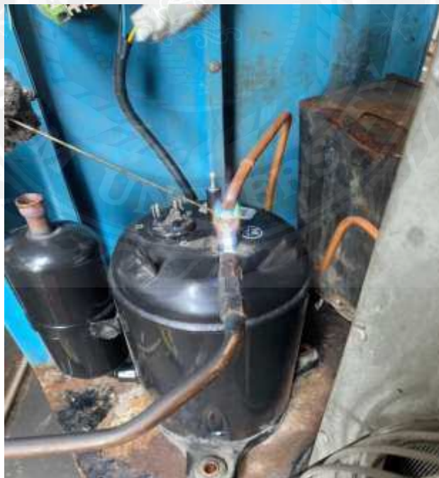
รูปที่ 4.7 ทำการเชื่อมต่อทองแดง ด้วยชุดเชื่อมแก๊ส
