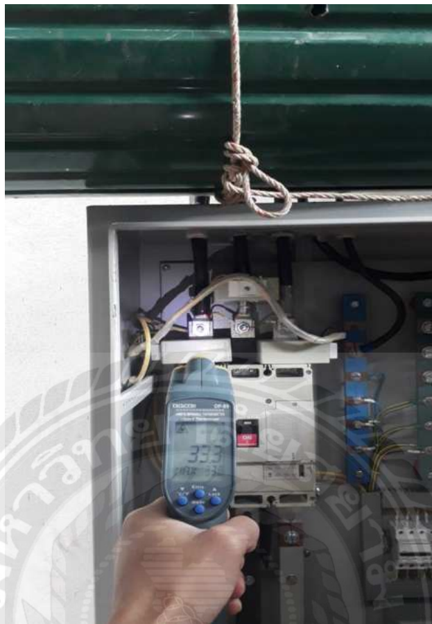
รูปที่ 3.11 ตรวจวัดอุณหภูมิจุดต่อสายไฟฟ้า ขณะ เทสรันเครื่อง
