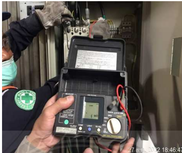
รูปที่ 3.5 ตรวจสอบความเป็นฉนวนสายไฟฟ้า
