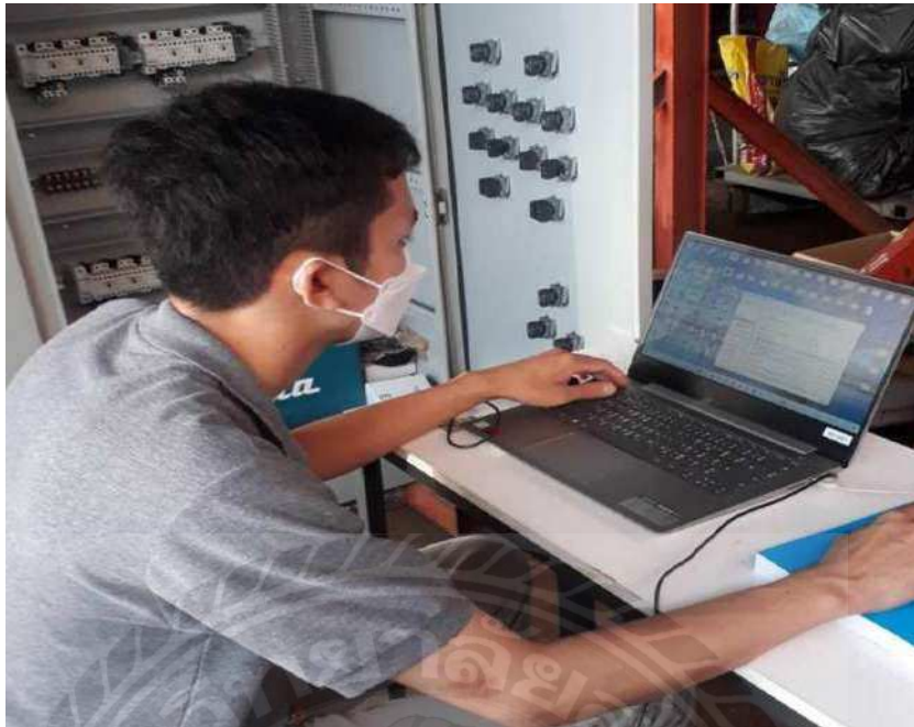
รูปที่ ค 5 ตรวจสอบการประกอบตู้AMCC และ การวางเรียงคอนโทรล
