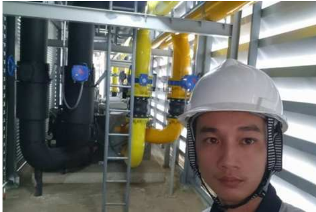
รูปที่ 3.7 ตรวจสอบความเรียบร้อยก่อนออนไฟเข้าระบบ
