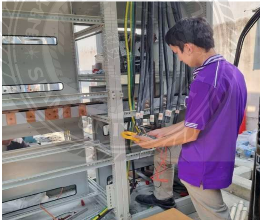
รูปที่ ค 8 ตรวจสอบวงจรสายควบคุมก่อนเข้าหัวสาย เนื่องจากมีสายไฟ 2 เส้นต่อเฟสเพื่อป้องกันการช็อต เซอร์กิต
