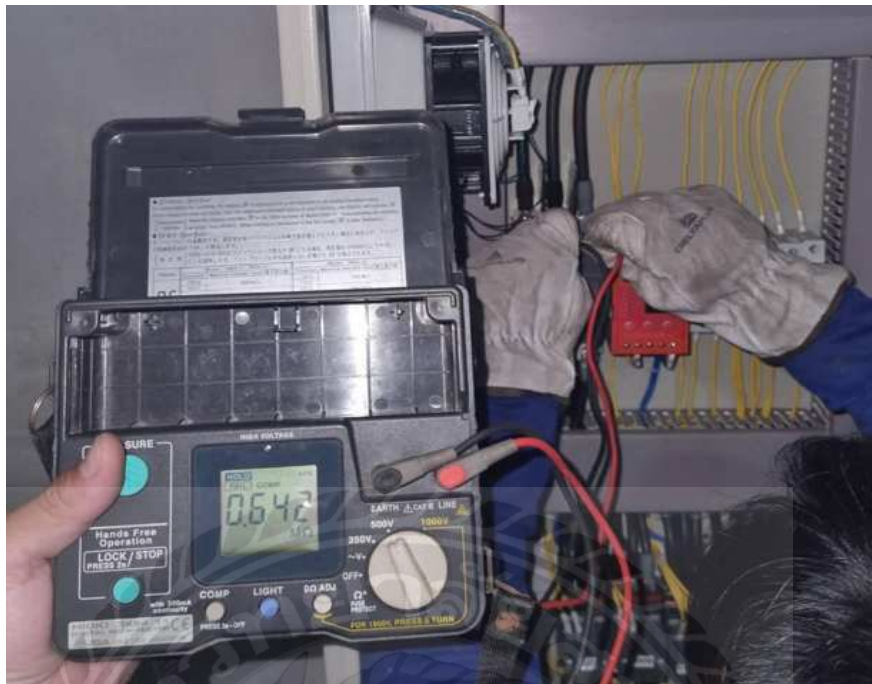
รูปที่ ค 9 วัดค่าความต้านทานฉนวนสายไฟ
