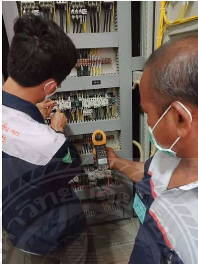
รูปที่ 3.3 ตรวจสอบการวางรีจคอนโทรล
