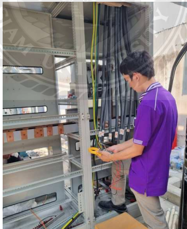
รูปที่ 3.4 ตรวจสอบการวางจรสายควบ
