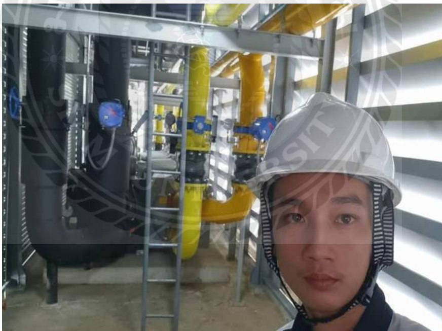
รูปที่ ค 10 ตรวจสอบงานติดตั้งโดยภาพรวมเช่นการติดตั้ง (Chiller/Cooling Tower/Pump/ท่อน้ำยา) ก่อนเทสรันระบบ
