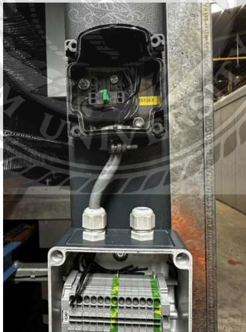
รูปที่ 16 การยึดกล่องบนเสาเหล็ก
