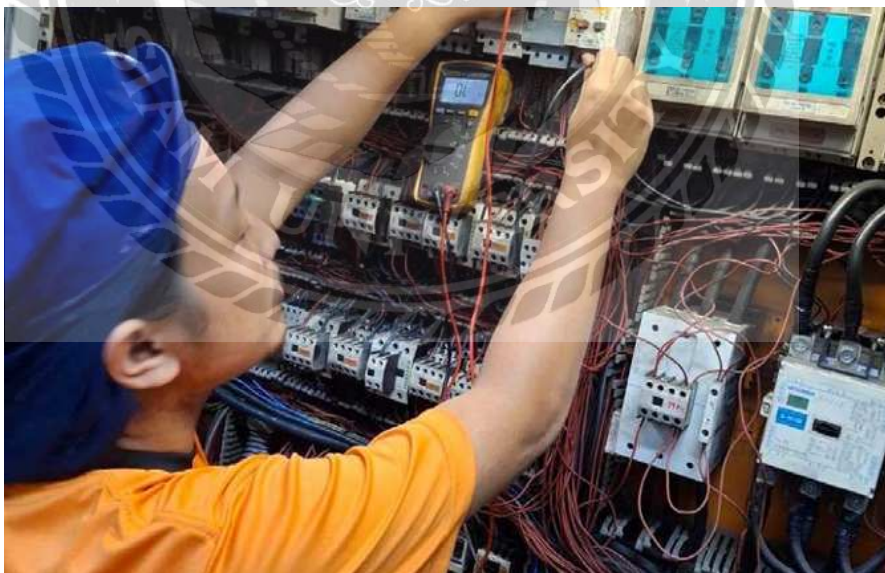
รูปที่ 2 การตรวจสอบสายไฟขาด
