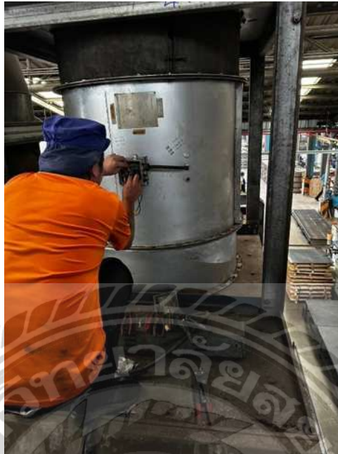
รูปที่ 15 การถอดชุดสายไฟมอเตอร์
