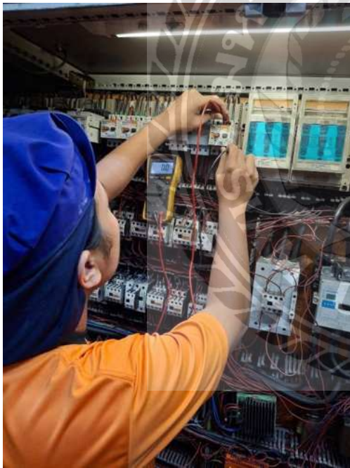
รูปที่ 14 การวัดกระแสหาความผิดปกติของคอนเทคเตอร์
