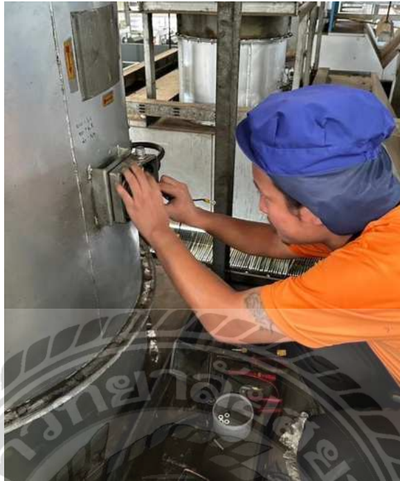
รูปที่ 1 การติดตั้งมอเตอร์พัดลมระบายความร้อน
