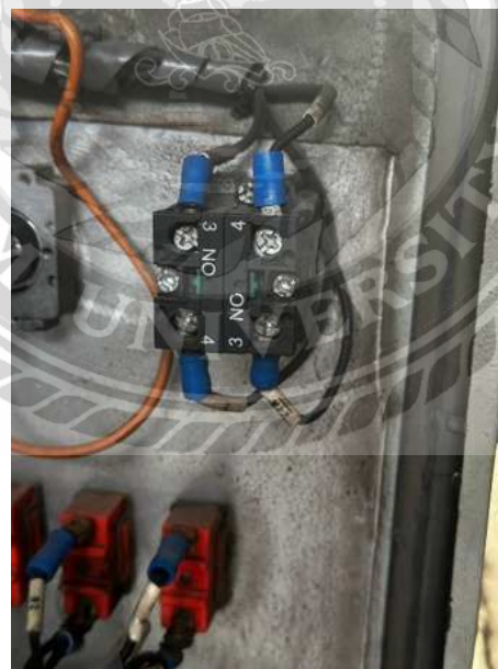
รูปที่ 6 การซ่อมแซมสวิทช์ปุ่มกด
