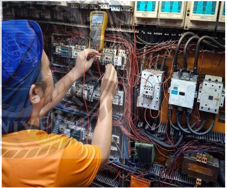
รูปที่ 13 การติดตั้งเดินสายของระบบเซพต์
