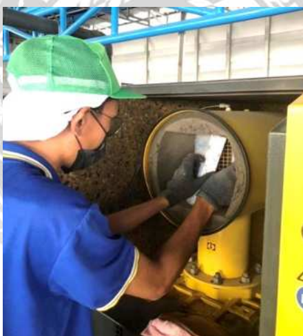
รูปที่ 4.9 การถอดกรองอากาศมาทำการเป่าฝุ่น
