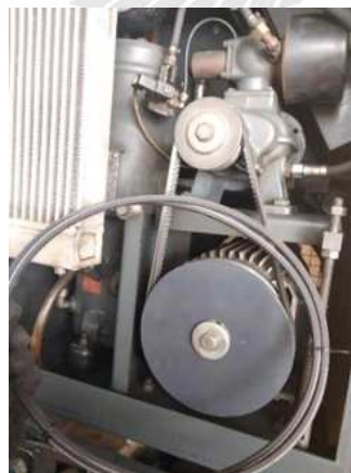
รูปที่ 4.14 การเปลี่ยนสายพานเส้นใหม่ทดแทน
