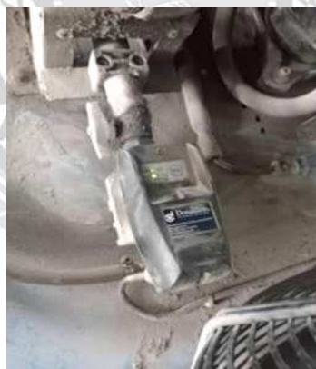
รูปที่ 4.11 การตรวจสอบระบบระบายน้ำทิ้ง
