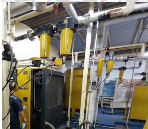
รูปที่ 4.3 การเดินท่อส่งจ่ายลมอัดเข้าระบบกรองฝุ่น
