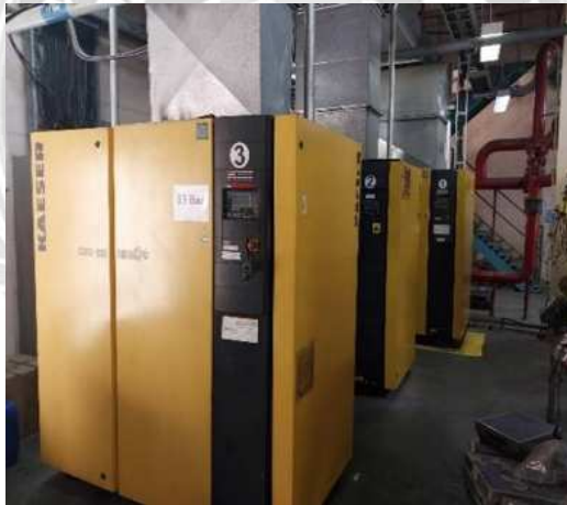
รูปที่ 4.1 การติดตั้งเครื่องอัดอากาศในพื้นที่ที่เหมาะสม
