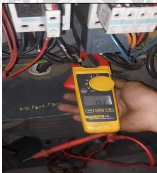
รูปที่ 4.7 การตรวจสอบกระแสไฟฟ้าขณะเครื่องอัดอากาศทำงาน
