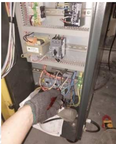
รูปที่ 4.15 การตรวจสอบการยึดแน่นของขั้วต่อสายไฟฟ้า
