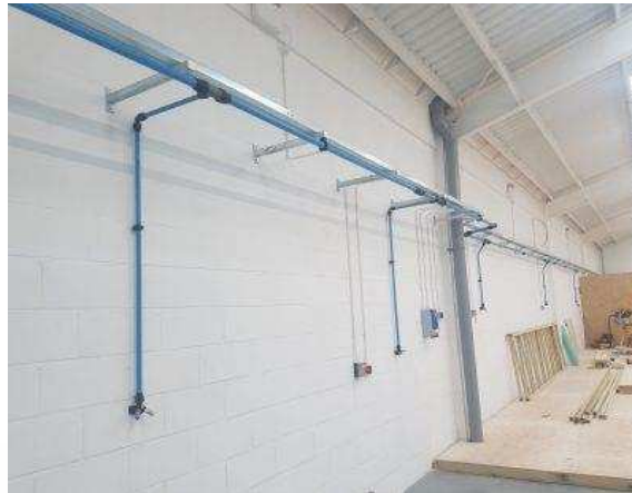
รูปที่ 4.2 การเดินท่อส่งจ่ายลมอัด (Main Line)
