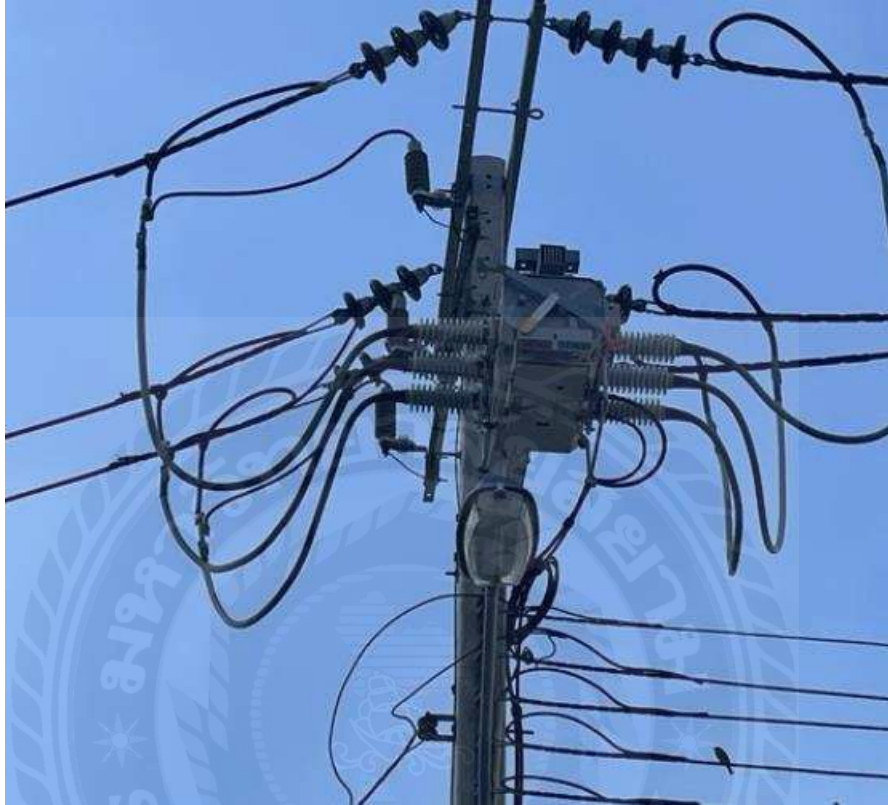
รูปที่ 4.9 ทำการทดสอบโดยการสั่งการผ่านโทรศัพท์ในการปลด Load Break
