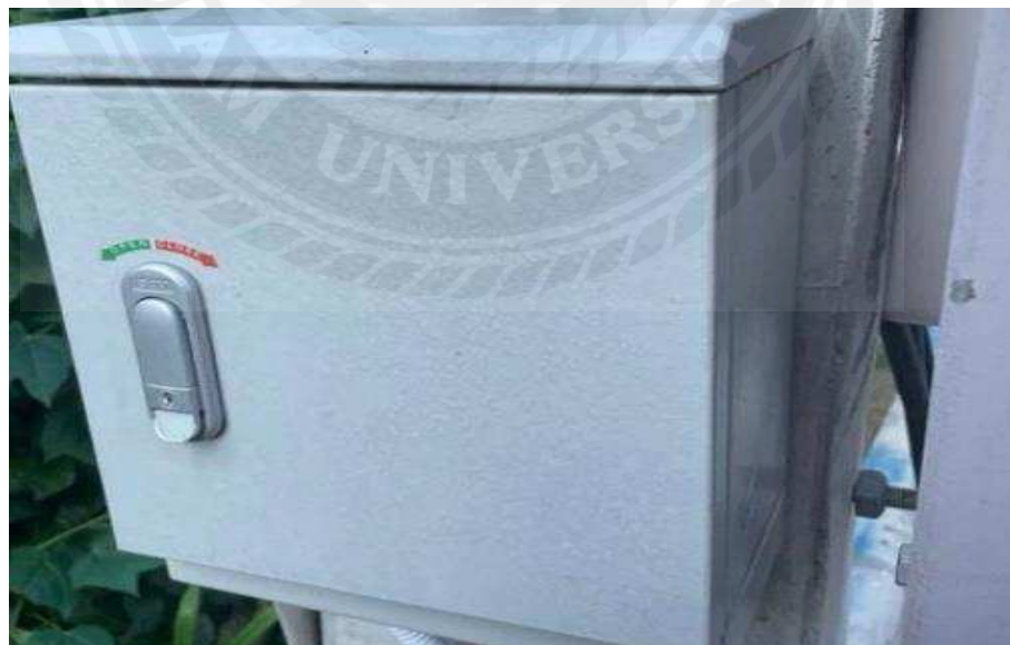
รูปที่ 4.8 ตรวจสอบความเรียบร้อยหลังการติดตั้งของ Dry Riser Section
