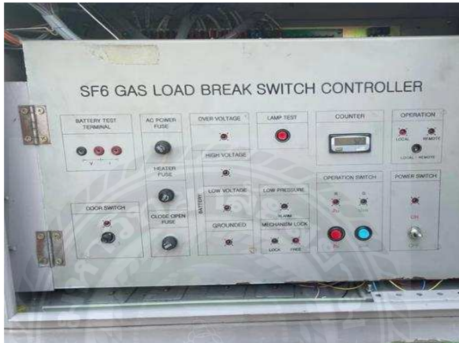
รูปที่ 4.7 ตรวจสอบความเรียบร้อยหลังการติดตั้งของ Fault Circuit Indicator
