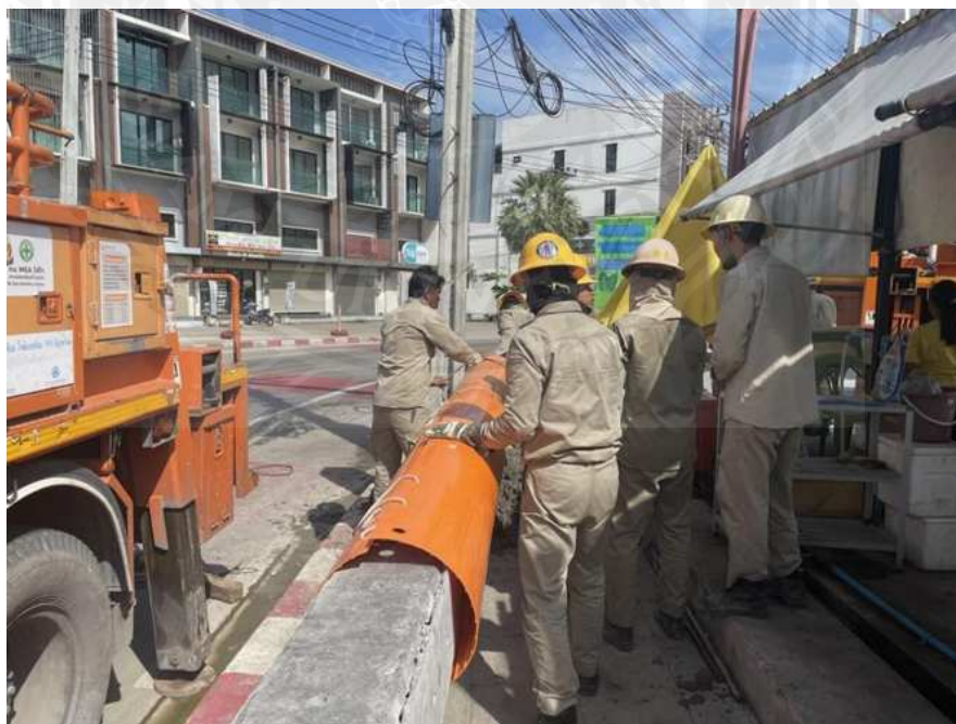
การติดตั้งเสาไฟฟ้าแรงสูง
