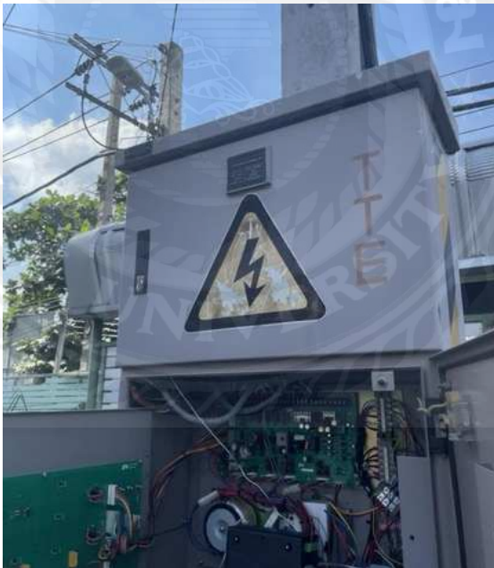
ติดตั้ง Smart Remote Load Break Switch
