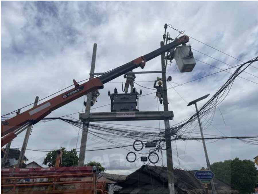
การติดตั้งหม้อแปลง
