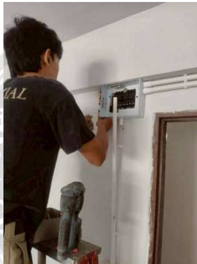
รูปที่ 4.1 การติดตั้งตู้ไฟ
