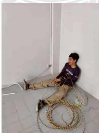
รูปที่ 4.19 การร้อยสายไฟด้วยฟิชเทป
