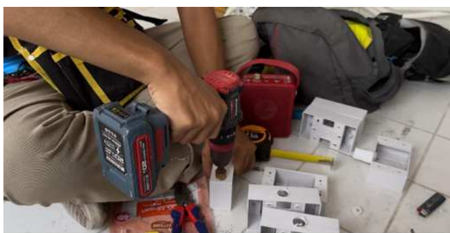
รูปที่ 4.28 การเจาะบล็อกลอย
