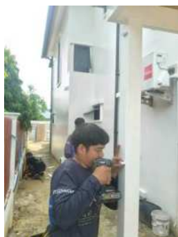
รูปที่ 4.20 การติดตั้งก้ามปูยึดท่อ
