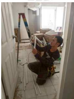
รูปที่ 4.22 การตัดท่อ U pvc สีขาว
