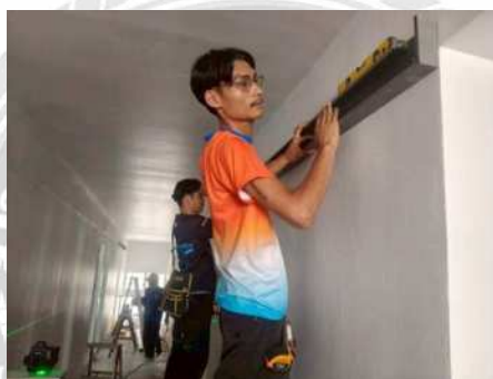
รูปที่ 4.18 การติดตั้งรางวางสาย
