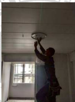
รูปที่ 4.3 การติดตั้งโคมไฟชนิดติดลอย
