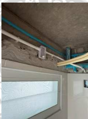
รูปที่ 4.27 การติดตั้งบล็อกพักสาย 2*4
