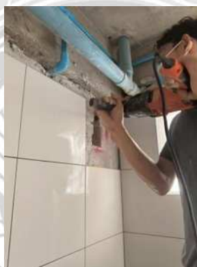
รูปที่ 4.15 การสกัดปูนเพื่อฝิ่งบล็อกน้ำอุ่น
