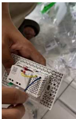
รูปที่ 4.29 การต่อ socket USB กับปลั๊ก
