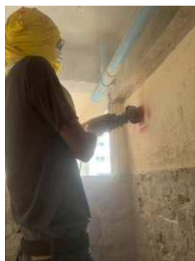
รูปที่ 4.14 การกรีดผนังบังฝิ่งบล็อกสำหรับเครื่องทำน้ำอุ่น
