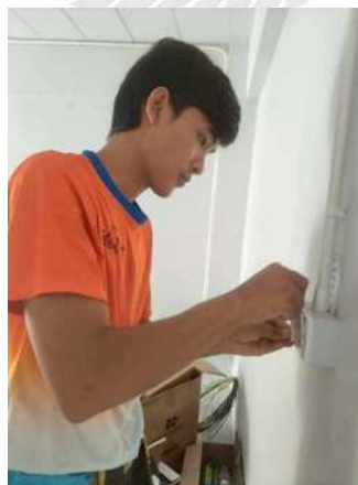
รูปที่ ค 6 การเข้าสายสวิตช์หรือจัมป์สาย
