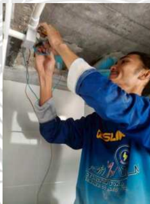
รูปที่ 4.24 การจี้มสายในบล็อกรักสาย
