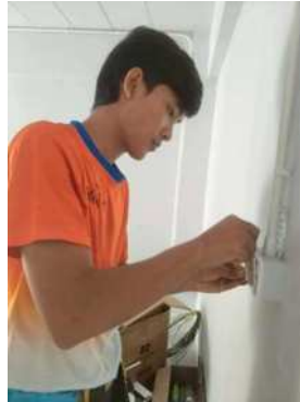
รูปที่ 4.5 การติดตั้งสวิตช์
