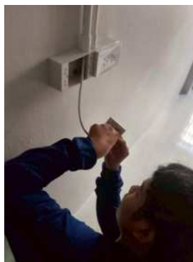
รูปที่ 4.4 การติดตั้งปลั๊กแลน
