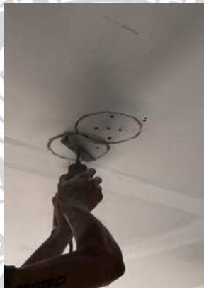
รูปที่ 4.33 การเจาะฝ้าเพดานเพื่อติดตั้งหลอดไฟ
