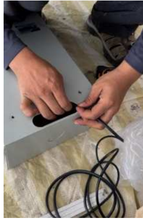
รูปที่ 4.32 การใส่กันบาดเพื่อป้องกันไม่ให้สายไฟชำรุด
