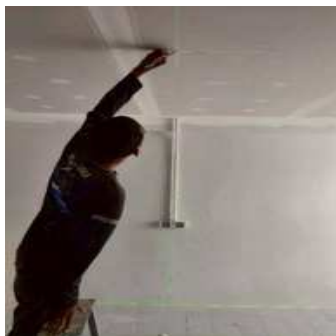
รูปที่ ค 1 วัดระยะหาตำแหน่งเพื่อจะติดตั้งโคม
