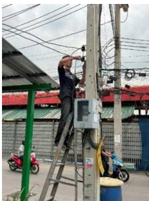
รูปที่ 4.26 การดึงสายไฟกับเสาไฟฟ้าด้วยแล็ก 2 ช่อง
