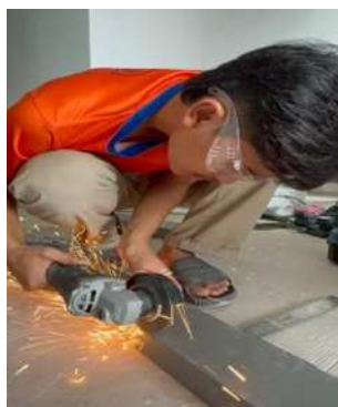
รูปที่ 4.17 การตัดรางวางสาย
