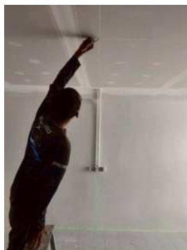
รูปที่ 4.10 การมาร์คตำแหน่งหลอดไฟการมาร์คตำแหน่งหลอดไฟด้วยเลเซอร์
