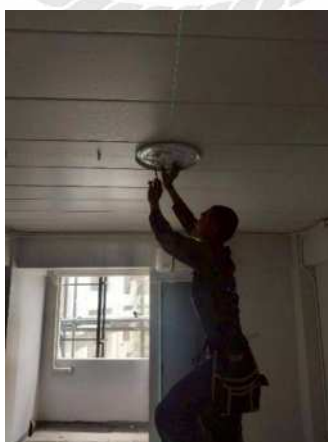
รูปที่ ค 3 ทำการติดตั้งโคม
