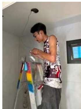
รูปที่ 4.7 การติดตั้งการติดตั้งคอมไฟชนิดฝังฝ้า
