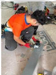
รูปที่ 3.37 การตัดรางและฝาราง
