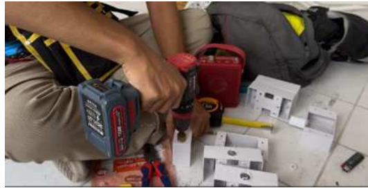
รูปที่ ค 4 เจาะบล็อกลอยเพื่อเตรียมยึดบล็อก
