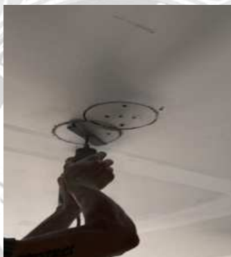
รูปที่ ค 2 เจาะฝ้าเพื่อจะทำการยึดโคม
