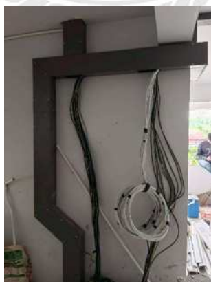
ภาพหลังจากการติดตั้งรางสายเรียบร้อยแล้ว
