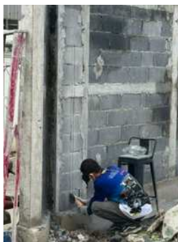
รูปที่ 4.11 การกรีดผนังฝังท่อไฟกิ่ง
