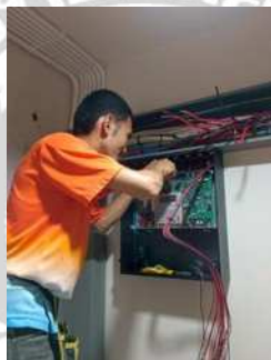
รูปที่ 4.12 การวางสายตู้ไฟอราม
