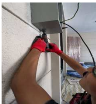
รูปที่ 4.31 การเจาะตู้ด้วยสว่าน
