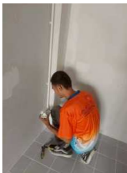
รูปที่ 4.2 การติดตั้งปลั๊ก
