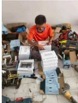
รูปที่ 4.23 การมาร์คเพื่อเจาะรูของตู้คอนซูเมอร์
