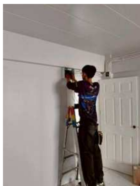
รูปที่ 4.8 การวางสายในตู้ไฟ
