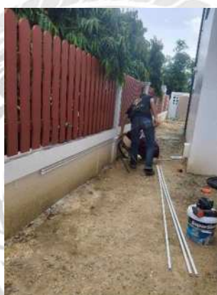
รูปที่ 4.21 การติดตั้งท่อ U pvc สีขาว
