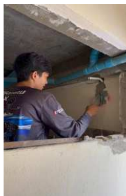
รูปที่ 4.16 การฉาบปิดบล็อกน้ำอุ่น
