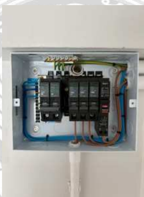
รูปที่ 4.9 ภาพหลังจากการวางสายในตู้ไฟ
