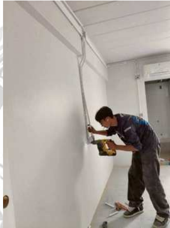
รูปที่ ค 5 ทำการเจาะกำแพงเพื่อยึดบล็อกลอย
