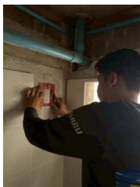
รูปที่ 4.13 การมาร์คบล็อกฝังสำหรับเครื่องทำน้ำอุ่น
