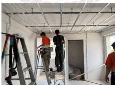
รูปที่ 3.35 การย้ำสายแลนและติดตั้งกล่องวงจรปิด
