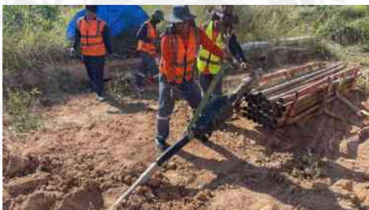
รูปที่ 4.7 การใส่ Reamer เข้าไปแทนที่หัวเจาะ และให้เครื่องเจาะหมุนติงกลับ เพื่อคว้านขยายแนว
