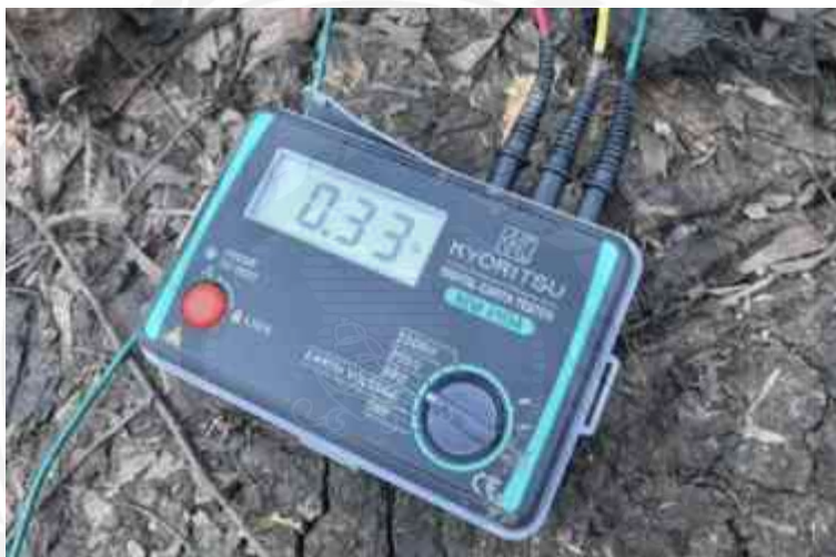
รูปที่ 4.111 การทดสอบการต่อลงดิน
