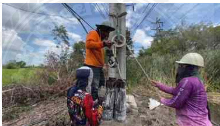
รูปที่ 4.15 การทำความสะอาดท่อร้อยสายด้วยผ้ากระสอบหรือ Flexible Cleaner
