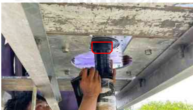
รูปที่ 4.65 พันด้วย SB Tape insulation ระหว่างระยะ Copper Mesh ใต้ Mark A จนถึงระยะทรงกรวย 50% ของ Silicone Cable Sheath
