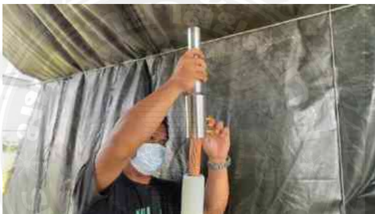
รูปที่ 4.87 ติดตั้ง Connection Bolt
