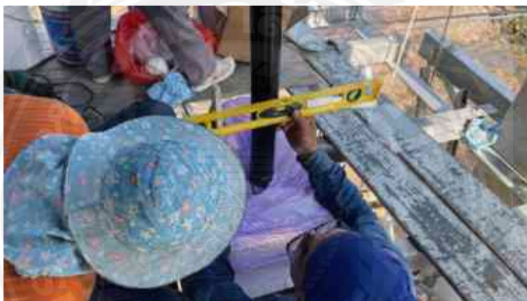
รูปที่ 4.70 ทำการวัดและตัดสายเคเบิลให้ได้ตามขนาด เพื่อเตรียมการขุดผิวถนน (3)
