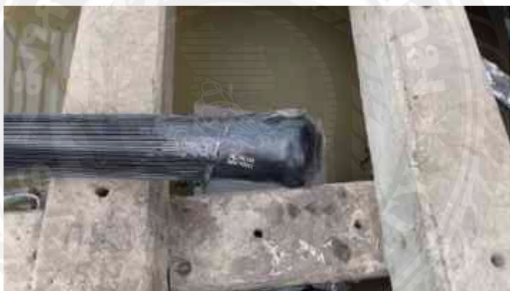
รูปที่ 4.32 การพันปิดปลายสายเคเบิลใต้ดิน (Sealing End Cable) (2)
