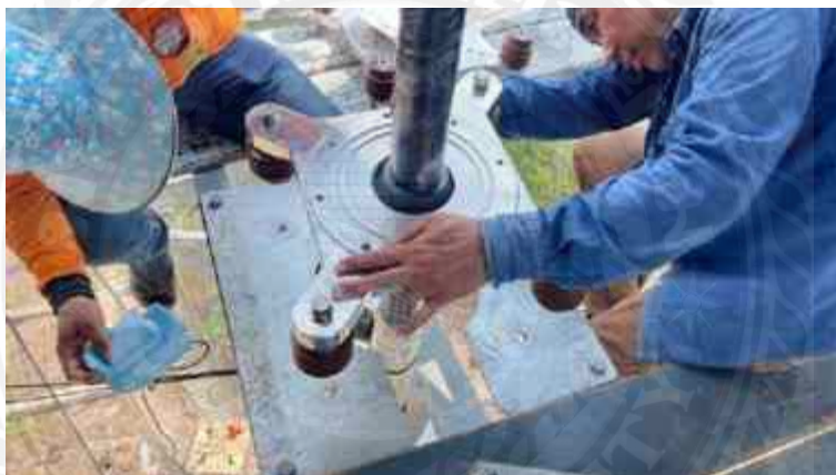
รูปที่ 4.64 ติดตั้ง Baseplate
