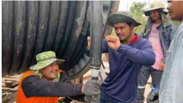
รูปที่ 4.21 การเตรียมหัวสายเคเบิล เพื่อประกอบเข้ากับ Pulling Head
