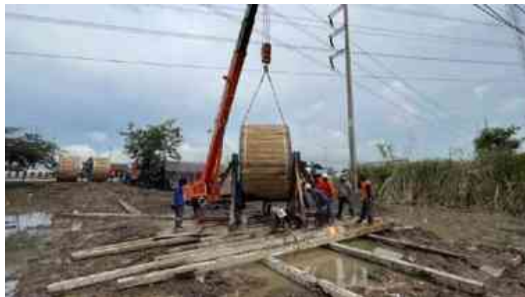
รูปที่ 4.14 การติดตั้งล้อสายเคเบิล
