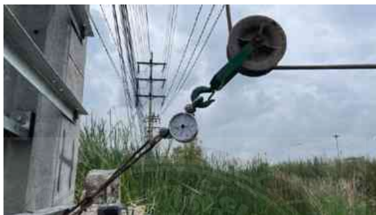
รูปที่ 4.25 การวัดแรงดึงสายเคเบิลระหว่างการดึงสายเคเบิล ด้วยมิเตอร์วัดแรงดึงสายเคเบิลใต้ดิน (Dynamo meter)
