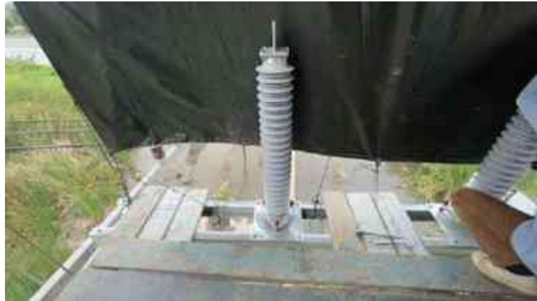
รูปที่ 4.106 ติดตั้งชุดกับดักเสิร์จแรงสูง (2)
