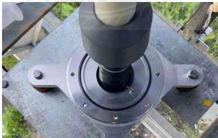
รูปที่ 4.91 ติดตั้ง O-Sealing Ring ที่ตำแหน่งบน Baseplate
