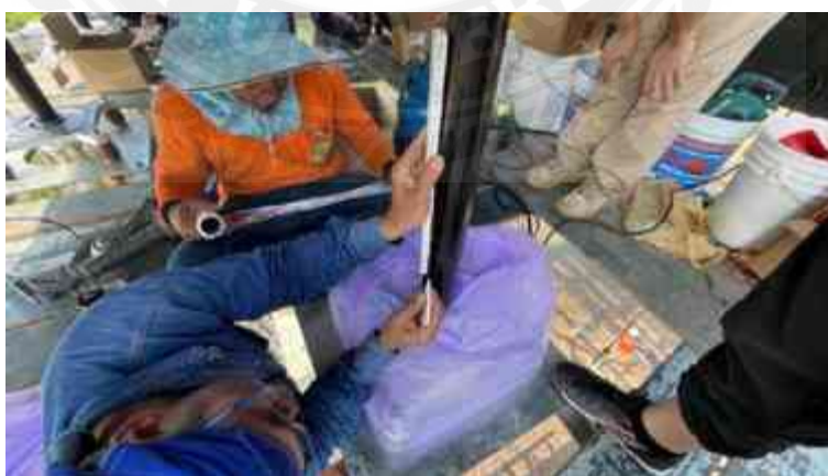
รูปที่ 4.71 ทำการวัดและตัดสายเคเบิลให้ได้ตามขนาด เพื่อเตรียมการขุดผิวถนน (4)
