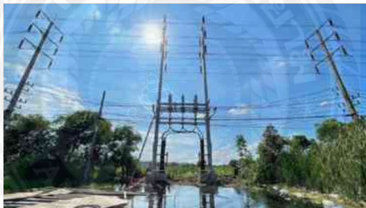
รูปที่ 4.110 เสาต้น Riser เมื่อทำการติดตั้ง จุดต่อปลายสาย Termination แล้วเสร็จ
