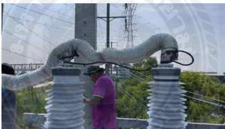
รูปที่ 4.114 การทดสอบแรงดันไฟฟ้ากระแสสลับ (AC Voltage Test) (2)
