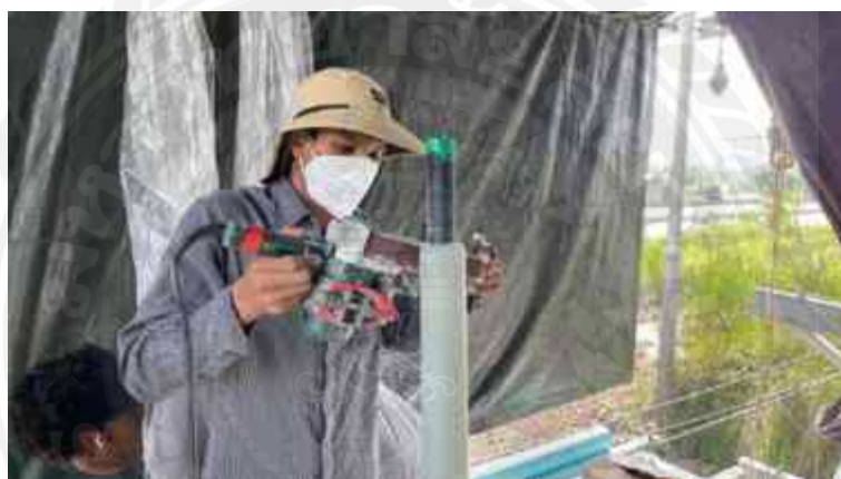
รูปที่ 4.73 ปอกเนื้อฉนวนส่วนบนให้เหลือเพียงตัวนำให้ได้ระยะตามคู่มือฯ และขัดเนื้อฉนวนส่วนที่เหลือด้วยเครื่องขัดกระดาษทราย
