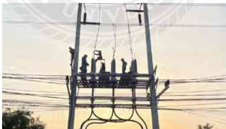
รูปที่ 4.123 เชื่อมต่อสายเคเบิลใต้ดินเข้ากับระบบสายส่งเหนือพื้น 115 กิโลโวลต์ (4)
