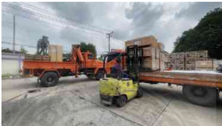
รูปที่ 4.19 การเบิกอุปกรณ์การติดตั้งชุดต่อปลายสาย
