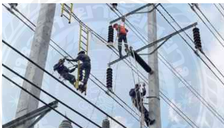
รูปที่ 4.122 เชื่อมต่อสายเคเบิลใต้ดินเข้ากับระบบสายส่งเหนือพื้น 115 กิโลโวลต์ (3)
