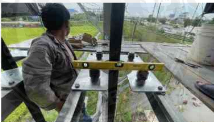
รูปที่ 4.48 การติดตั้ง Support Insulator
