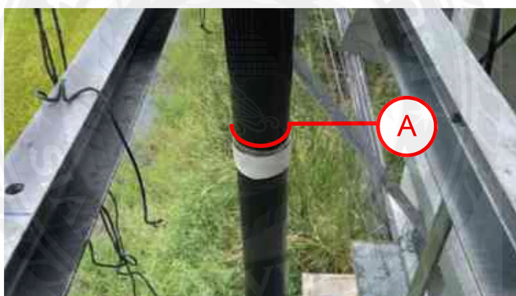
รูปที่ 4.50 การพันด้วยเทปสปริง
