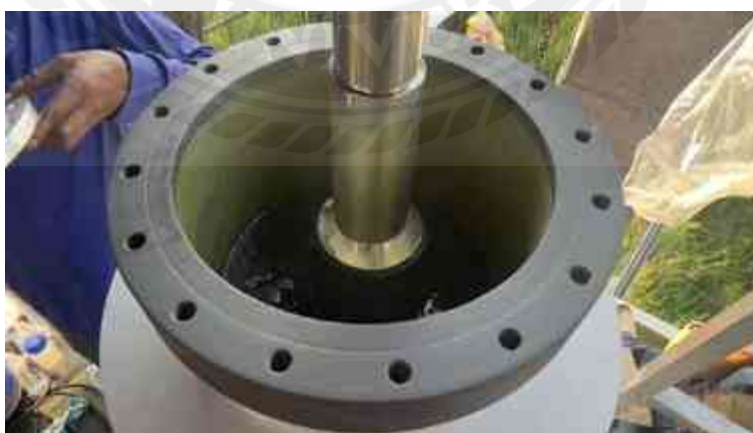
รูปที่ 4.96 เติมฉนวนน้ำมันลงในชุดต่อปลายสาย Termination (3)
