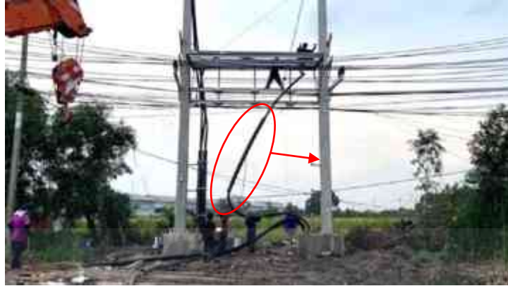
รูปที่ 4.33 การจับยึดสายเคเบิลเข้ากับโครงสร้างของเสาขึ้นสายเคเบิลใต้ดิน (1)
