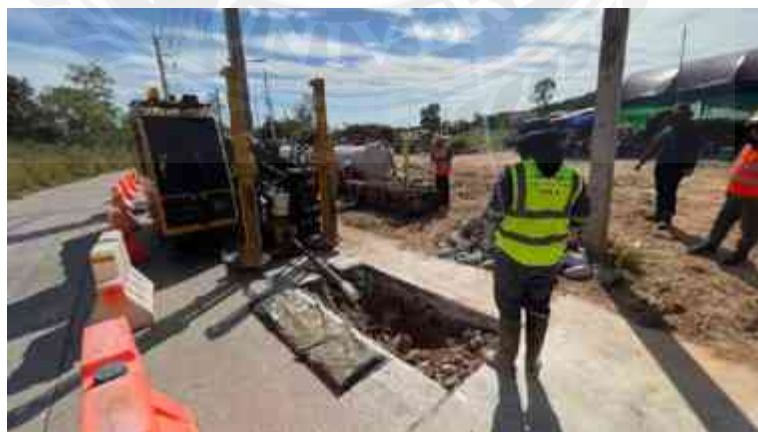
รูปที่ 4.5 การนำเจาะ
