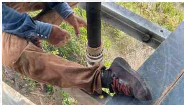
รูปที่ 4.58 พันด้วย Copper Mesh ทับ Copper Wire Shield ได้ Mark A
