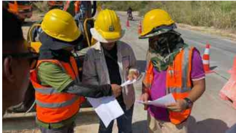
รูปที่ 4.3 การดำเนินการเจาะตามแผน
