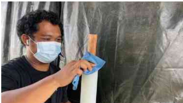
รูปที่ 4.86 ทำความสะอาดตัวนำที่ตำแหน่งปลายสาย
