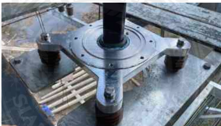
รูปที่ 4.67 แสดง Baseplate ที่ติดตั้งชุดปิดท้าย Cable Gland เสร็จเรียบร้อยแล้ว
