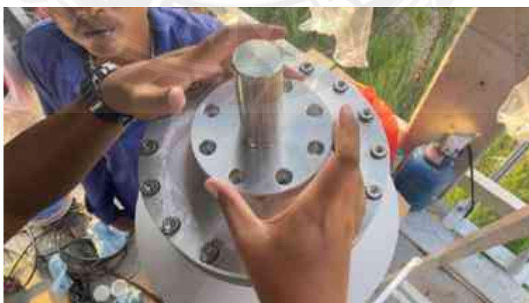
รูปที่ 4.99 ติดตั้งซีลส่วนบนที่ Connection Bolt ของชุดต่อปลายสาย Termination (1)
