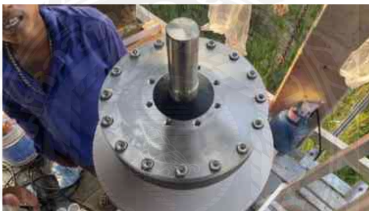
รูปที่ 4.98 ติดตั้งซีลส่วนบนของฉนวนชุดต่อปลายสาย Termination (2)
