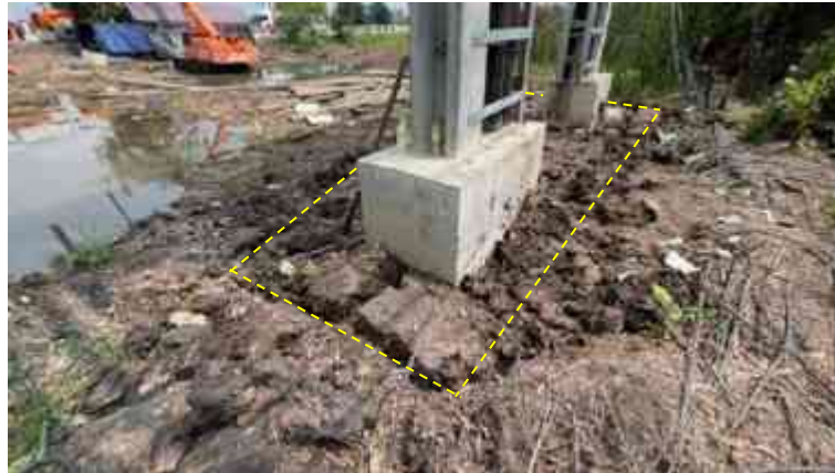
รูปที่ 4.109 การติดตั้งจุดต่อสายลงดิน
