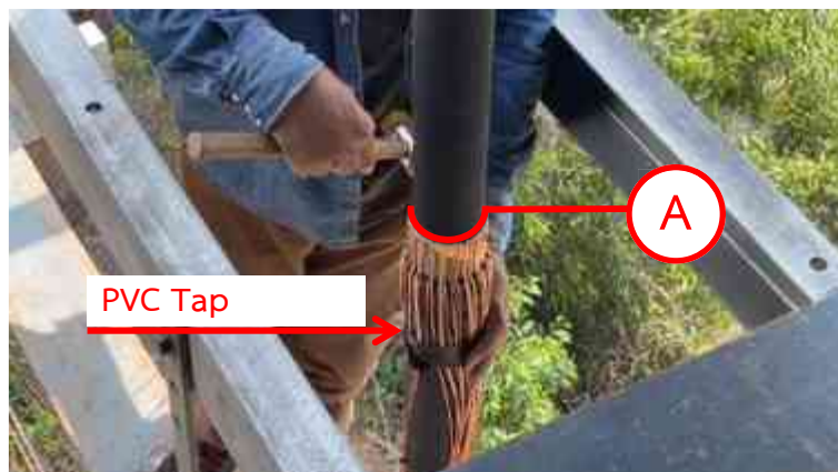
รูปที่ 4.57 พับสายทองแดง (Copper Wire Shield) ลง 180 องศา และใช้ค้อนเคาะให้เรียบไปตามผิวของ Copper Mesh และ Sealing Tap ได้ Mark A
