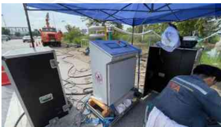
รูปที่ 4.115 การทดสอบแรงดันไฟฟ้ากระแสสลับ (AC Voltage Test) (3)
