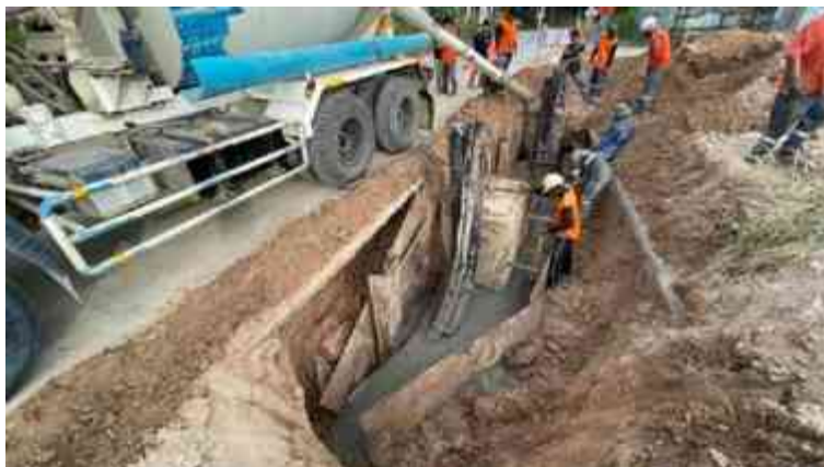
รูปที่ 4.10 การติดตั้งท่อ HDPE และคอนกรีตเพื่อป้องกันการเคลื่อนตัวของกลุ่มท่อ
