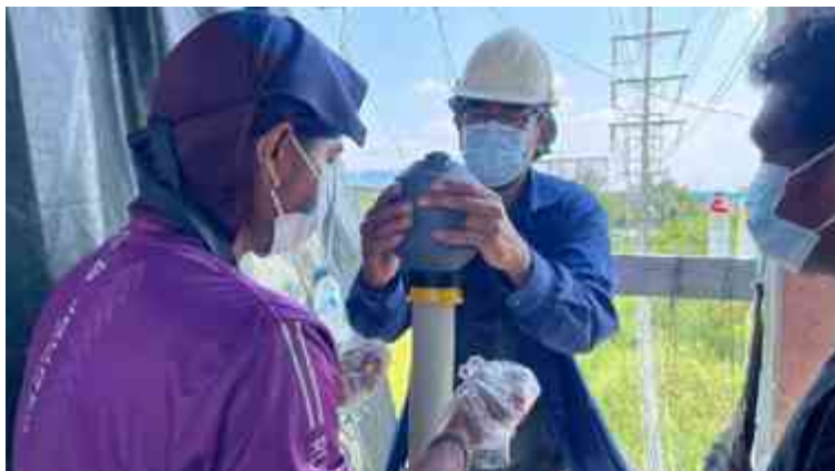
รูปที่ 4.80 ติดตั้ง Stress Cone ลงบนสายเคเบิล โดยสวมกรวยซิลิโคนที่ปลายสายเคเบิล เพื่อป้องกันความเสียหายที่จะเกิดขึ้นกับ Stress Cone
