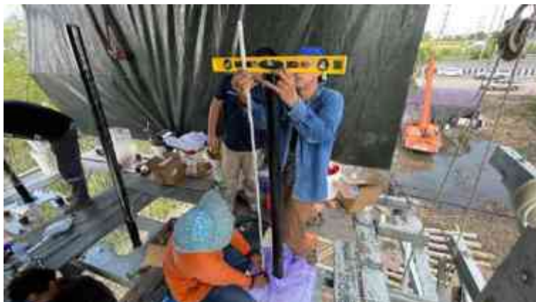
รูปที่ 4.69 ทำการวัดและตัดสายเคเบิลให้ได้ตามขนาด เพื่อเตรียมการขุดผิวถนน (2)
