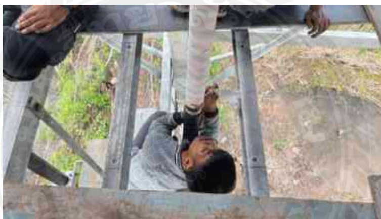
รูปที่ 4.55 นำเอาเทปกั้นน้ำออกและเทปสปริงออก จากการพันไว้ใน รูปที่ 4.50
