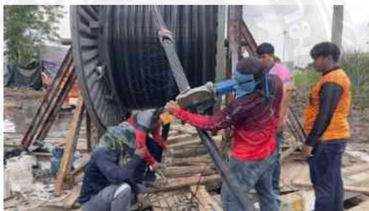
รูปที่ 4.30 การตัดสายเคเบิลที่ได้ตามระยะที่กำหนด
