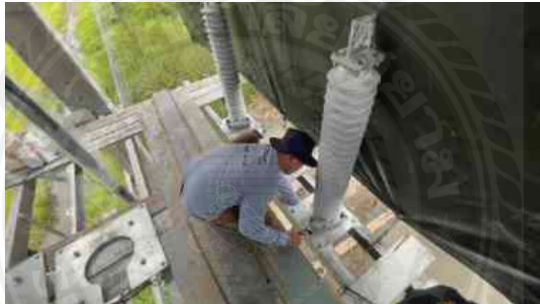
รูปที่ 4.107 ติดตั้งชุดกับดักเสิร์จแรงสูง (3)
