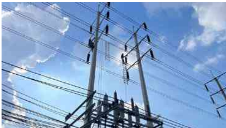
รูปที่ 4.121 เชื่อมต่อสายเคเบิลใต้ดินเข้ากับระบบสายส่งเหนือพื้น 115 กิโลโวลต์ (2)
