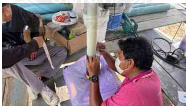
รูปที่ 4.74 ขัดช่วงรอยต่อระหว่างฉนวนและสกรีนฉนวนให้ได้ความชัน (1)
