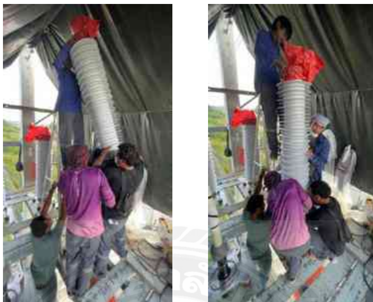
รูปที่ 4.92 ติดตั้งฉนวนภายนอกของชุดต่อปลายสาย Termination (1)
