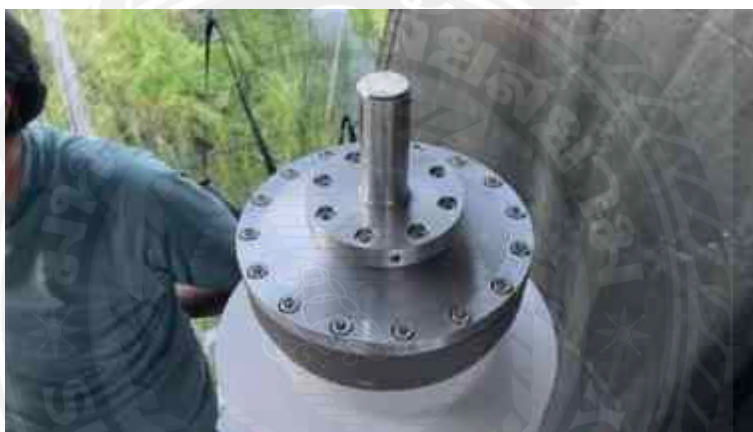
ปที 4.101 ติดตั้งซีลส่วนบนที่ Connection Bolt ของชุดต่อปลายสาย Termination (3)
