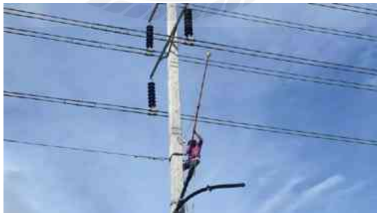
รูปที่ 4.36 ดำเนินการตรวจสอบแรงดันไฟฟ้าในระบบ (1)
