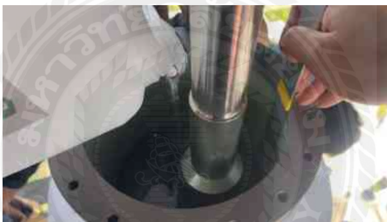
รูปที่ 4.95 เติมฉนวนน้ำมันลงในชุดต่อปลายสาย Termination (2)
