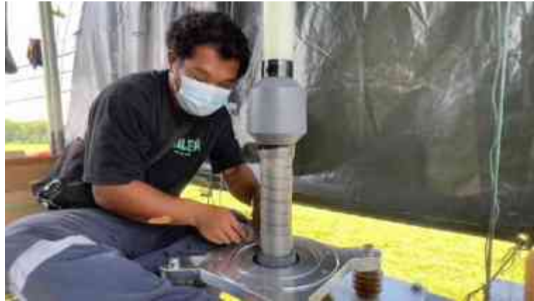
รูปที่ 4.83 พันด้วย Copper Mesh ทับ SB Tape SD
