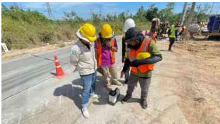
รูปที่ 4.6 การตรวจสอบตำแหน่งของหัวนำเจาะ
