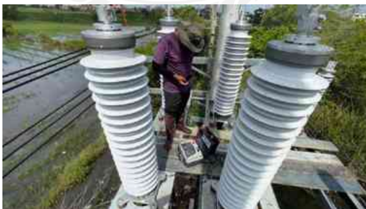
รูปที่ 4.112 การทดสอบความต้านทานฉนวน ก่อนการทดสอบแรงดันไฟฟ้ากระแสสลับ
