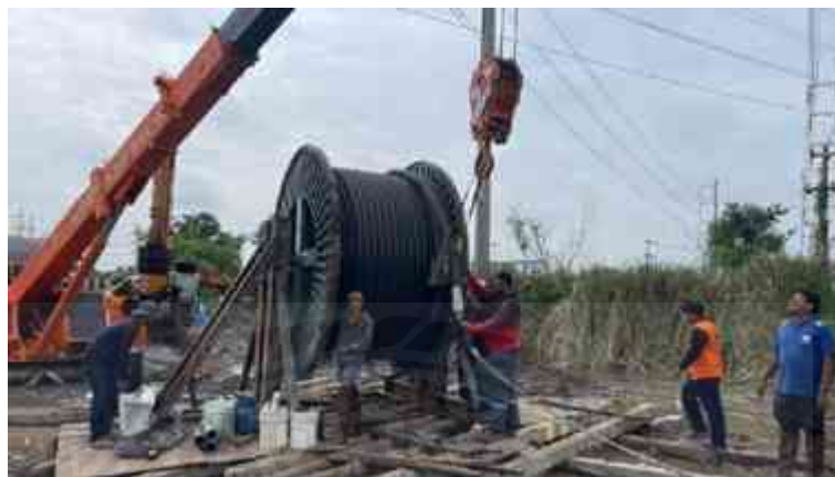
รูปที่ 4.23 การติดตั้งเชือกเข้ากับเครื่องช่วยดึงสายเคเบิลและปลายสายเคเบิลที่ประกอบไว้กับ Pulling Head และประกอบด้วย สวีเวล (Swivel)
