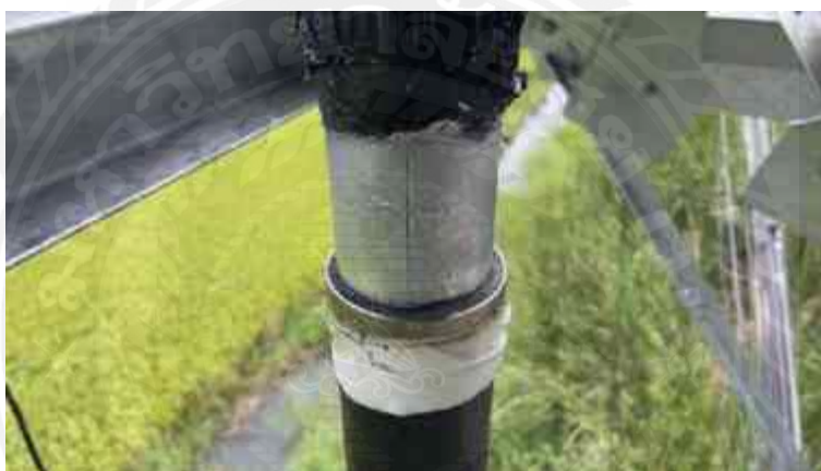
รูปที่ 4.52 ทำความสะอาดชั้นอะลูมิเนียมเคลือบโคโพลีเมอร์
