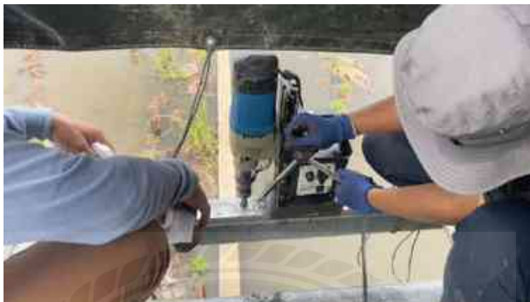
รูปที่ 4.103 การเจาะรูเพื่อยึด Baseplate
