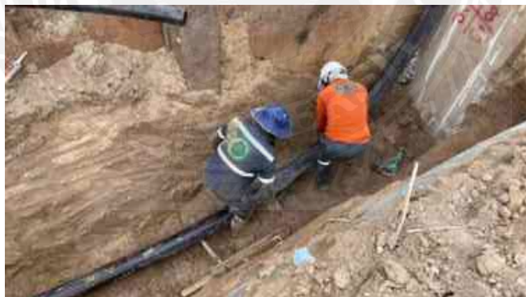
รูปที่ 4.9 การติดตั้งท่อ Elbow 90° เข้ากับเสาขึ้นสายเคเบิลใต้ดินระบบ 115 กิโลโวลต์ (Riser Pole)
