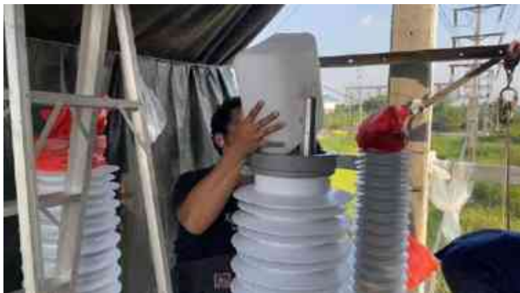
รูปที่ 4.94 เติมฉนวนน้ำมันลงในชุดต่อปลายสาย Termination (1)
