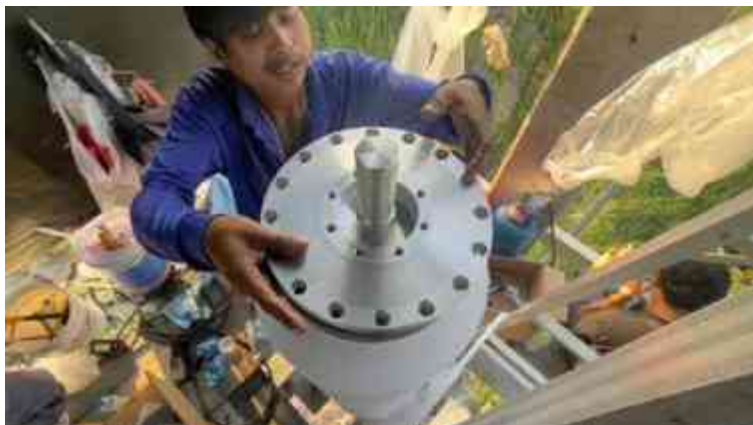
รูปที่ 4.97 ติดตั้งซีลส่วนบนของฉนวนชุดต่อปลายสาย Termination (1)
