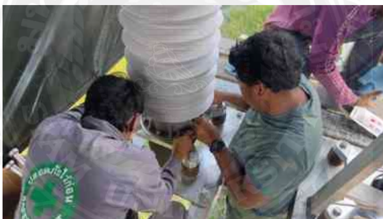
รูปที่ 4.93 ติดตั้งฉนวนภายนอกของชุดต่อปลายสาย Termination (2)
