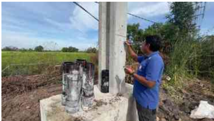
รูปที่ 4.17 การทำสัญลักษณ์ลำดับเฟส สำหรับการติดตั้งสายเคเบิลใต้ดิน (1)
