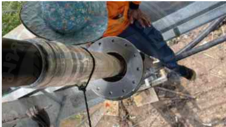
รูปที่ 4.61 สวมชุดปิดท้าย Cable Gland
