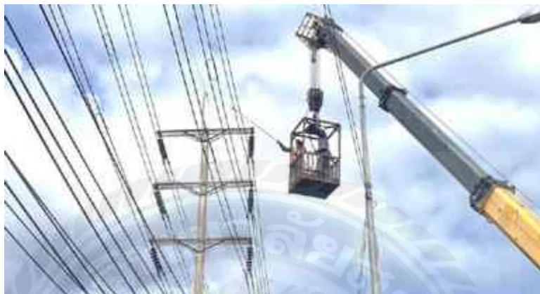
รูปที่ 4.119 ทำการตรวจสอบแรงดันไฟฟ้าในระบบก่อนปฏิบัติงานเชื่อมต่อสายเคเบิลใต้ดินเข้ากับระบบสายส่งเหนือพื้น 115 กิโลโวลต์
