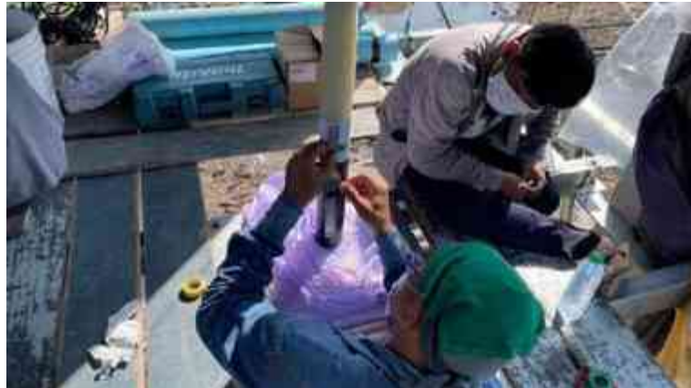
รูปที่ 4.77 ทำเครื่องหมายระยะการติดตั้ง Stress Cone
