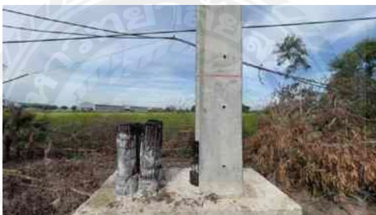
รูปที่ 4.18 การทำสัญลักษณ์ลำดับเฟส สำหรับการติดตั้งสายเคเบิลใต้ดิน (2)
