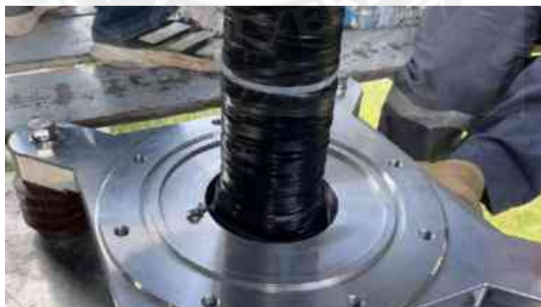
รูปที่ 4.85 รัดด้วย Cable Tie เพื่อลดช่องว่างในการพันเทป ลดการเกิด Partial Discharge
