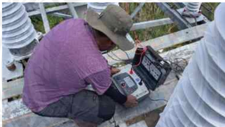
รูปที่ 4.117 การทดสอบความต้านทานฉนวน หลังการทดสอบแรงดันไฟฟ้ากระแสสลับ
