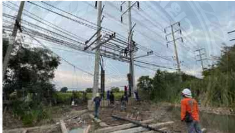
รูปที่ 4.34 การจับยึดสายเคเบิลเข้ากับโครงสร้างของเสาขึ้นสายเคเบิลใต้ดิน (2)
