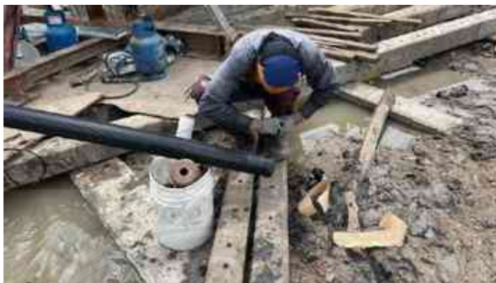
รูปที่ 4.31 การพันปิดปลายสายเคเบิลใต้ดิน (Sealing End Cable) (1)
