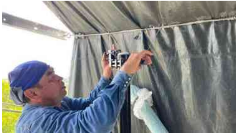
รูปที่ 4.60 พนักงานทำการลอกปลอกคมนวนและสกรีนฉนวน ก่อนการติดตั้ง Cable Gland
