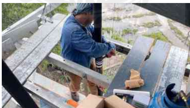
รูปที่ 4.59 พันด้วย Sealing Tap ทับ Copper Mesh ได้ Mark A
