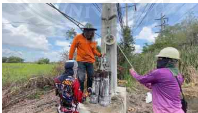
รูปที่ 4.16 การทดสอบสภาพของผนังท่อร้อยสายด้านใน โดยการใช้ลูก Dummy
