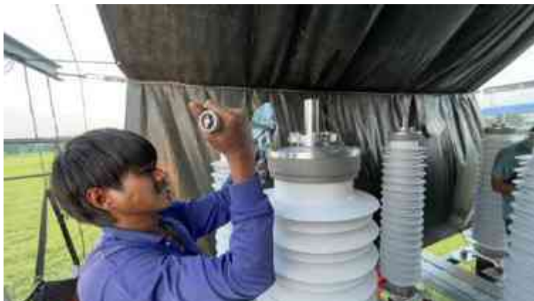
ปที 4.100 ติดตั้งซีลส่วนบนที่ Connection Bolt ของชุดต่อปลายสาย Termination (2)
