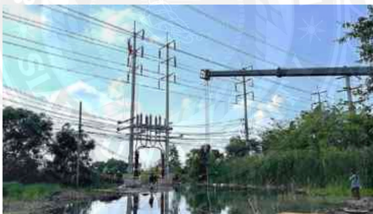
รูปที่ 4.120 เชื่อมต่อสายเคเบิลใต้ดินเข้ากับระบบสายส่งเหนือพื้น 115 กิโลโวลต์ (1)
