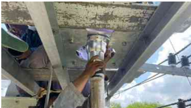
รูปที่ 4.66 ประกอบชุดปิดท้าย Cable Gland เข้ากับ Baseplate และใช้จารบี (ABF-Grease) ทาลงในช่องสกรูที่ Baseplate
