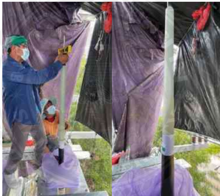
รูปที่ 4.76 วัดขนาดความยาวของตัวนำและระยะความยาวการติดตั้งชุดต่อปลายสาย
