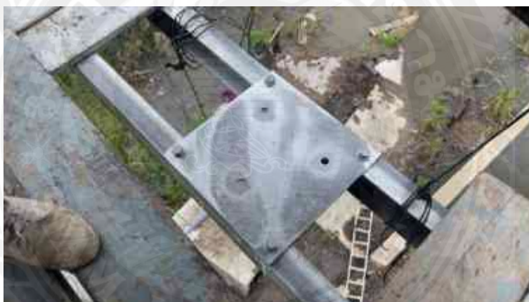
รูปที่ 4.104 จับยึด Baseplate เข้ากับโครงสร้างเสาขึ้นสายเคเบิลใต้ดิน
