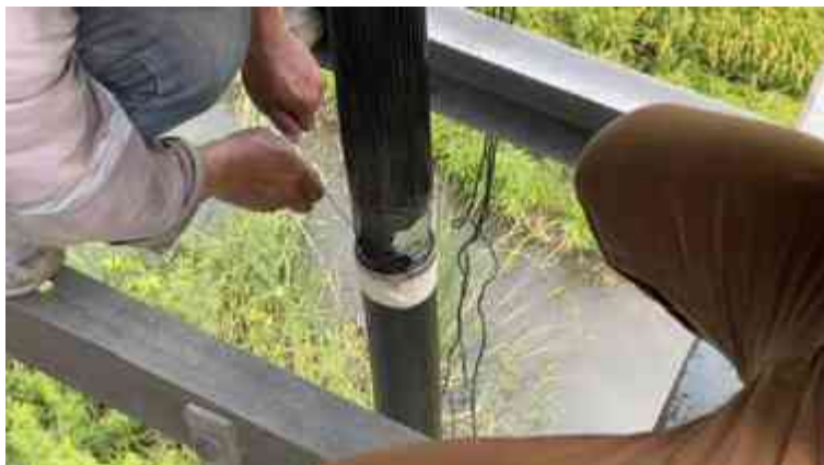
รูปที่ 4.51 การให้ความร้อนที่เปลือกสายและใช้เชือกตัดเอาเปลือกสายออก
