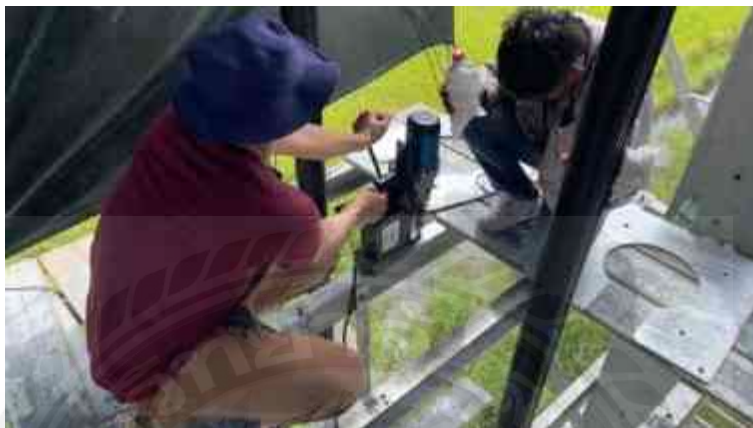
รูปที่ 4.47 การติดตั้งแผ่นเพลตรองรับชุดต่อปลายสายเคเบิล
