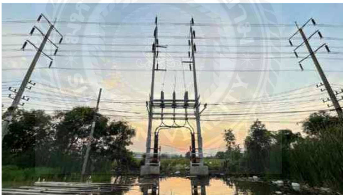
รูปที่ 2.110 การทดสอบความคงทนต่อแรงดันไฟฟ้ากระแสสลับ ระดับแรงดัน 115 กิโลโวลต์ เป็นเวลา 24 ชั่วโมง แบบไม่มีโหลด
