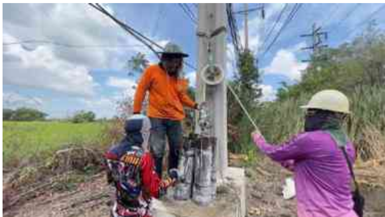
รูปที่ 2.85 ตัวอย่างการทำความสะอาด และทดสอบท่อย้อยสาย
