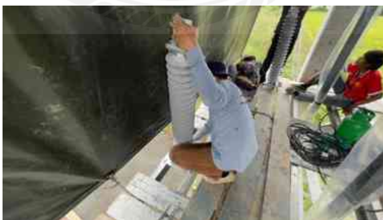
รูปที่ 4.105 ติดตั้งชุดกับดักเสิร์จแรงสูง (1)
