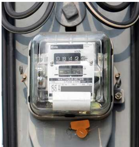
รูปที่ 4.2 การติดตั้งมิเตอร์ 1 เฟส 2 สาย
