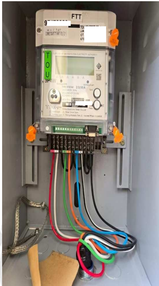
รูปที่ ค 5 ภาพการลงพื้นที่การติดตั้งมิเตอร์
