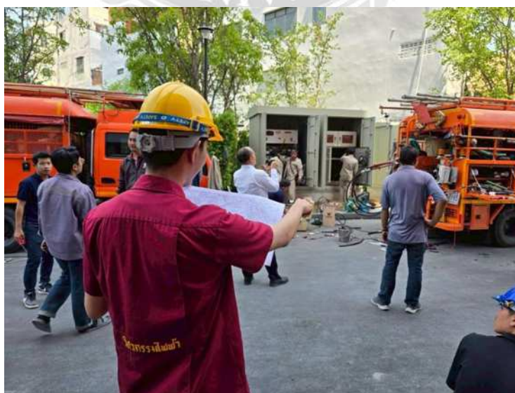
รูปที่ 3.47 การดูงานร้อยสายใต้ดินต่อเข้ากับตู้ไฟ
