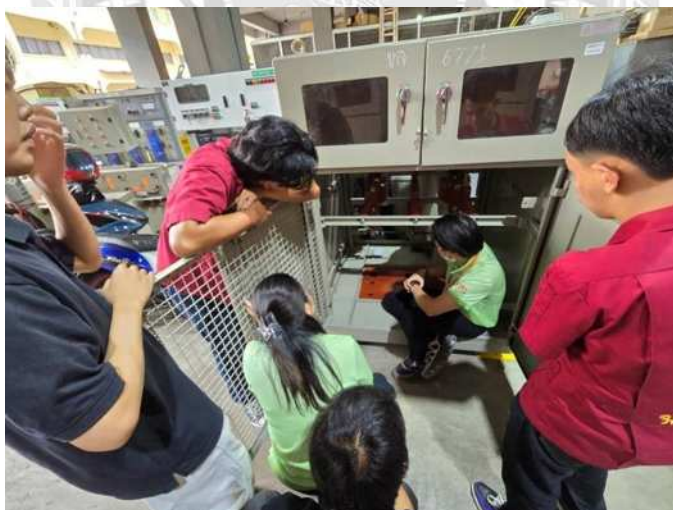
รูปที่ 3.45 คูงานการติดตั้ง VT ภายในตู้
