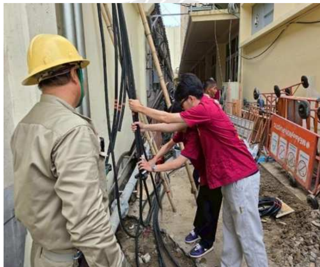
รูปที่ ค 4 ภาพการลงพื้นที่การติดตั้งมิเตอร์
