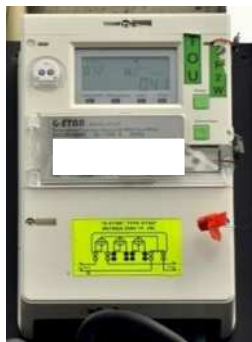
รูปที่ 2.7 เครื่องวัดหน่วยไฟฟ้าแบบดิจิทัล TOU
