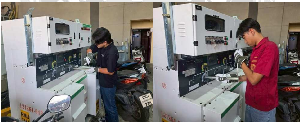
รูปที่ ค 2 การลับสวิตช์และสับโหลดของตู้ Ring main unit
