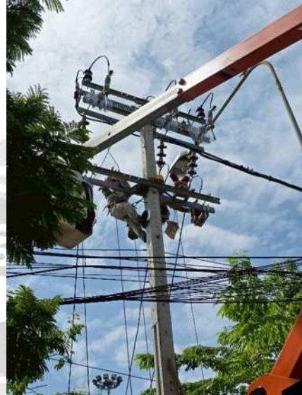
รูปที่ 3.22 ติดตั้ง CT แรงกลางบนเสาไฟฟ้า
