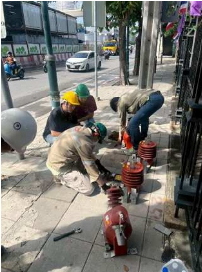
รูปที่ 3.21 การตรวจเช็ค CT ก่อนติดตั้ง
