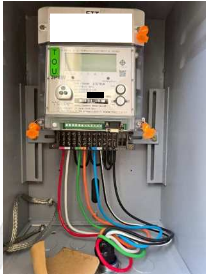
รูปที่ 3.29 การต่อสายเข้ามิเตอร์ตามมาตรฐานไฟฟ้า
