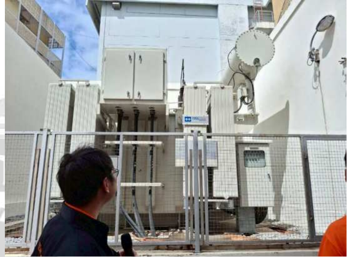
รูปที่ 3.26 ดูหม้อแปลงไฟฟ้าแรงสูง
