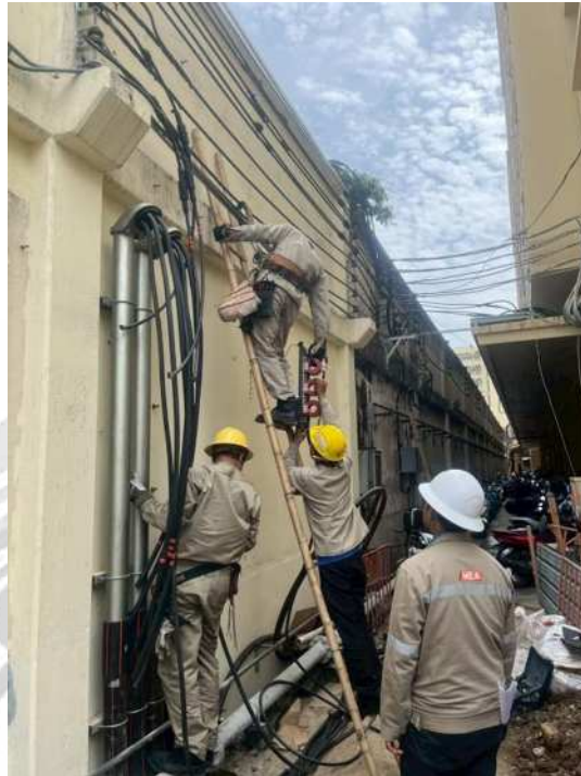
รูปที่ ค 1 ดูการติดตั้ง CT แรงกลางและมิเตอร์ของพีพีสถาบันการไฟฟ้า
