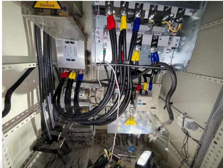
รูปที่ 4.2.6 วางเรียงสายเข้าอินเวอร์เตอร์
