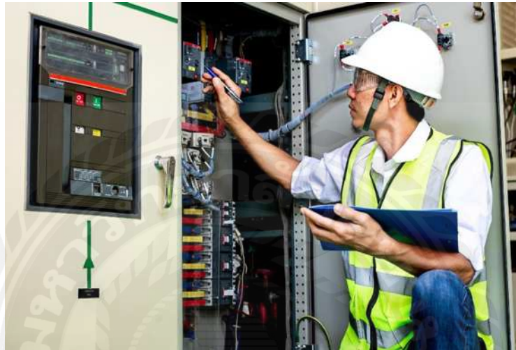
รูปที่ 2.7.2 ขั้นตอนที่ 2 การเดินสายไฟ
