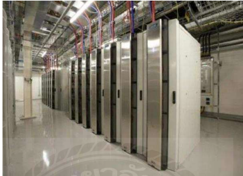
รูปที่ 2.4.7 ระบบระบายความร้อน (Cooling System)
