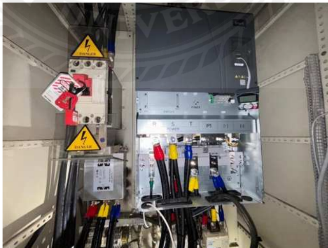
รูปที่ 4.2.5 เริ่มเอาเครื่องตัวใหม่ติดตั้ง
