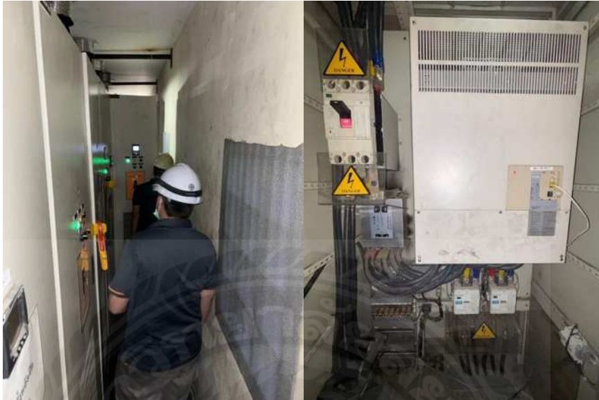
รูปที่ 4.2.2 สำรองพื้นที่ และประเมินหน้างาน
