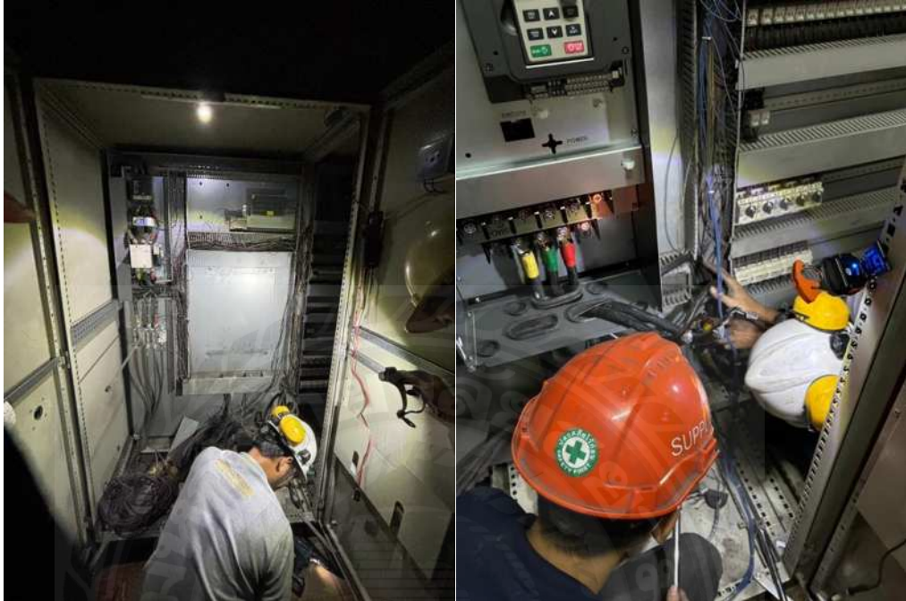
รูปที่ 4.2.4 ทำการถอดและติดตั้งใหม่
