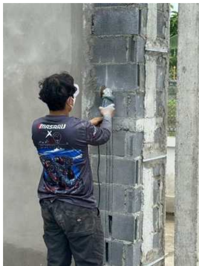
รูปที่ 4.3 การกรีดผนังฝังท่อไฟกึ่งนอกอาคาร
