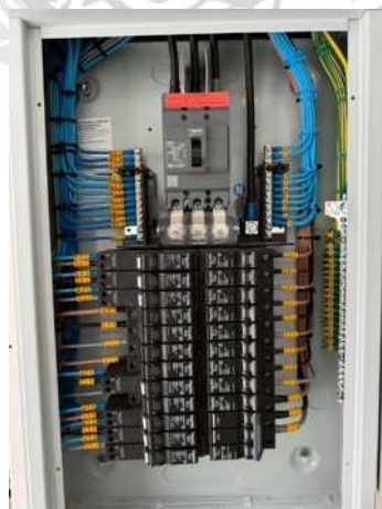
รูปที่ 4.1 การแยกวงจรระบบไฟฟ้าภายใน และ ภายนอกอาคาร
