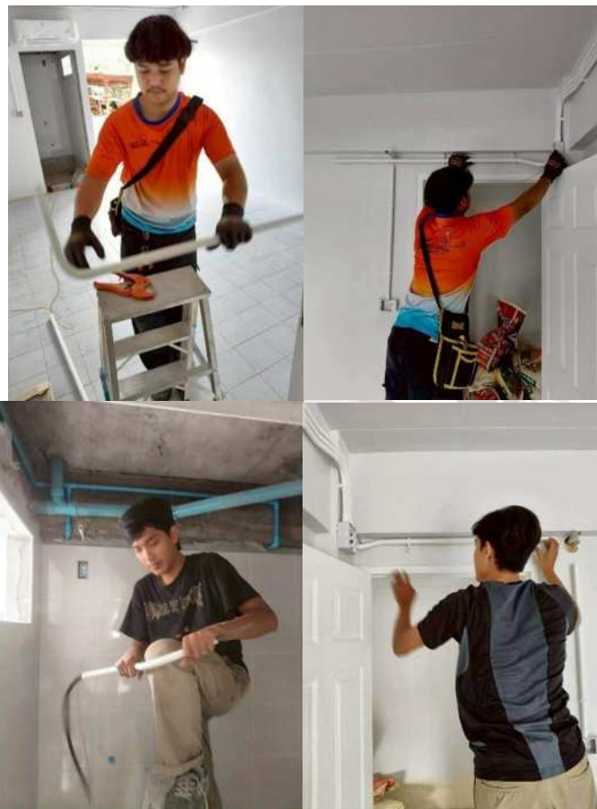
รูปที่ 3.13 การตัดท่อระบบไฟฟ้า
