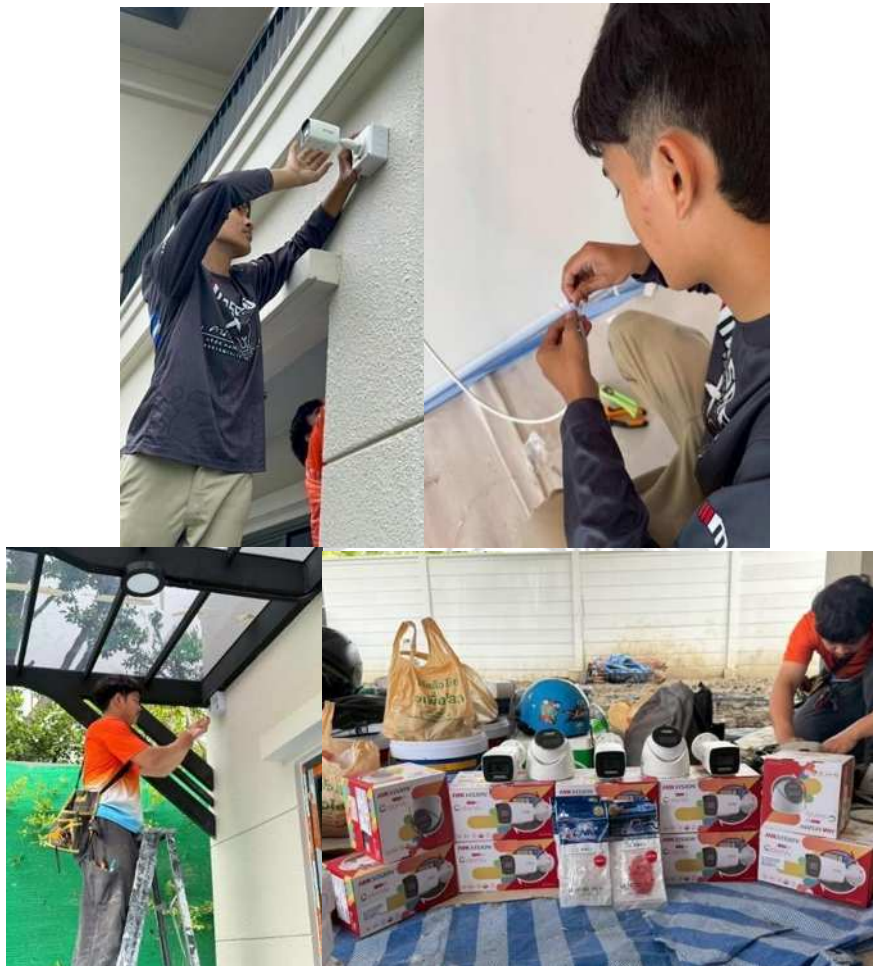
รูปที่ 3.16 การติดตั้งกล่องวงจรปิดและย่ำหัวสายแลน
