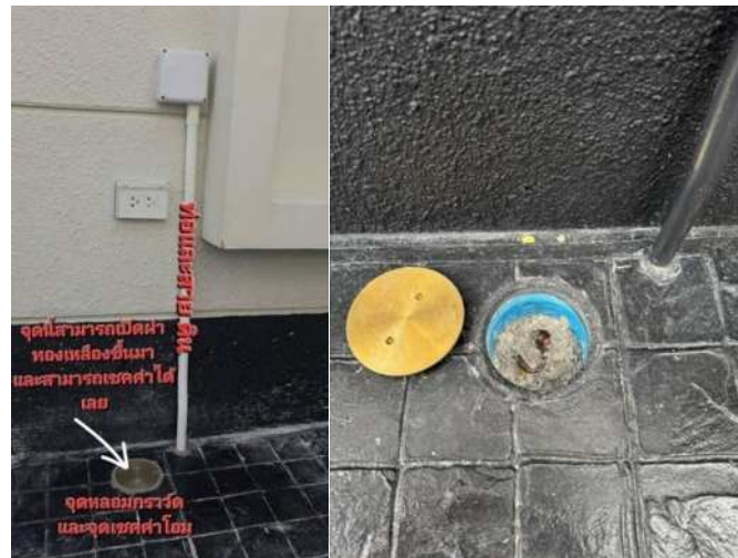
รูปที่ 3.19 การทำระบบกราวด์
