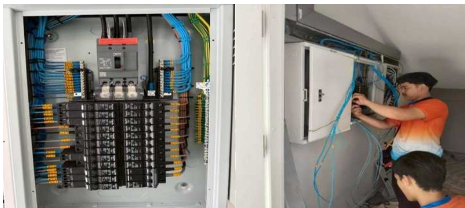
รูปที่ 3.15 การเข้าตู้ไฟ 3 เฟส
