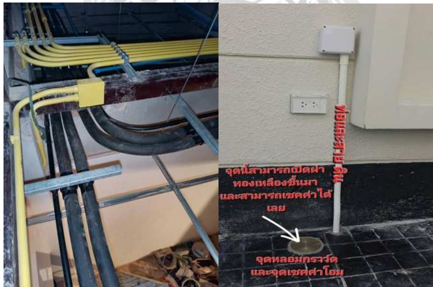
การติดตั้งระบบไฟฟ้าตามที่ออกแบบไว้
