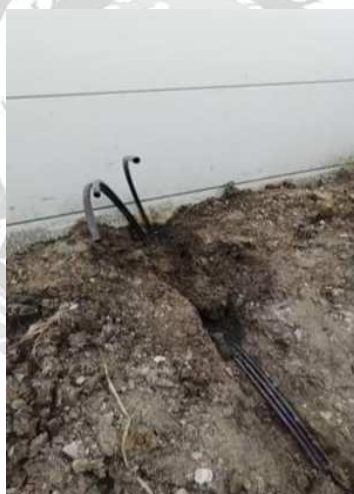
รูปที่ 4.2 การขุดฝังท่อHDPEระบบไฟฟ้าภายนอกอาคาร
