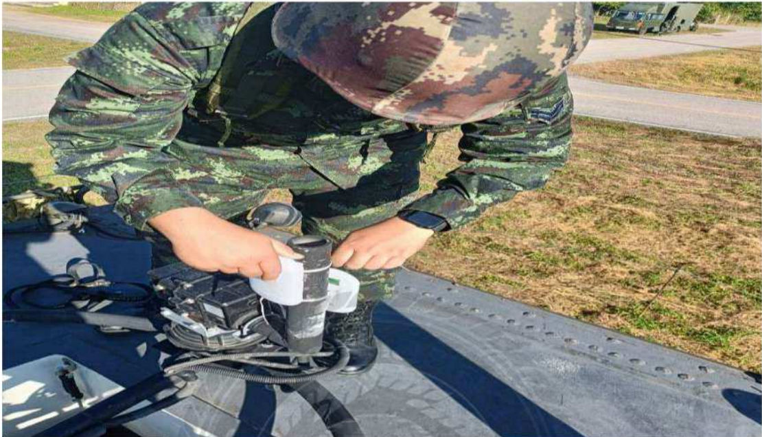
รูปที่ 4.10 การติดตั้งเครื่องมือสื่อสารในแต่ละชุด
