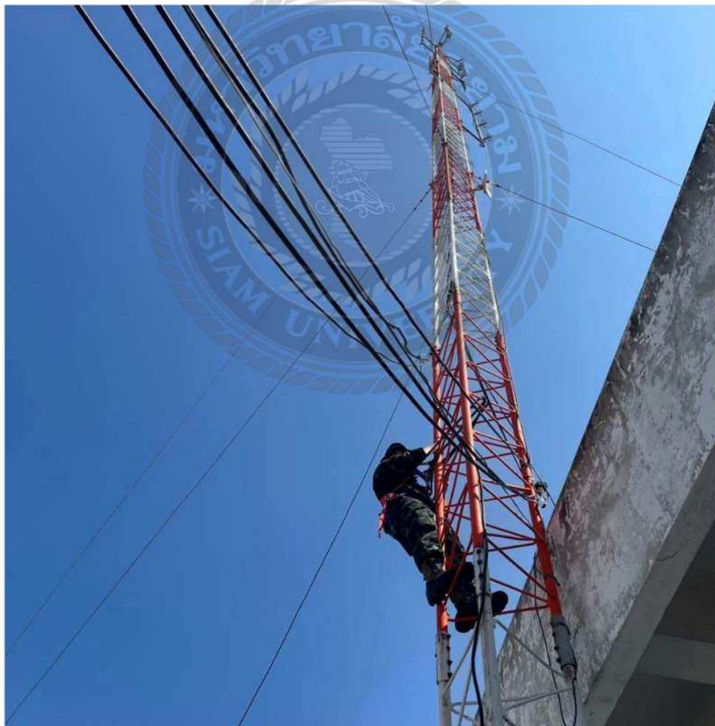
รูปที่ 4.4 ติดตั้งงาน WIMAX
