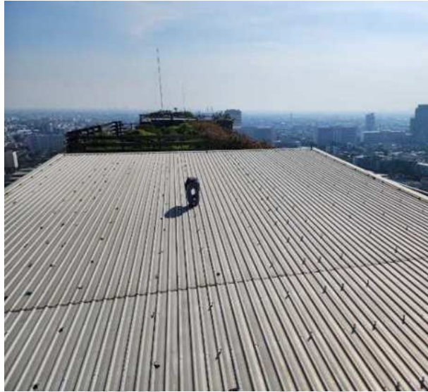
รูปที่ 4.3 ยึดติดตั้ง แอลพีด (L-feet)
