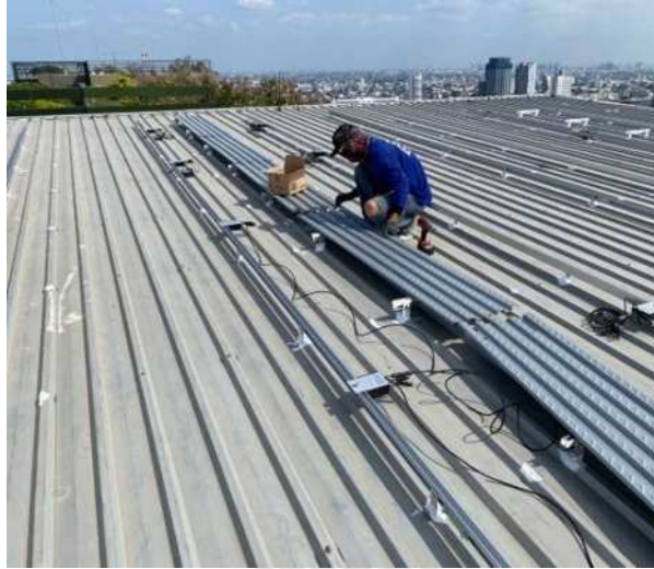
รูปที่ 4.5 ติดตั้งทางเดินบนหลังคา
