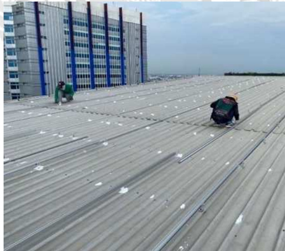
รูปที่ 4.4 ติดตั้งรางเข้ากับL-feet
