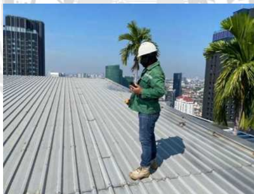
รูปที่ 4.1 สำรวจพื้นที่หน้างาน
