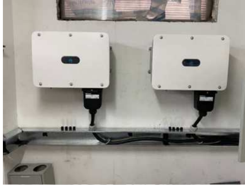
รูปที่ 4.9 ติดตั้งอินเวอร์เตอร์
