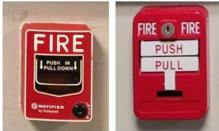
รูปที่ 2.16 อุปกรณ์เริ่มสัญญาณแบบมือดึงจากบุคคล (Manual Pull Station) แบบดึงหรือบิดกุญแจ
