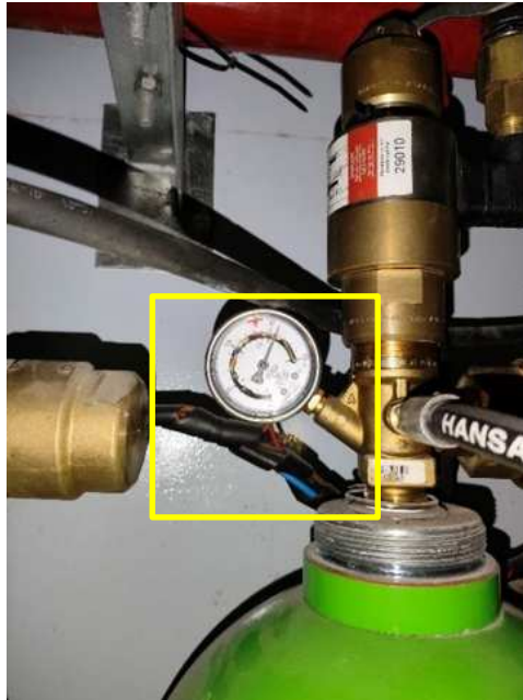
รูปที่ 4.10 ตรวจสอบการรั่วที่ตัวถัง
