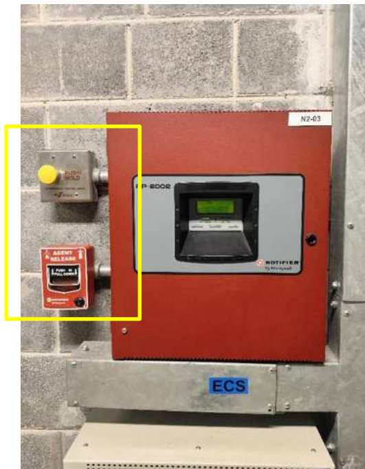
รูปที่ 4.13 ตรวจสอบสิ่งกีดขวางของการปฏิบัติการอุปกรณ์ระบบ N 2 (Manual Release & Abort Switch)
