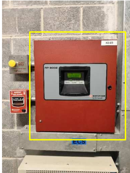
รูปที่ 4.16 ตรวจสอบสิ่งกีดขวางของการปฏิบัติการอุปกรณ์ระบบ N 2 (ผู้ควบคุม)
