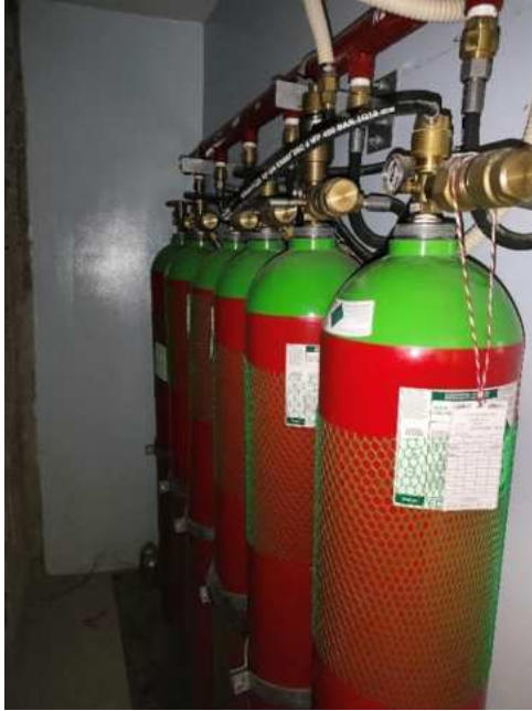
รูปที่ 4.12 ตรวจสอบสิ่งกีดขวางของการปฏิบัติการอุปกรณ์ระบบ N 2 (ถัง N 2 )
