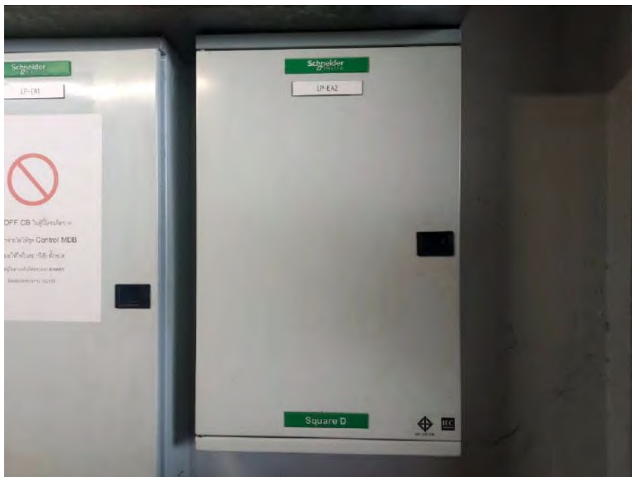
รูปที่ 4.4 ตัวอย่างอุปกรณ์ Distribution Board ( DB )
