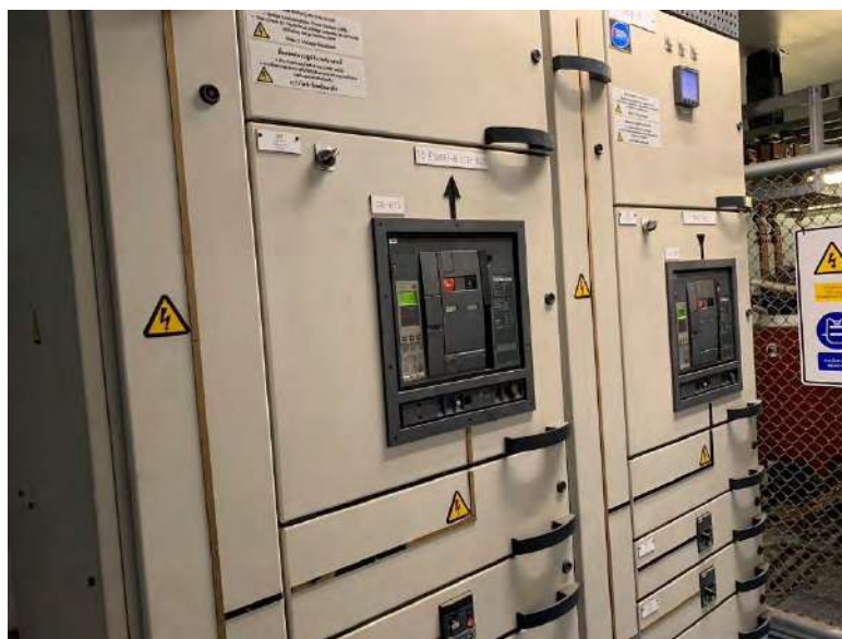
รูปที่ 4.6 ตัวอย่างอุปกรณ์ MDB ( Main Distribution Board )
