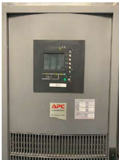
รูปที่ 4.5 ตัวอย่างอุปกรณ์ Uninterruptible Power Supply ( UPS )
