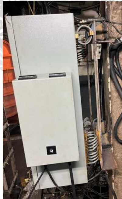
รูปที่ 4.7 โครงสร้างจับยึดตู้ควบคุมเครื่องกำเนิดไฟฟ้าที่ได้รับการติดตั้ง
