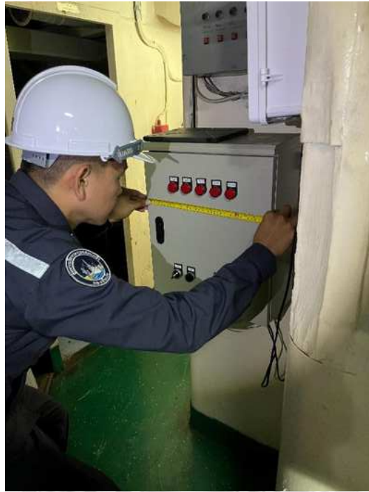
รูปที่ 3.11 ตรวจสอบการติดตั้งตู้ควบคุม
