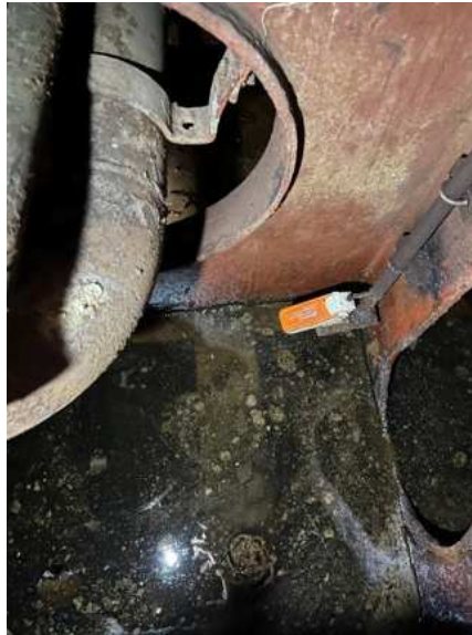
รูปที่ 4.4 สวิตช์ลुकลอย Float Switch ที่ได้รับการติดตั้ง
