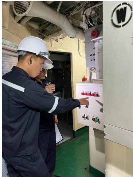
รูปที่ 3.13 ทดสอบการทำงานของตู้ควบคุม
