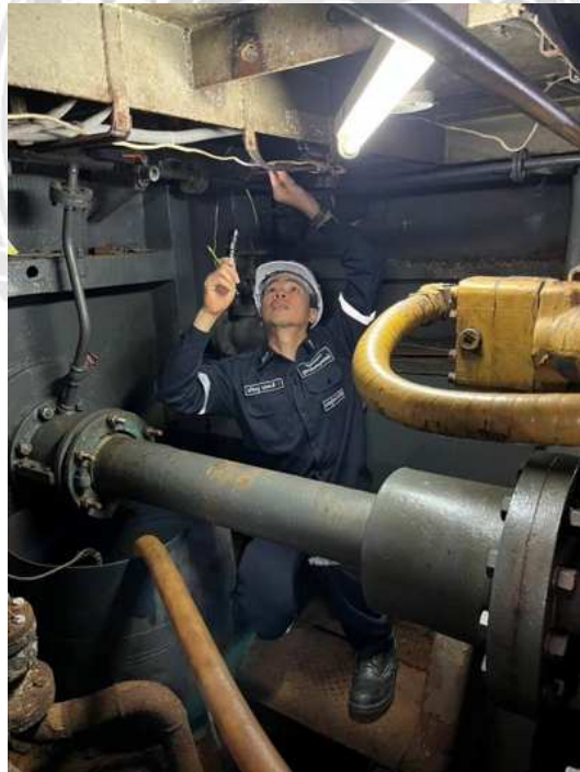
รูปที่ 3.8 ดำเนินการสำรวจช่องทางการเดินสายไฟไปยังอุปกรณ์
