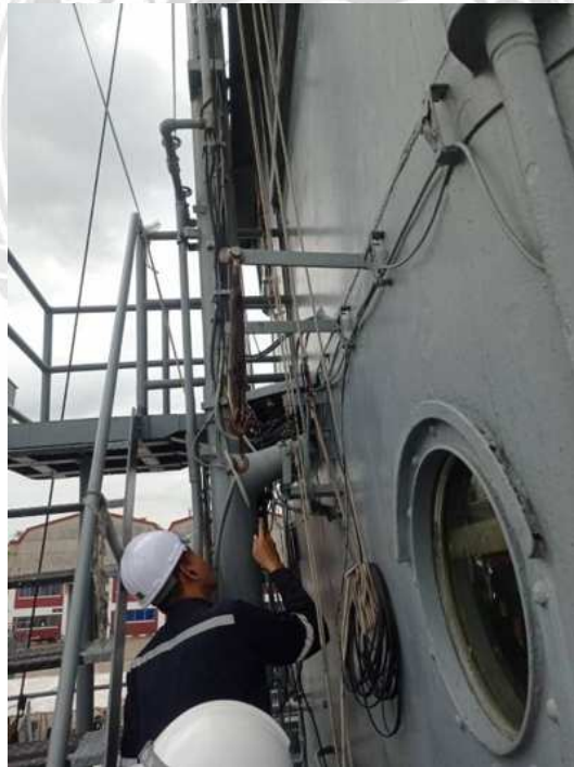
รูปที่ 3.12 ควบคุมการเดินสายไฟจากตู้ควบคุมไปยังไฟเตือนบนเสากระโดงเรือ
