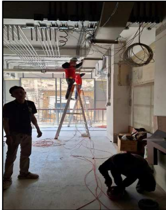
รูปที่ 3.7 ทำการติดตั้งท่อร้อยสายไฟ
