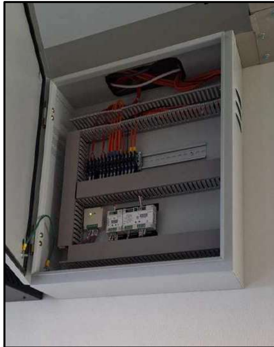
รูปที่ 3.11 ทำการติดตั้ง Module
