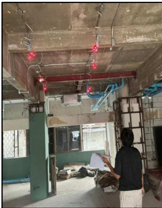
รูปที่ 3.8 ตรวจสอบความถูกต้องของการติดตั้งและความเรียบร้อยของสายสัญญาณ
