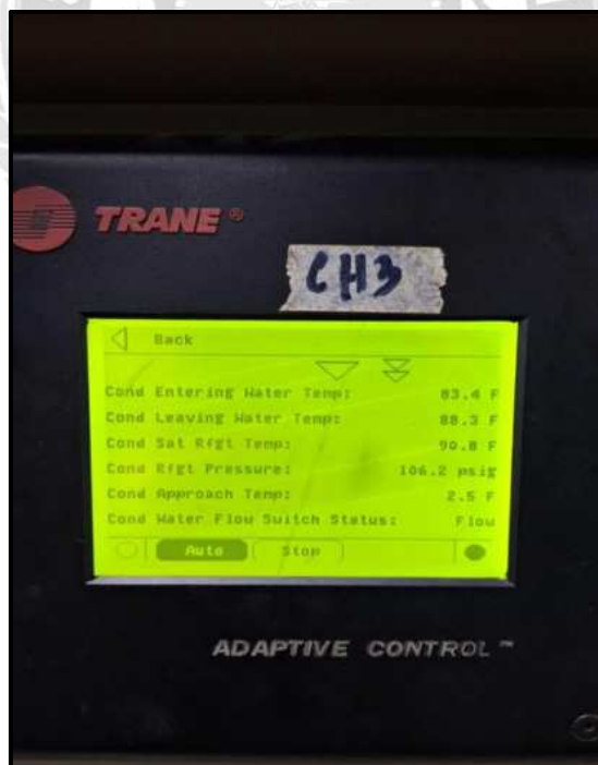
รูปที่ 3.28 ตรวจสอบและบันทึกค่าอุณหภูมิ และแรงดันต่าง ๆ ของระบบ
