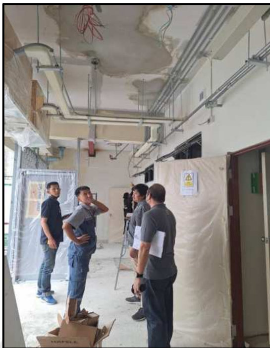
รูปที่ 3.6 รื้อถอนอุปกรณ์และระบบเดิมออก
