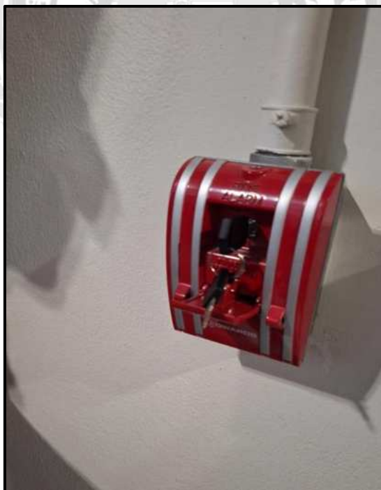
รูปที่ 3.18 ทำการทดสอบอุปกรณ์ปุ่มกดแจ้งเหตุเพลิงไหม้
