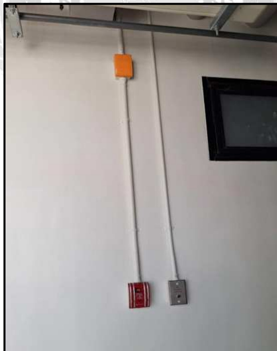
รูปที่ 3.10 ทำการติดตั้งอุปกรณ์แจ้งเตือนเสียงและแสง
