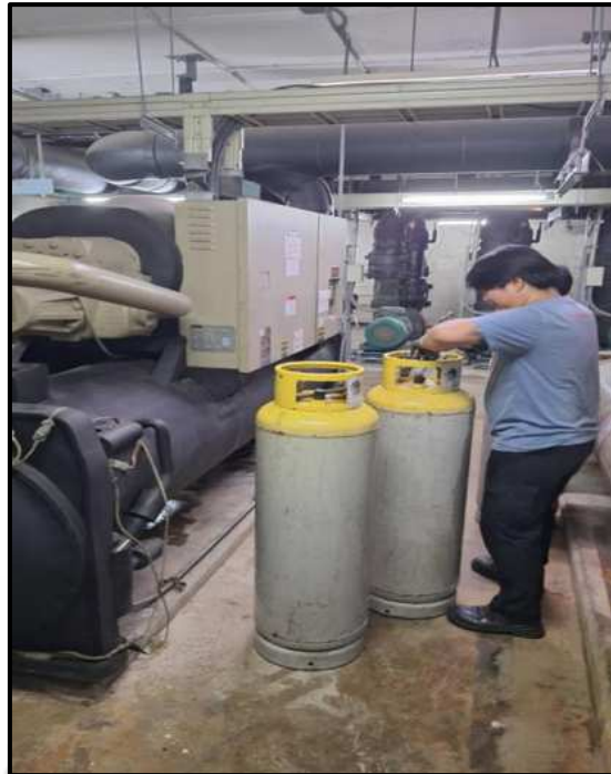
รูปที่ 3.27 ตรวจสอบสภาพเครื่องทั่วไป เช่น เสียง การสั่น และการรั่วซึมของน้ำหรือน้ำยา
