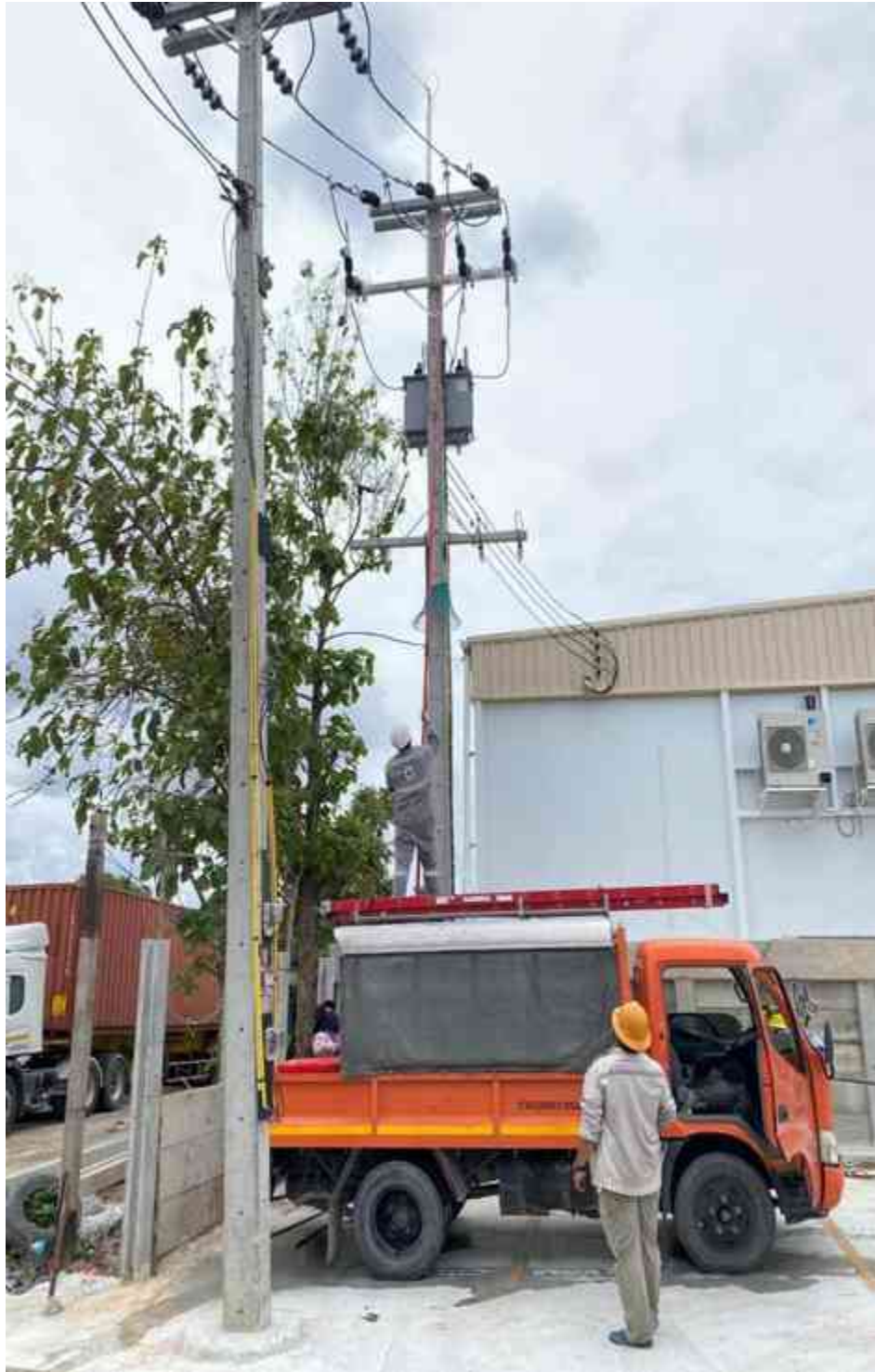
รูปที่ 3.109 ดำเนินการจ่ายไฟหลังการติดตั้งมิเตอร์แล้วเสร็จ
