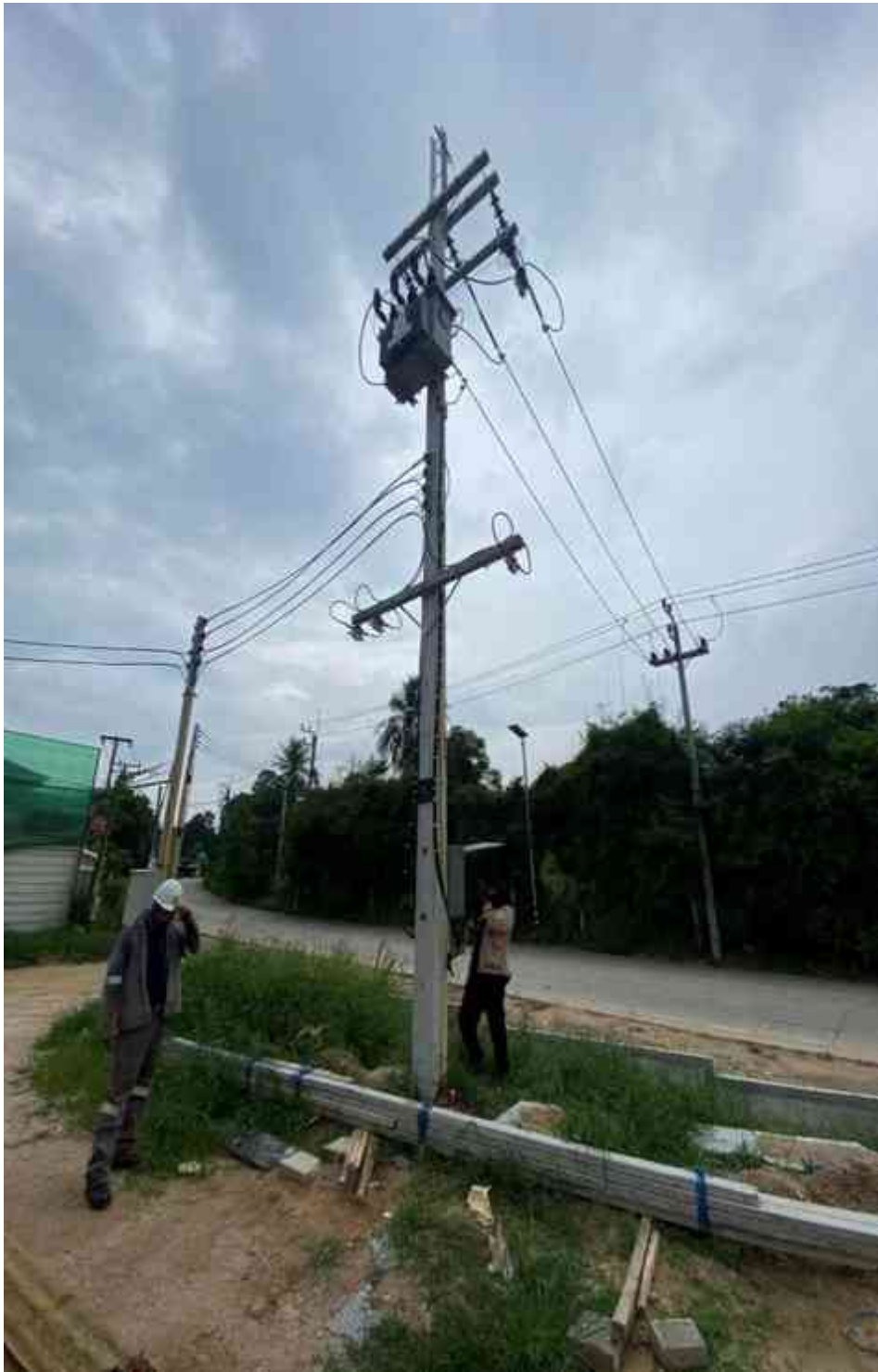
รูปที่ 3.104 ดำเนินการจ่ายไฟหลังการติดตั้งมิเตอร์แล้วเสร็จ
