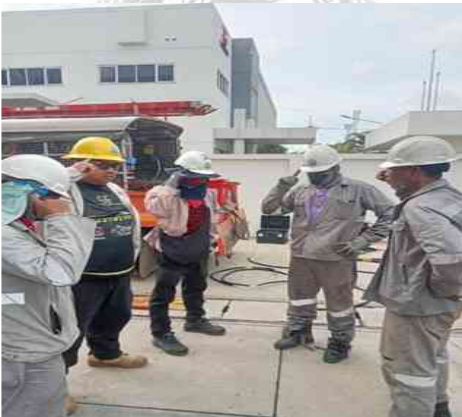
รูปที่ 3.155 การทำ KYT ก่อนเริ่มปฏิบัติงาน
