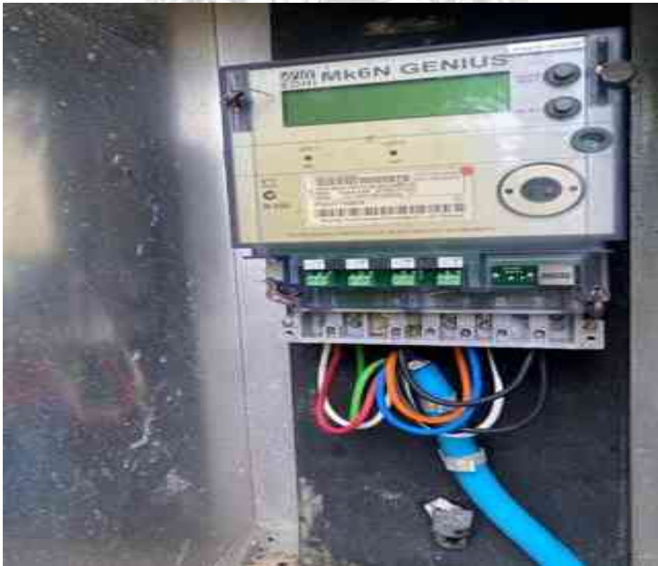
รูปที่ 3.141 ดำเนินแก้ไขสับเปลี่ยนอุปกรณ์ ซีที วีที ที่ชำรุด
