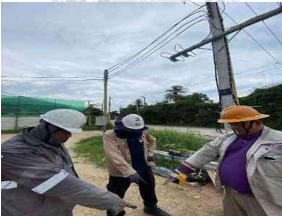
รูปที่ 3.102 การทำ KYT ก่อนเริ่มปฏิบัติงาน
