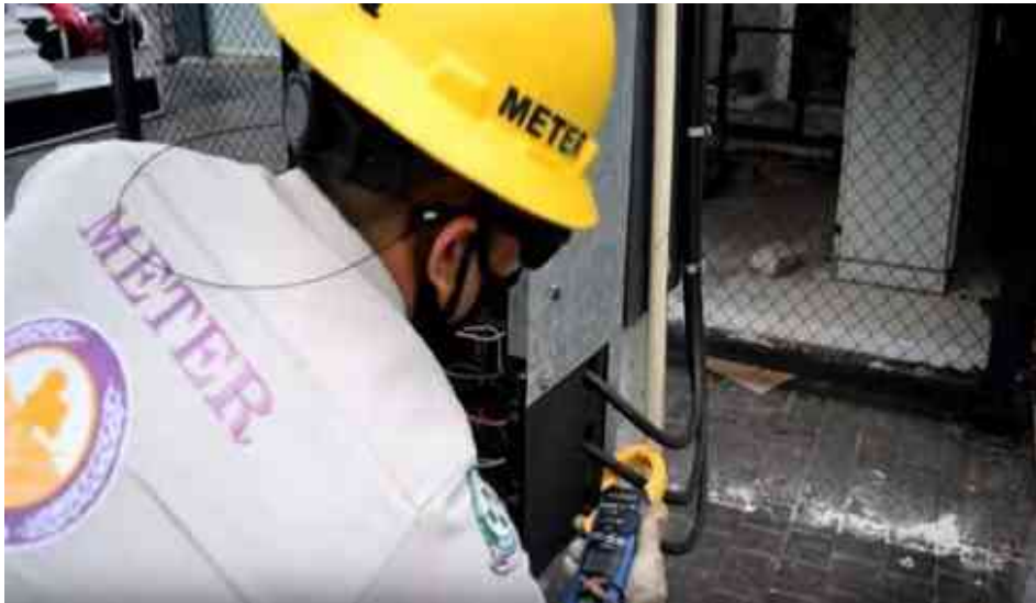
รูปที่ 3.47 ตัวอย่าง นำคลิปปอนกิโลวัตต์ปรับย่านวัดไปที่ W แล้วคล้องที่สายเฟส B
