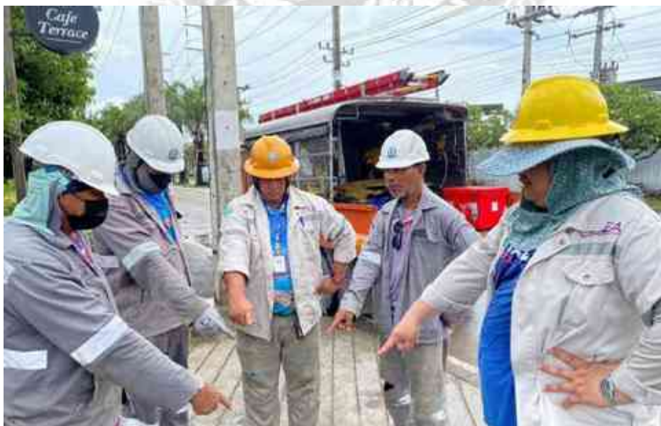
รูปที่ 3.94 การทำ KYT ก่อนเริ่มปฏิบัติงาน
