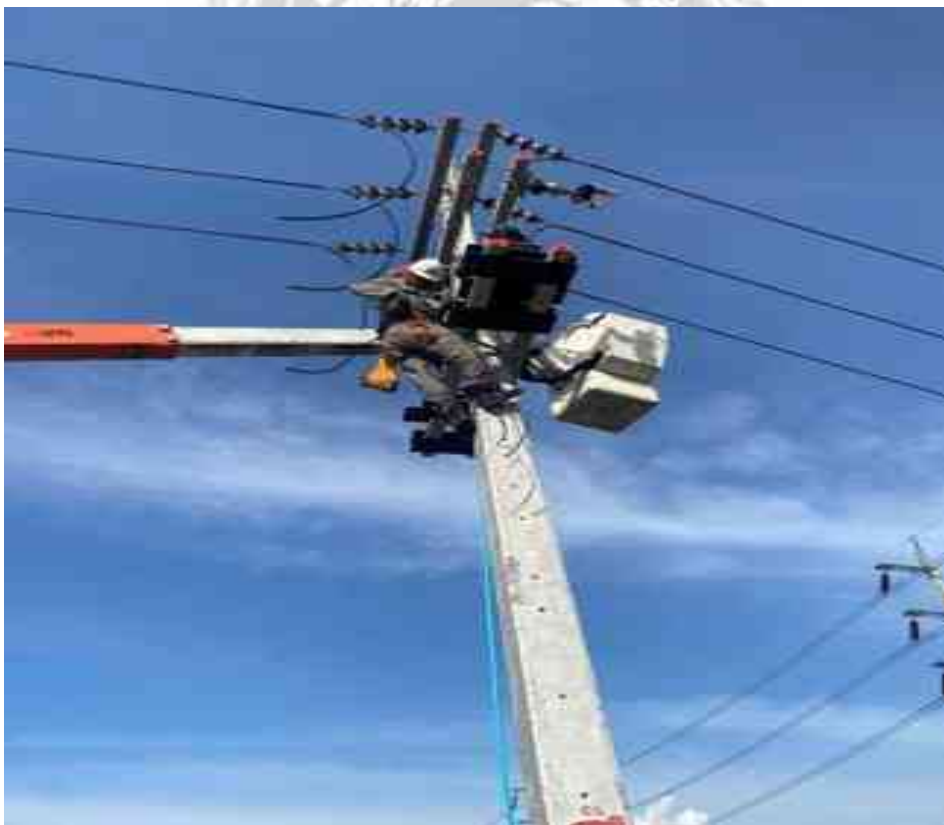
รูปที่ 3.152 ดำเนินการติดตั้ง มิเตอร์แบบประกอบ ซีที วีที แรงสูง 3 เฟส 3 สาย
