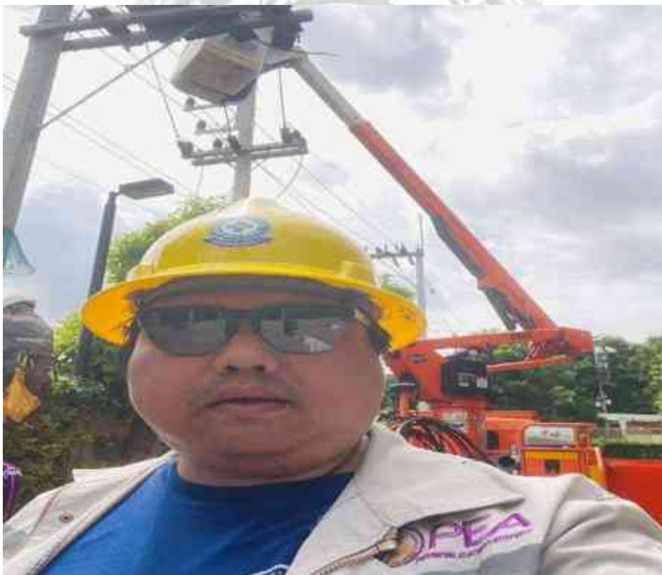
รูปที่ 3.132 ดำเนินแก้ไขสับเปลี่ยนอุปกรณ์ ซีที วีที ที่ชำรุด
