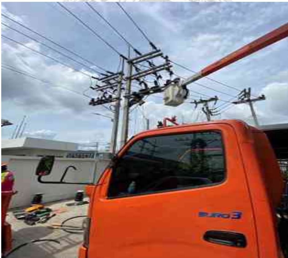
รูปที่ 3.156 ดำเนินการสับเปลี่ยนเครื่องวัดแรงสูง เพิ่มขนาด ซีที จาก 20/5 เป็น 50/5
