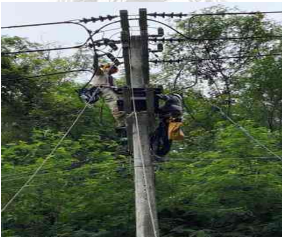
รูปที่ 3.140 ดำเนินแก้ไขสับเปลี่ยนอุปกรณ์ ซีที วีที ที่ชำรุด
