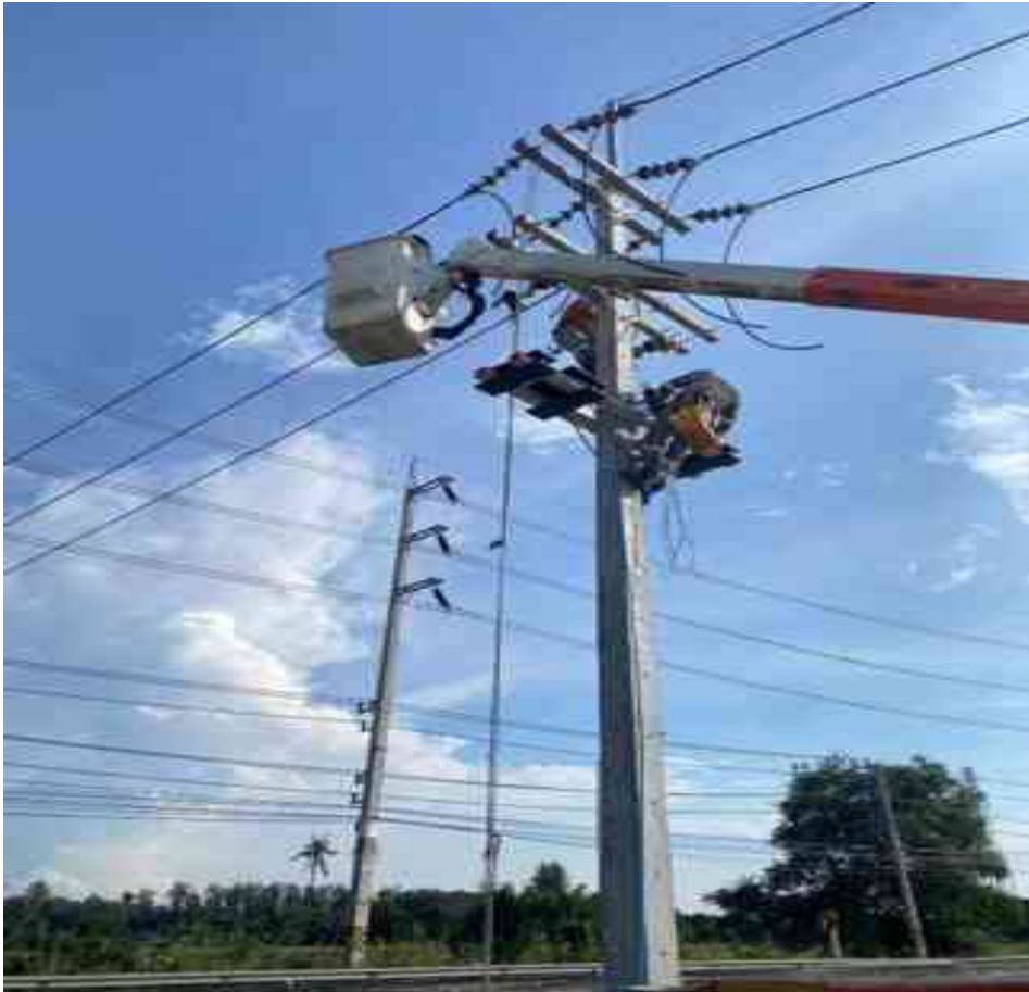
รูปที่ 3.151 ดำเนินการติดตั้ง มิเตอร์แบบประกอบ ซีที วีที แรงสูง 3 เฟส 3 สาย
