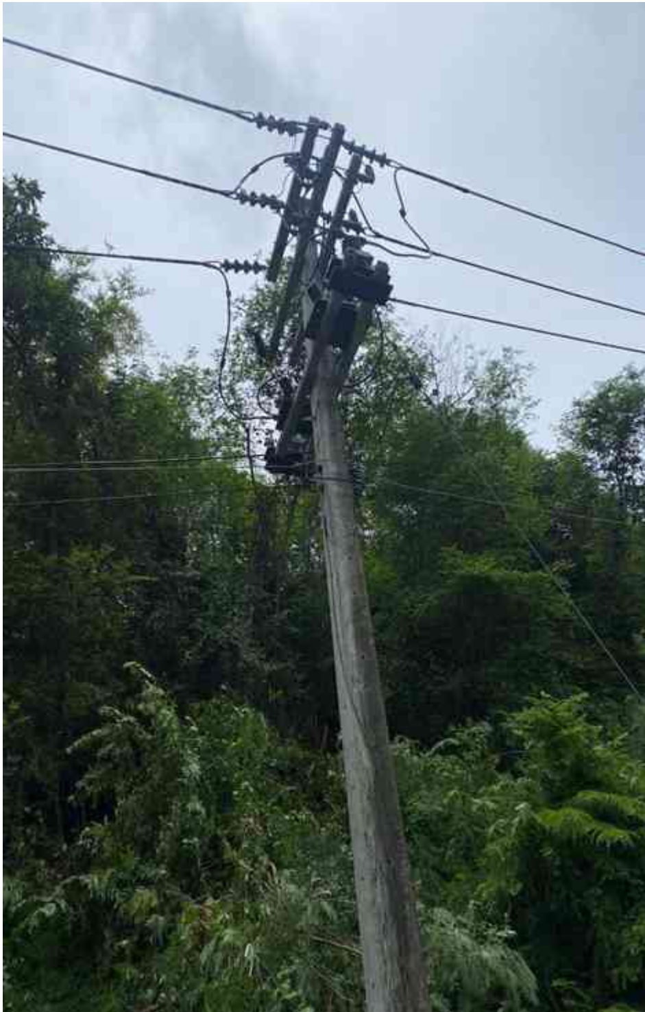
รูปที่ 3.142 ดำเนินการจ่ายไฟหลังการสับเปลี่ยนแล้วเสร็จ
