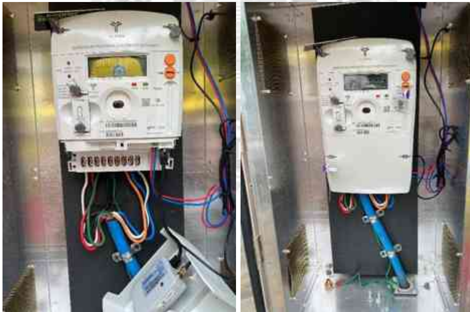
รูปที่ 3.159 ดำเนินการสับเปลี่ยนเครื่องวัดแรงสูง เพิ่มขนาด ซีที จาก 20/5 เป็น 50/5
