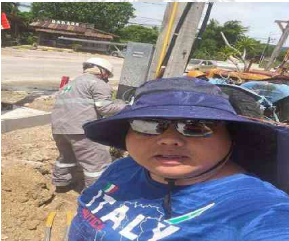
รูปที่ 3.99 การติดตั้งมิเตอร์และอุปกรณ์ประกอบ CT แรงต่ำ 3 เฟส 4 สาย
