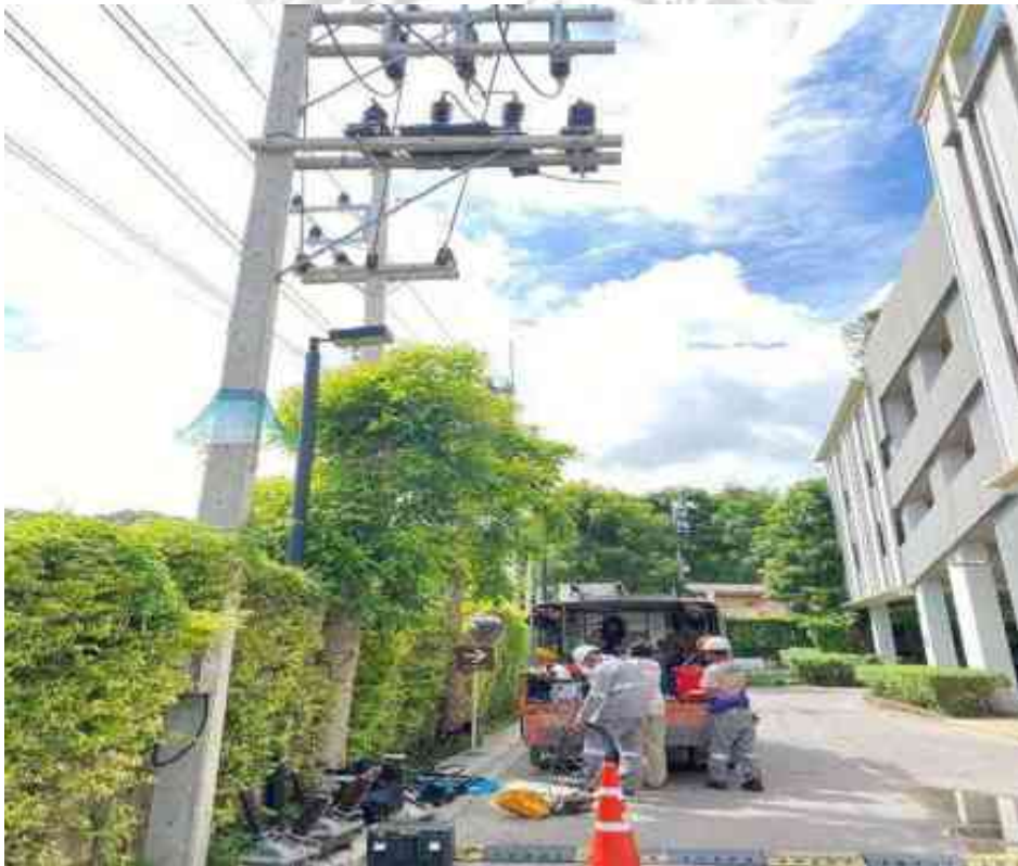
รูปที่ 3.131 ดำเนินแก้ไขสับเปลี่ยนอุปกรณ์ ซีที วีที ที่ชำรุด
