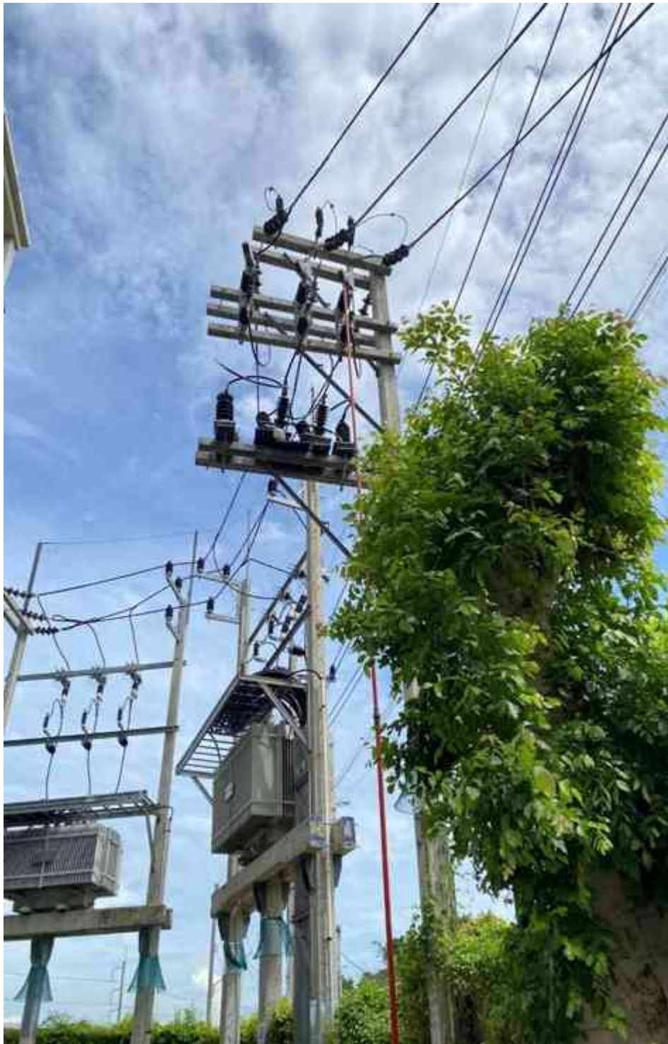
รูปที่ 3.134 ดำเนินการจ่ายไฟหลังการสับเปลี่ยนแล้วเสร็จ
