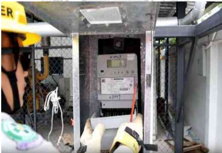
รูปที่ 3.42 ตัวอย่าง ตัดตราตะกั่ว หรือ security seal แล้วทำการเปิดฟามิเตอร์
