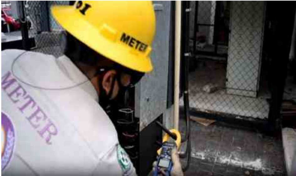
รูปที่ 3.44 ตัวอย่าง นำคลิปปอนกิโลวัตต์ปรับย่านวัดไปที่ W แล้วคล้องที่สายเฟส A
