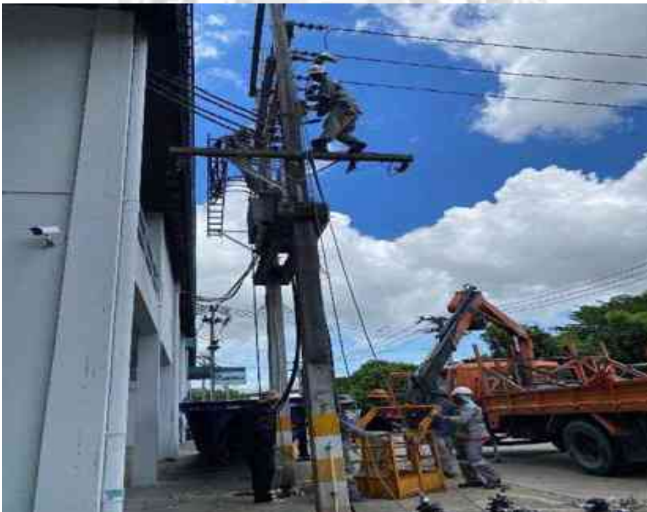
รูปที่ 3.174 ดำเนินการติดตั้ง มิเตอร์แบบประกอบ ซีที วีที แรงสูง 3 เฟส 3 สาย
