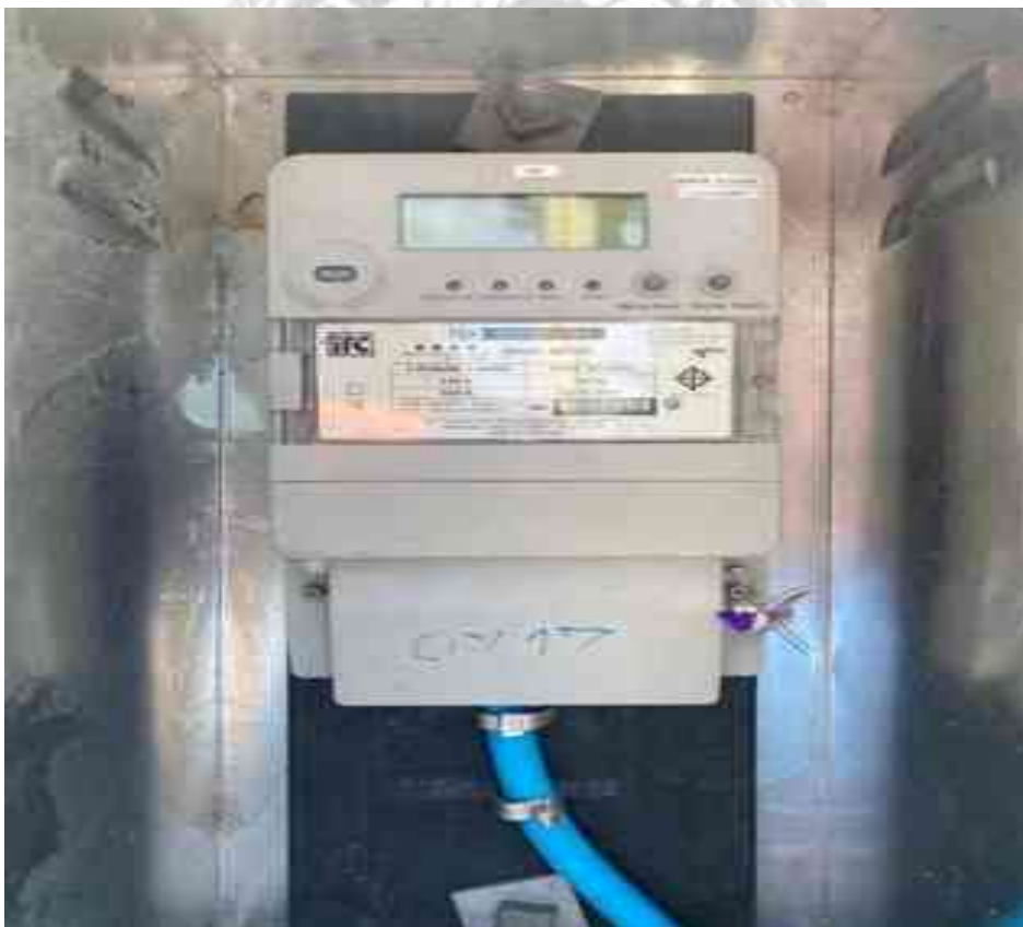
รูปที่ 3.171 ดำเนินการติดตั้ง มิเตอร์แบบประกอบ ซีที วีที แรงสูง 3 เฟส 3 สาย
