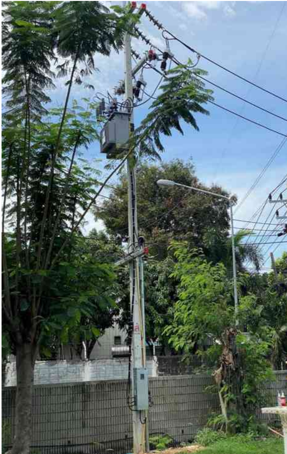
รูปที่ 3.82 ดำเนินการจ่ายไฟหลังการติดตั้งมิเตอร์แล้วเสร็จ
