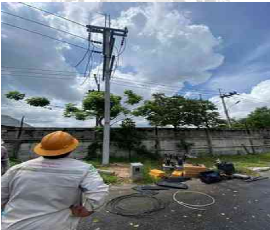
รูปที่ 3.162 ดำเนินการติดตั้ง มิเตอร์แบบประกอบ ซีที วีที แรงสูง 3 เฟส 3 สาย
