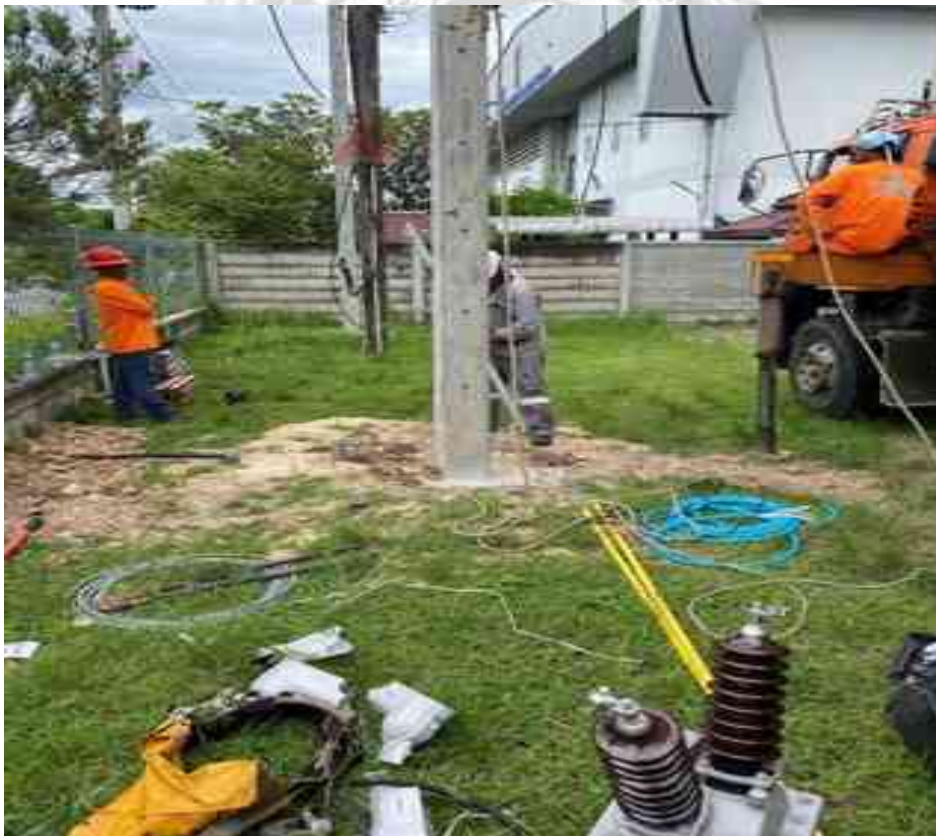
รูปที่ 3.145 ดำเนินการติดตั้ง เพิ่มขนาดเป็น มิเตอร์แบบประกอบ ซีที วีที แรงสูง 3 เฟส 3 สาย
