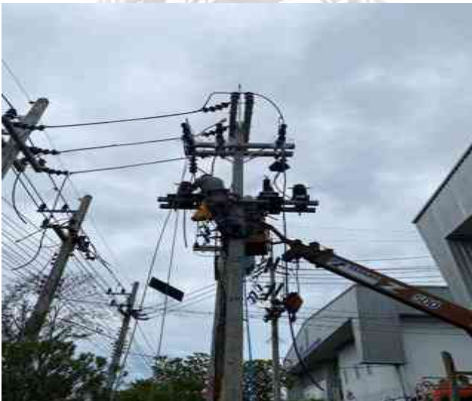
รูปที่ 3.146 ดำเนินการติดตั้ง เพิ่มขนาดเป็น มิเตอร์แบบประกอบ ซีที วีที แรงสูง 3 เฟส 3 สาย
