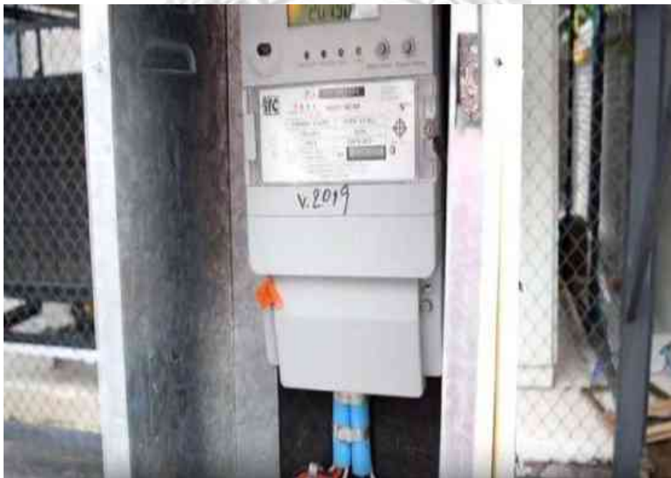
รูปที่ 3.58 ตัวอย่าง หลังจากดำเนินการตรวจสอบแล้วเสร็จ ให้ปิดฝาจุดต่อสายที่มิเตอร์และทำการติดตั้ง ตราตะกั่ว หรือ security seal อีกครั้ง เพื่อป้องกันการละเมิดสิทธิ์การใช้ไฟฟ้า
