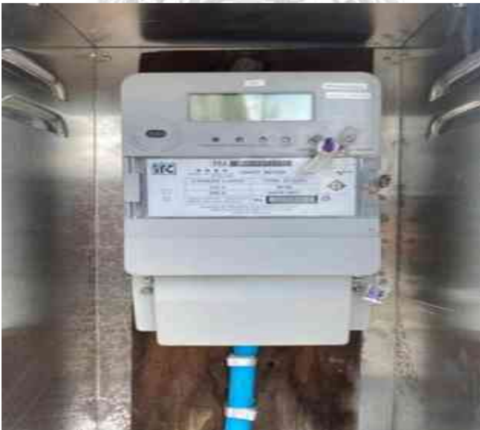
รูปที่ 3.176 ดำเนินการติดตั้ง มิเตอร์แบบประกอบ ซีที วีที แรงสูง 3 เฟส 3 สาย
