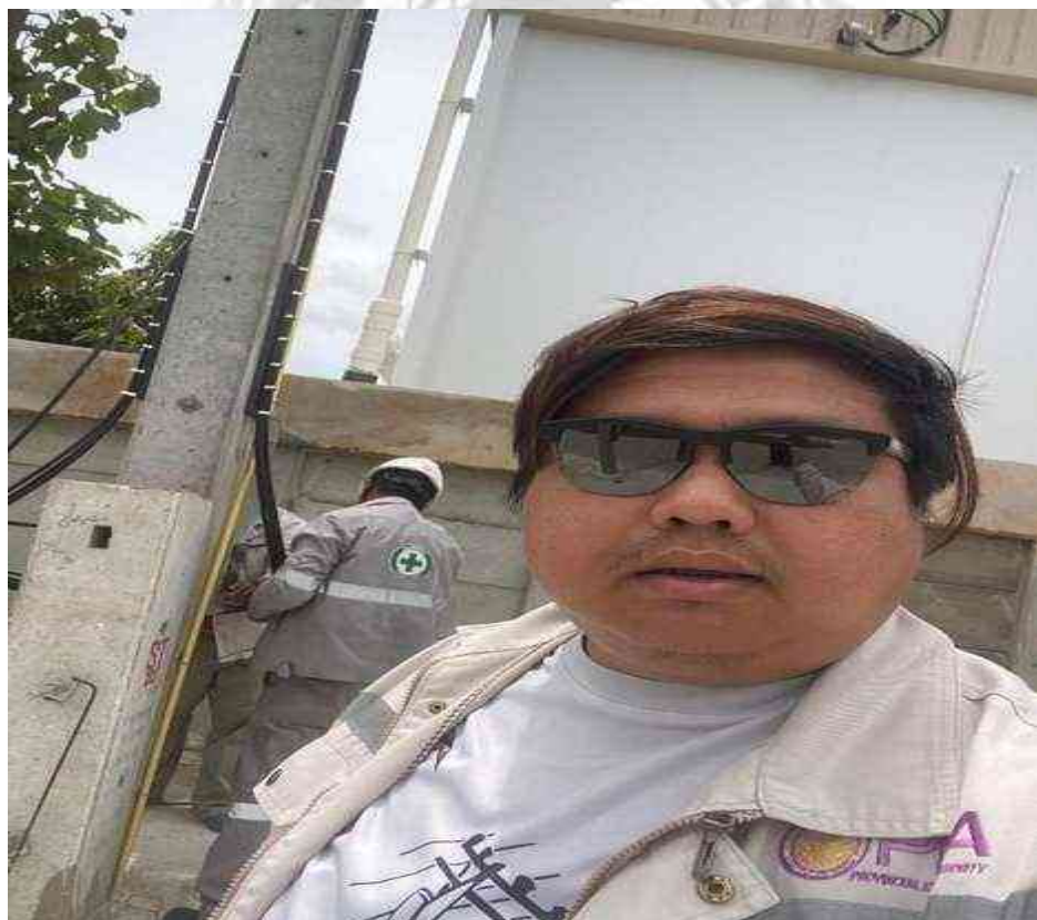
รูปที่ 3.108 การติดตั้งมิเตอร์และอุปกรณ์ประกอบ CT แรงต่ำ 3 เฟส 4 สาย
