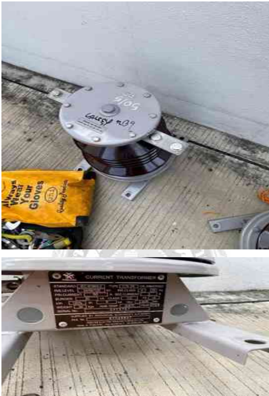
รูปที่ 3.157 ดำเนินการสับเปลี่ยนเครื่องวัดแรงสูง เพิ่มขนาด ซีที จาก 20/5 เป็น 50/5
