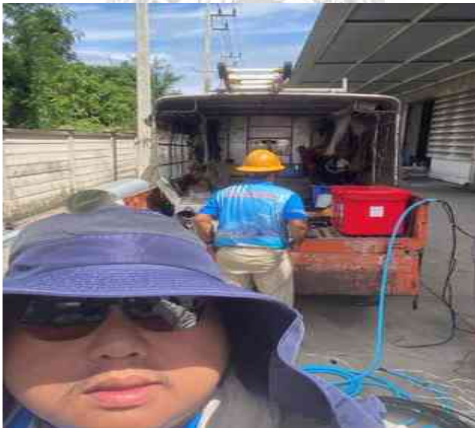
รูปที่ 3.169 ดำเนินการติดตั้ง มิเตอร์แบบประกอบ ซีที วีที แรงสูง 3 เฟส 3 สาย
