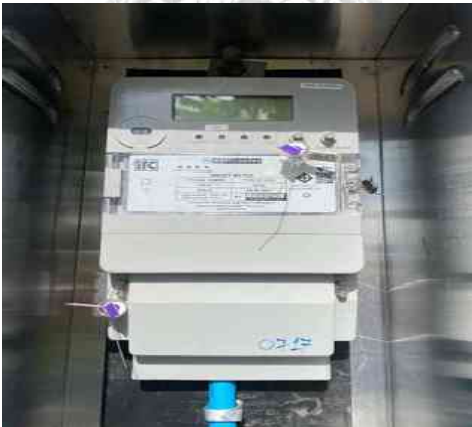
รูปที่ 3.165 ดำเนินการติดตั้ง มิเตอร์แบบประกอบ ซีที วีที แรงสูง 3 เฟส 3 สาย
