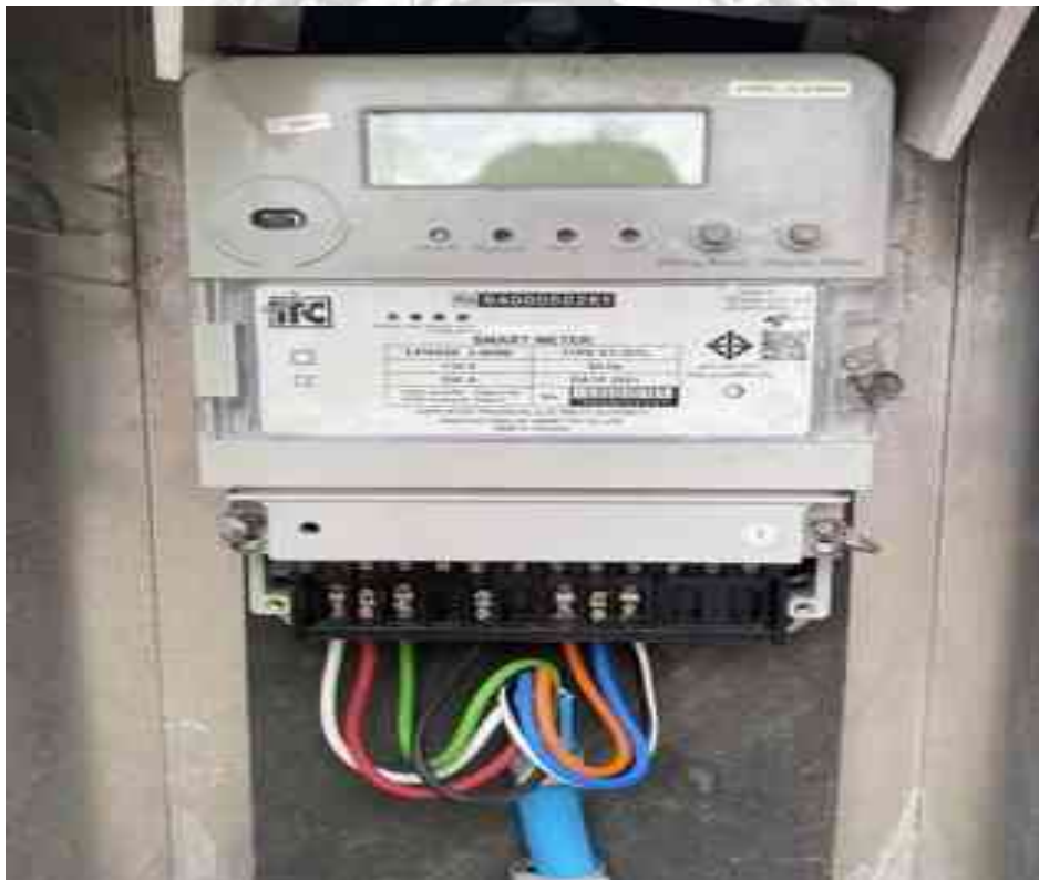
รูปที่ 3.147 ดำเนินการติดตั้ง เพิ่มขนาดเป็น มิเตอร์แบบประกอบ ซีที วีที แรงสูง 3 เฟส 3 สาย
