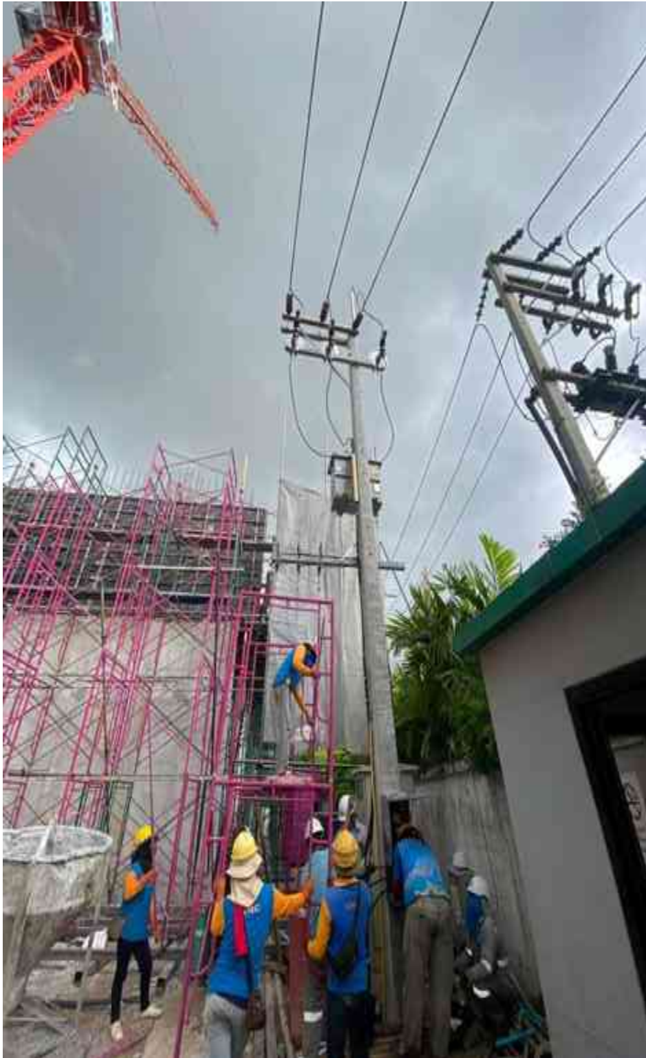
รูปที่ 3.96 ดำเนินการจ่ายไฟหลังการติดตั้งมิเตอร์แล้วเสร็จ
