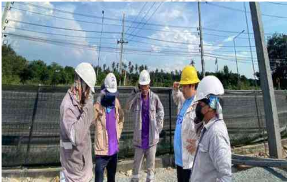
รูปที่ 3.150 การทำ KYT ก่อนเริ่มปฏิบัติงาน
