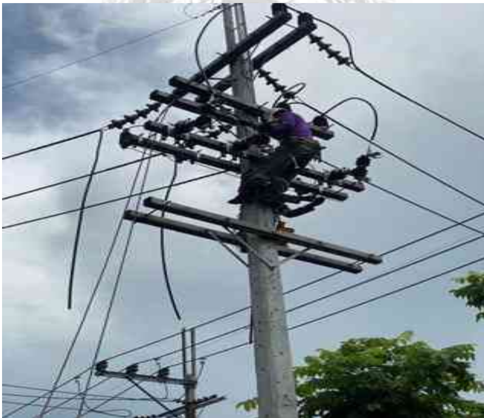
รูปที่ 3.163 ดำเนินการติดตั้ง มิเตอร์แบบประกอบ ซีที วีที แรงสูง 3 เฟส 3 สาย
