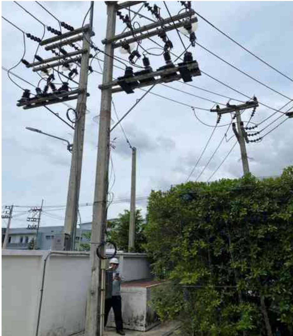
รูปที่ 3.160 ดำเนินการจ่ายไฟหลังการติดตั้งแล้วเสร็จ
