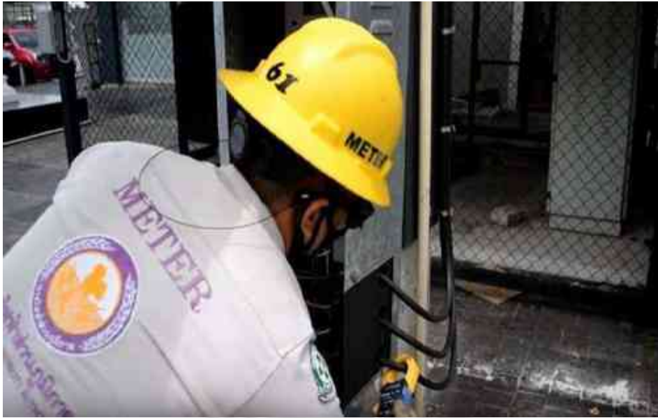
รูปที่ 3.50 ตัวอย่าง นำคัลิปออนกิโลวัตต์ปรับย่านวัดไปที่ W แล้วคล้องที่สายเฟส C
