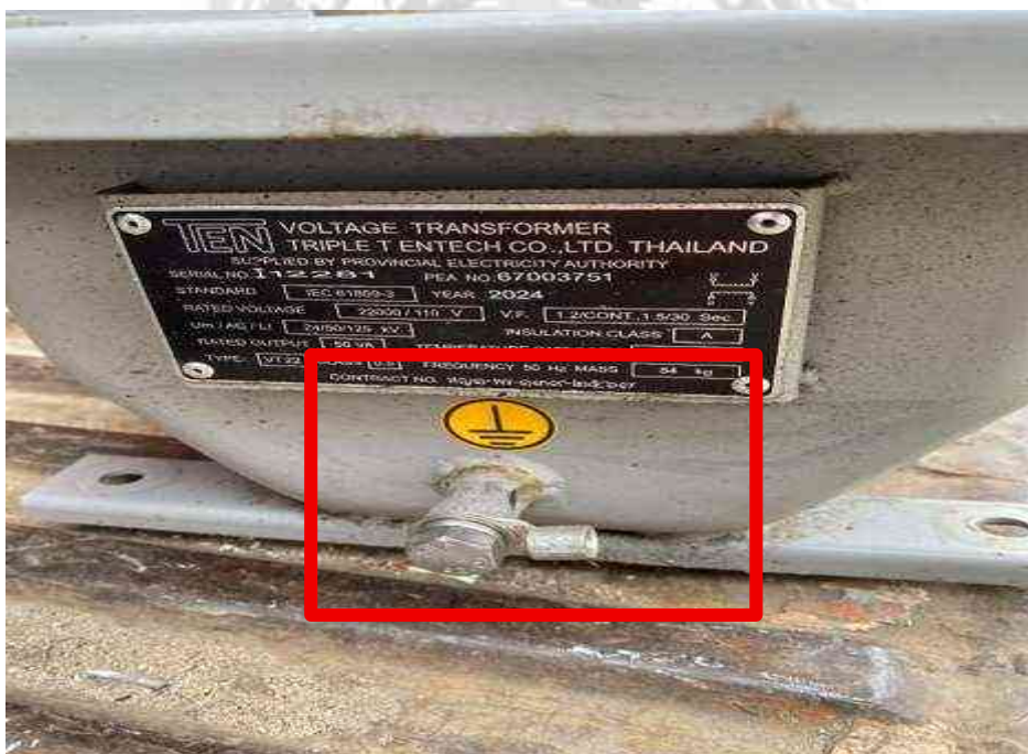
รูปที่ 3.27 ตัวอย่าง ทำการประกอบอุปกรณ์ต่างๆ ในภาพคือ ประกอบหางปลาเข้าสาย CT ด้านแรงดันสูง และ กราวด์ที่ตัวถัง CT และ VT
