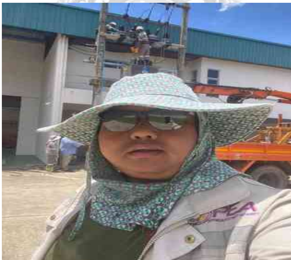
รูปที่ 3.175 ดำเนินการติดตั้ง มิเตอร์แบบประกอบ ซีที วีที แรงสูง 3 เฟส 3 สาย
