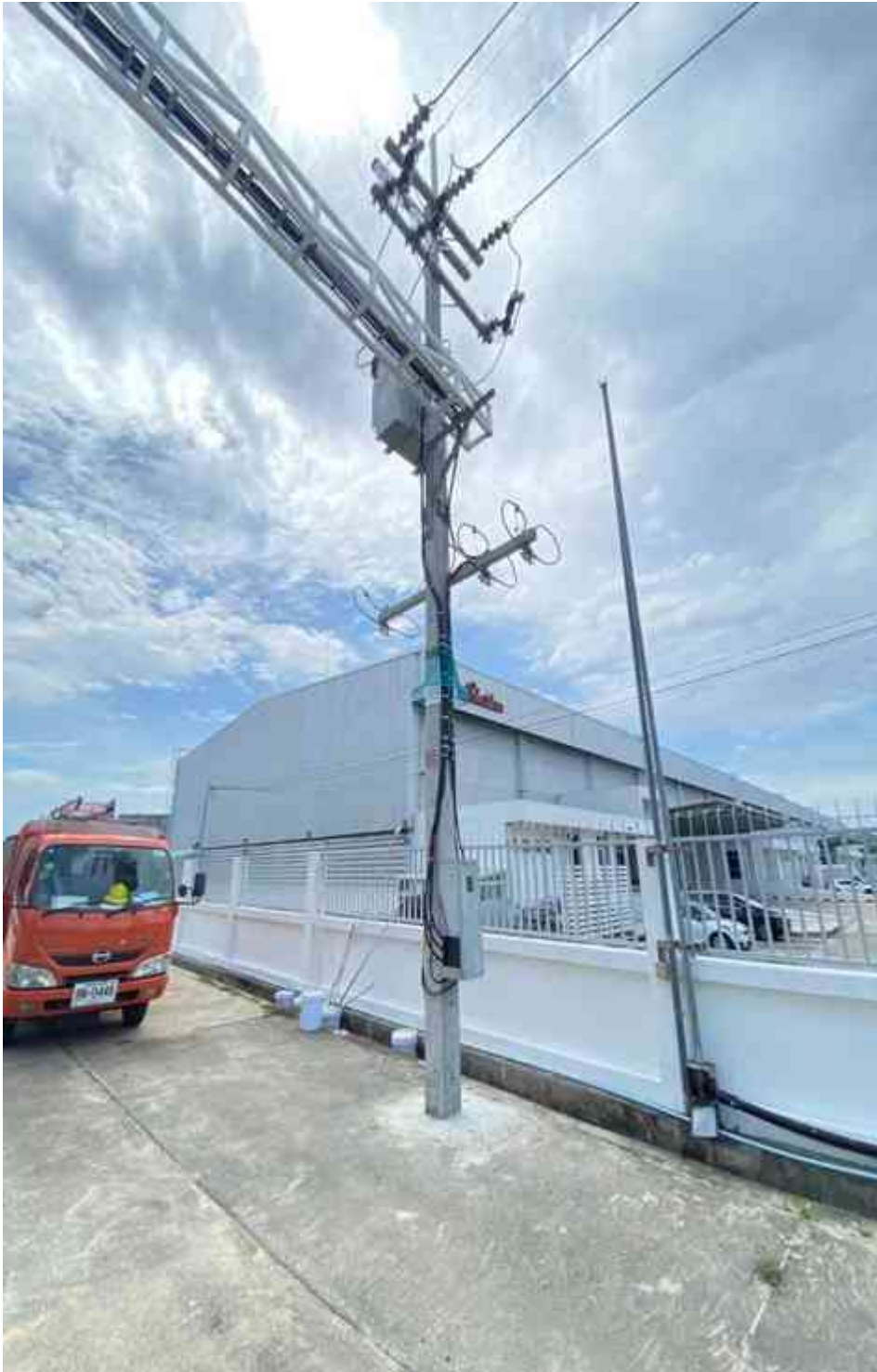
รูปที่ 3.123 ดำเนินการจ่ายไฟหลังการติดตั้งมิเตอร์แล้วเสร็จ
