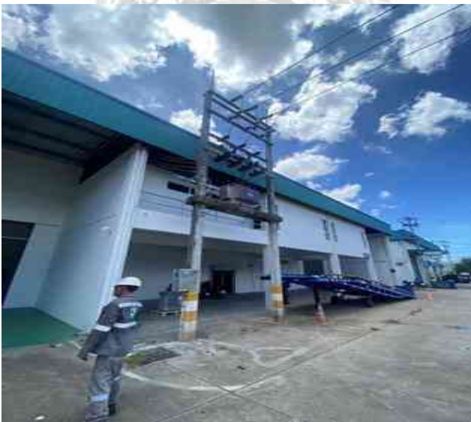
รูปที่ 3.177 ดำเนินการจ่ายไฟหลังการติดตั้งมิเตอร์เสร็จ
