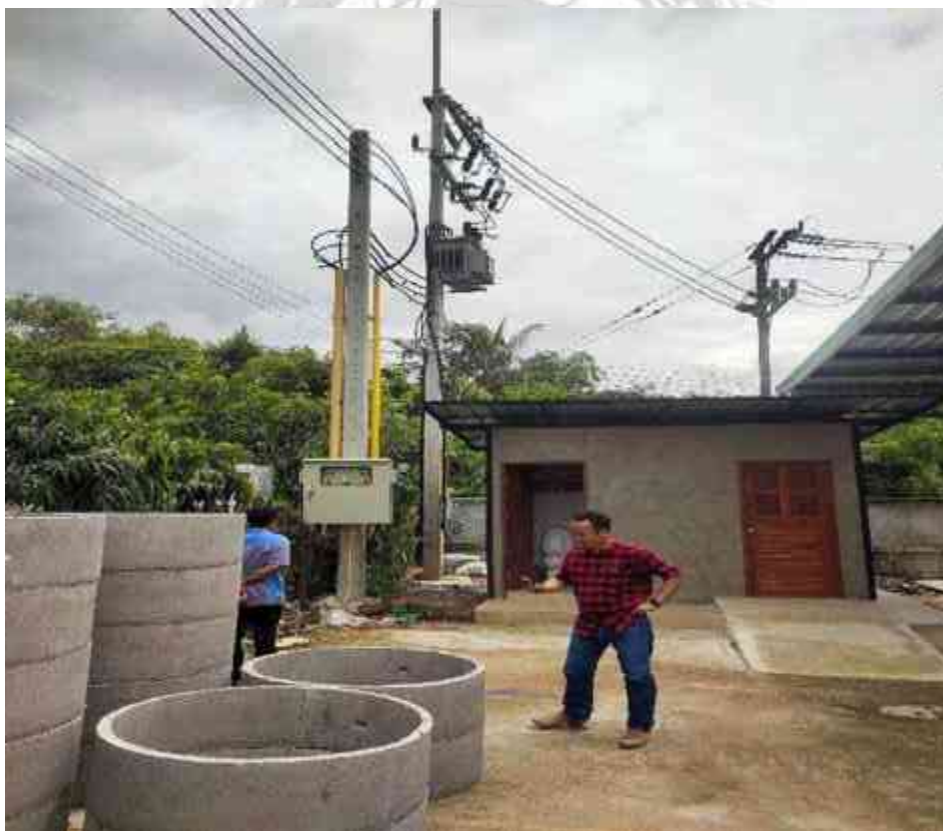
รูปที่ 3.127 ดำเนินการจ่ายไฟหลังการสับเปลี่ยนแล้วเสร็จ
