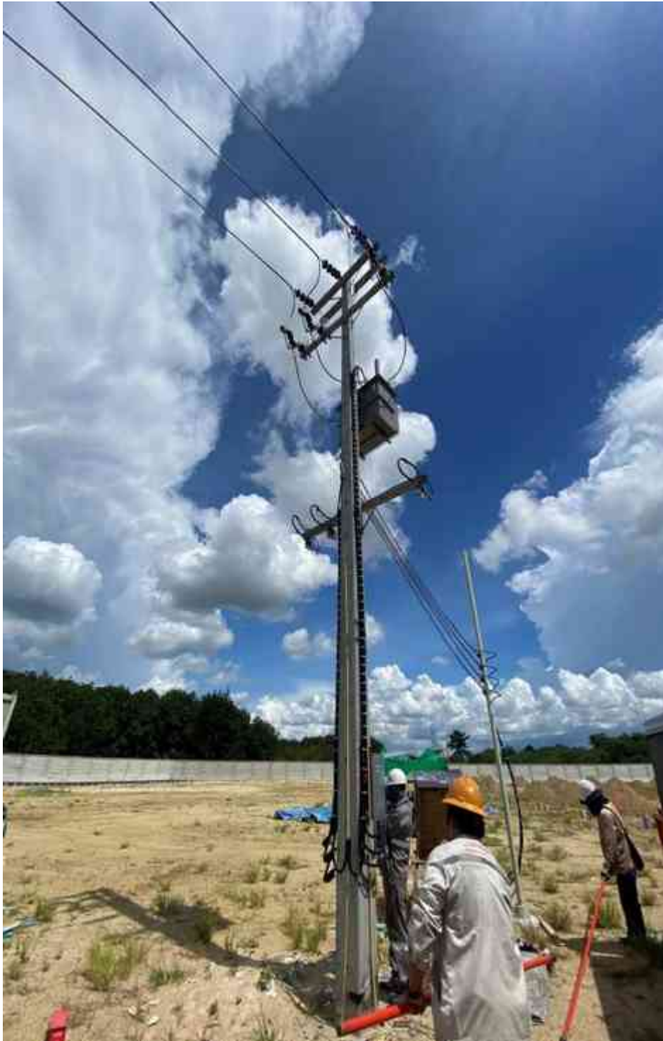
รูปที่ 3.118 ดำเนินการจ่ายไฟหลังการติดตั้งมิเตอร์แล้วเสร็จ
