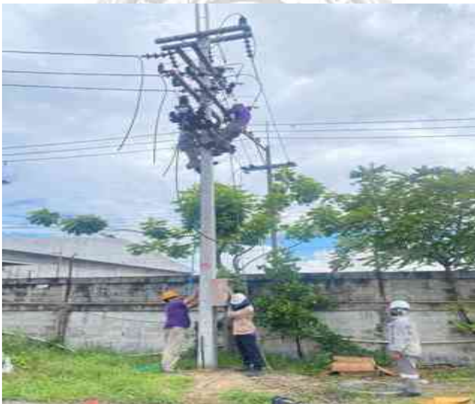
รูปที่ 3.164 ดำเนินการติดตั้ง มิเตอร์แบบประกอบ ซีที วีที แรงสูง 3 เฟส 3 สาย
