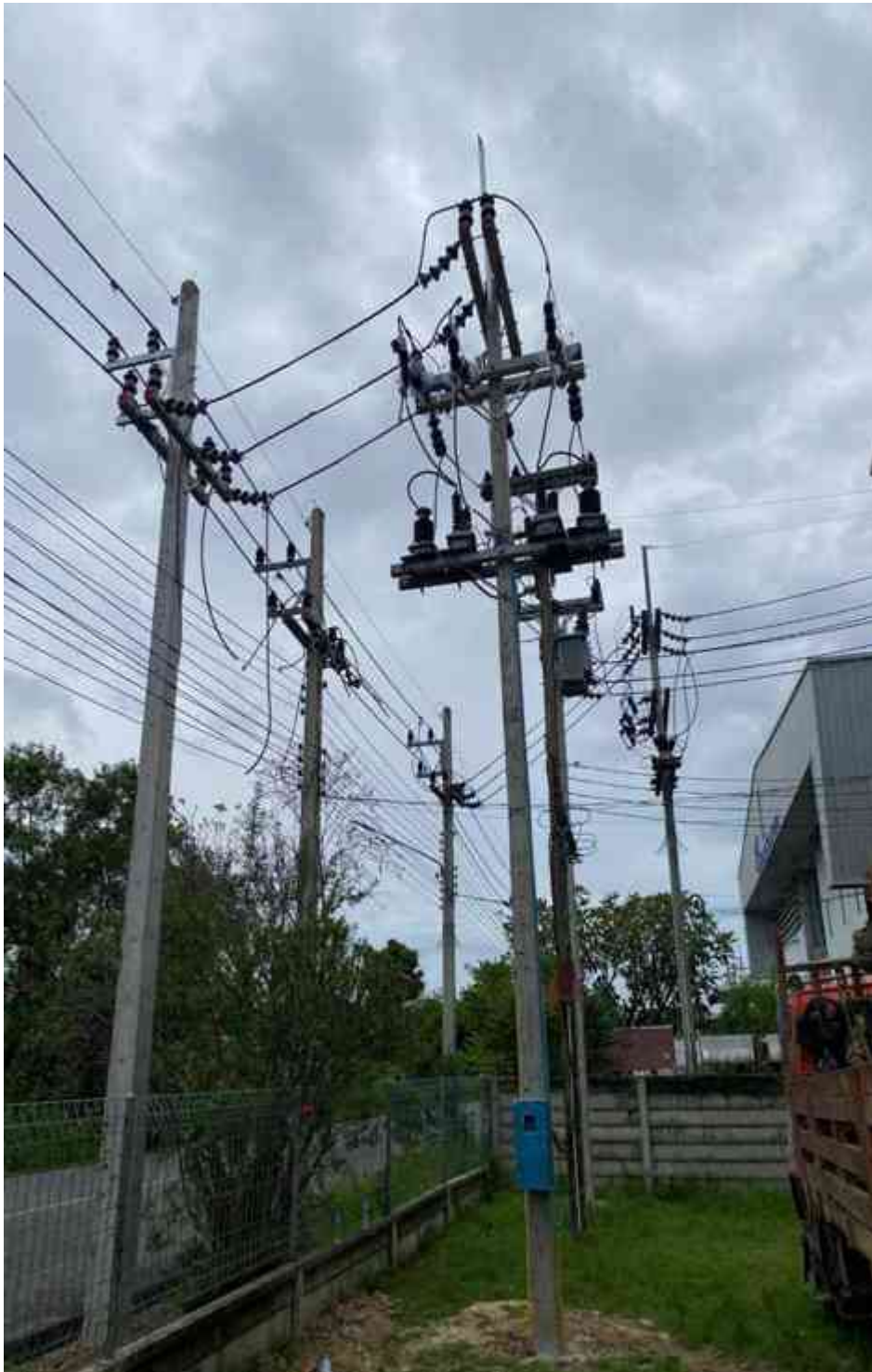
รูปที่ 3.39 ตัวอย่าง ภาพหลังจากการติดตั้งแล้วเสร็จ
