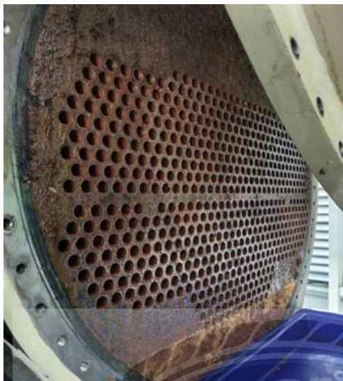
รูปที่ 4.18 ก) เครื่อง Chiller ก่อนล้าง
