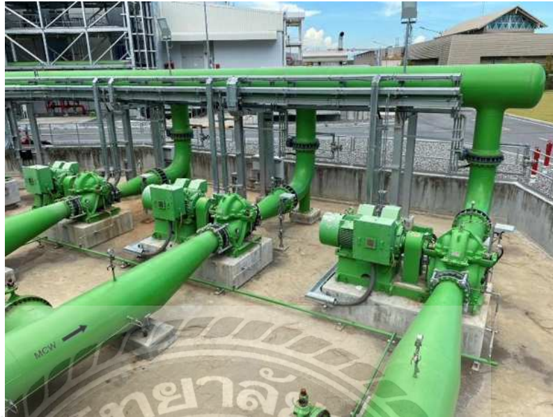
รูปที่ 4.11 ปั๊มน้ำ Main cooling
