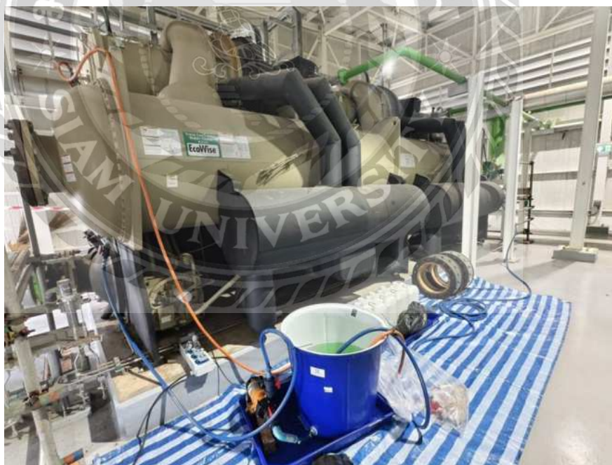
รูปที่ 4.17 เครื่อง Chiller ที่ทำการปรับปรุง
