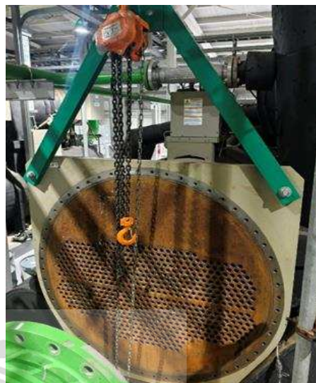
รูปที่ 4.18 ข) เครื่อง Chiller หลังล้าง
