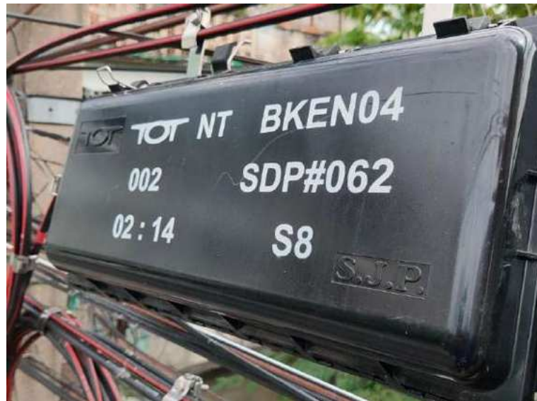
รูปที่ 3.18 ตู้แยกสัญญาณ SDP (Splitter Distribution Point)
