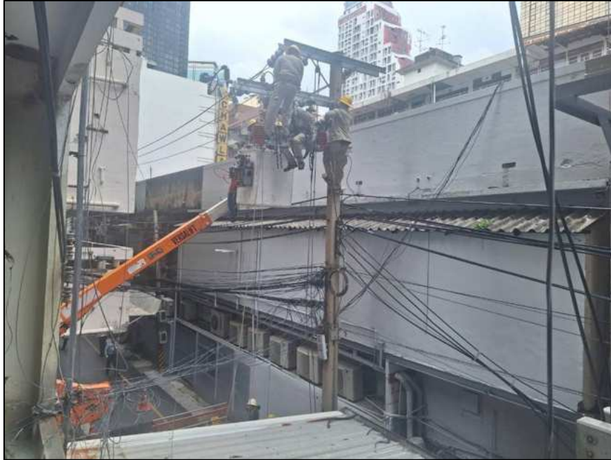
รูปที่ 3.38 เจ้าหน้าที่ทำการติดตั้ง Surge Arrester บนหัวเสา
