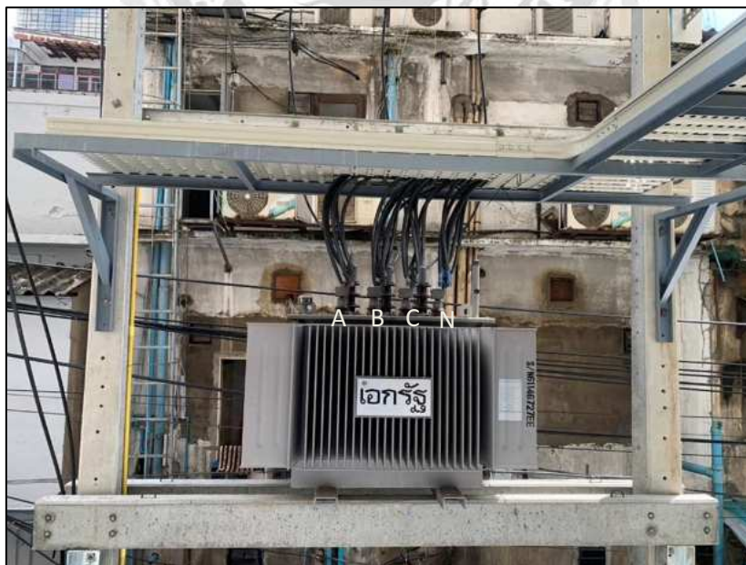
รูปที่ 3.35 ติดตั้งสายไฟทางด้านหม้อแปลงไฟฟ้าเสร็จเรียบร้อย
