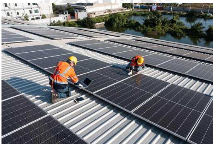
รูปที่ 2.5 การติดตั้งเซลล์พลังงานแสงอาทิตย์
