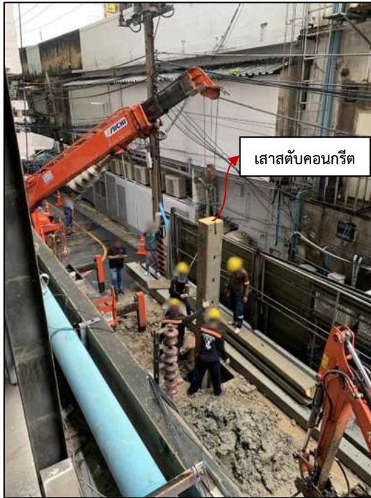
รูปที่ 3.16 ติดตั้งเสาเสตบคอนกรีต
