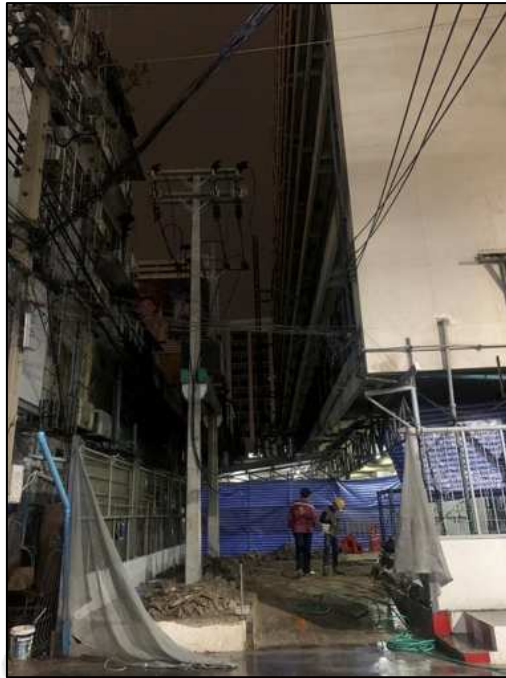
รูปที่ 3.26 ติดตั้งหม้อแปลงและอุปกรณ์หัวเสาเสร็จเรียบร้อยแล้ว
