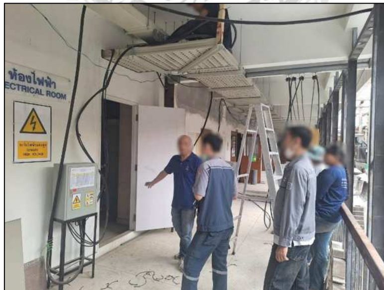
รูปที่ 3.29 ติดตั้งราง Cable Tray ทางด้านห้องไฟฟ้า
