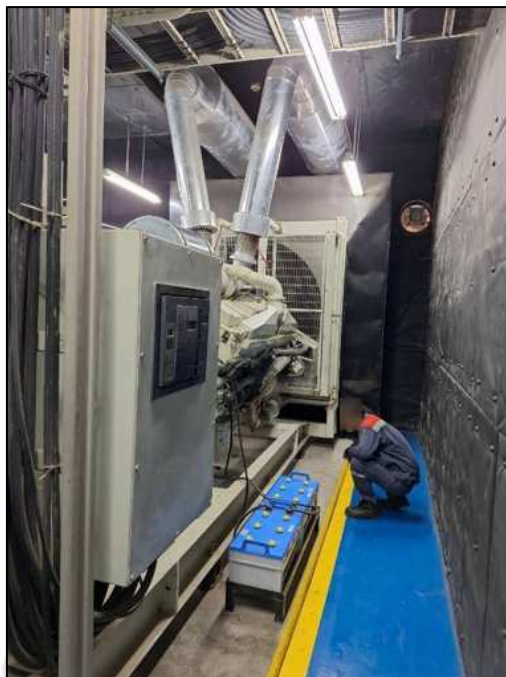
รูปที่ 3.50 ตรวจสอบการรั่วซึม
