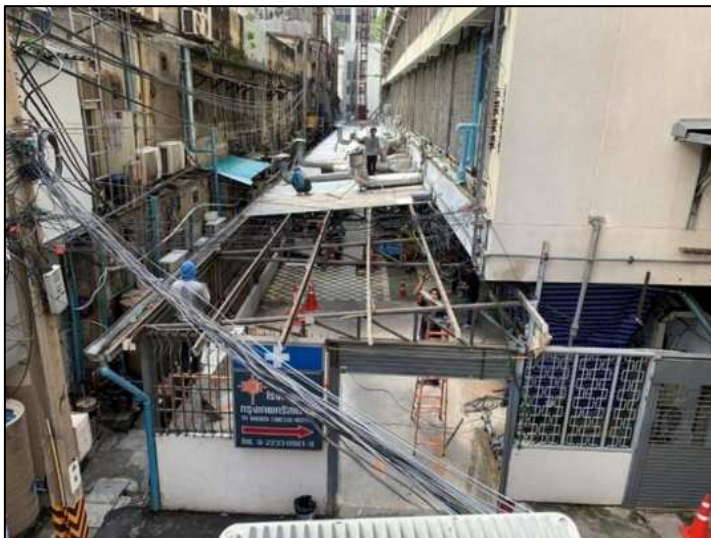
รูปที่ 3.9 รื้อถอนสิ่งปลูกสร้างเก่า
