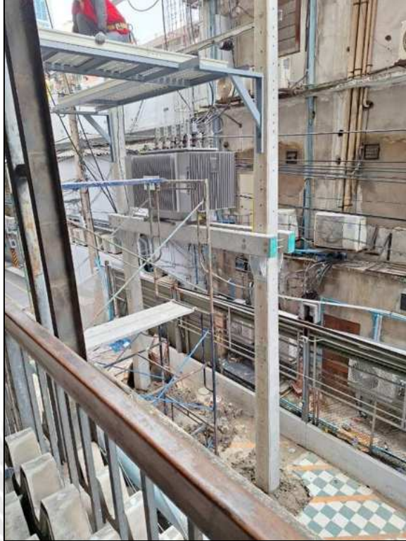
รูปที่ 3.28 ติดตั้งราง Cable Tray ทางด้านหม้อแปลง
