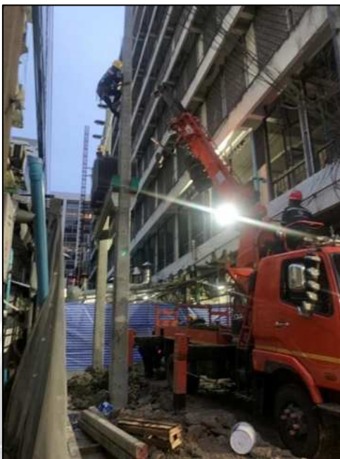
รูปที่ 3.24 ติดตั้งหม้อแปลงไฟฟ้าไว้บนคานนั่งร้าน
