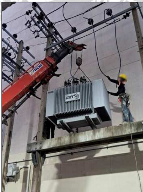
รูปที่ 3.23 เคลื่อนย้ายหม้อแปลงไฟฟ้า
