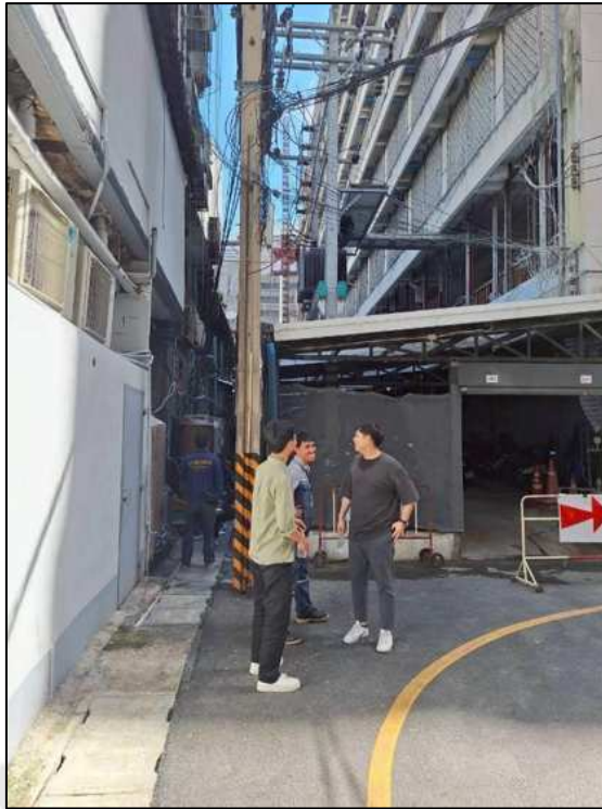
รูปที่ 3.45 ดำเนินการติดตั้งหม้อแปลงไฟฟ้าขนาด 1,000 kVA เสร็จเรียบร้อย
