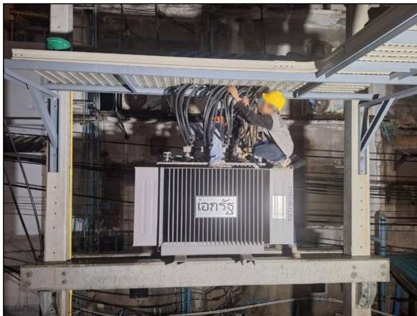
รูปที่ 3.34 เข้าสายไฟที่ขั้วแรงต่ำของหม้อแปลงไฟฟ้า
