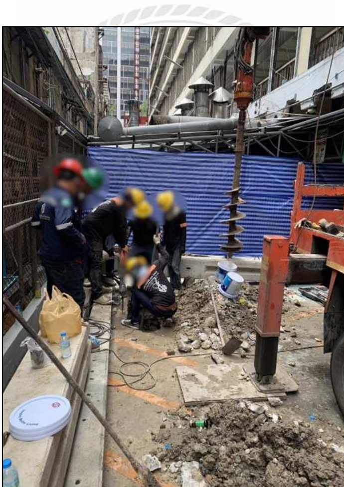
รูปที่ 3.14 การเจาะพื้นคอนกรีตเพื่อติดตั้งเสาน้ำรั่ว (คอร์.)
