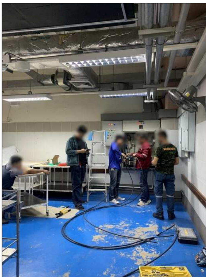
รูปที่ 3.13 เชื่อมต่อสายไฟฟ้าเพื่อใช้งานชั่วคราว
