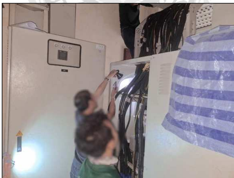
รูปที่ 3.33 ติดตั้งสายไฟทางด้านตู้ MDB
