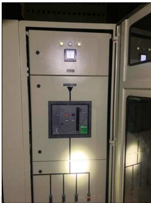
รูปที่ 3.43 ตรวจสอบการทำงานของระบบไฟฟ้า (2)
