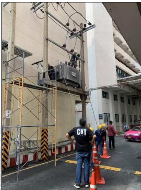
รูปที่ 3.22 ปลดสายไฟออกจากหม้อแปลง
