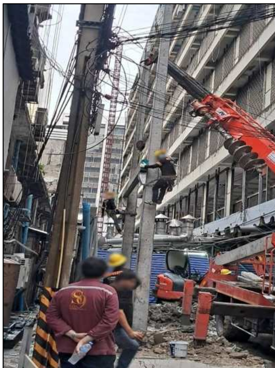
รูปที่ 3.19 ติดตั้งคานนั่งร้านหม้อแปลง
