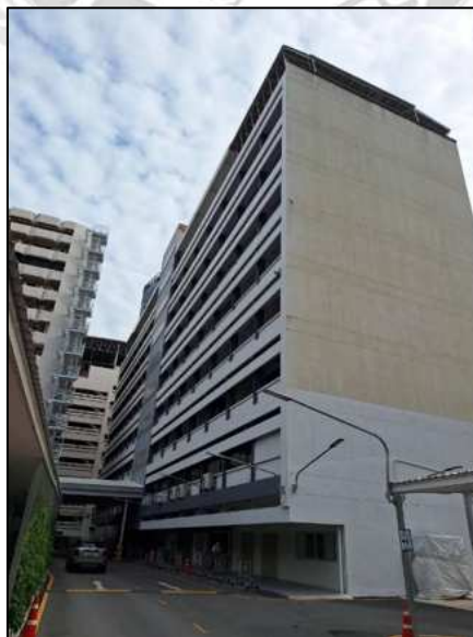
รูปที่ 3.6 อาคารที่ทำการย้ายหม้อแปลงไฟฟ้า ขนาด 1,000 kVA
