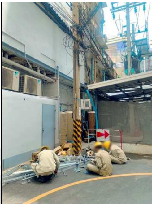
รูปที่ 3.36 เจ้าหน้าที่เตรียมอุปกรณ์สำหรับติดตั้งหัวเสา
