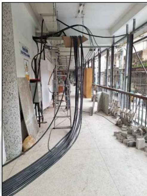
รูปที่ 3.30 เดินสายไฟฟ้า XLPE ขนาด 240 SQ.mm จากหม้อแปลงไฟฟ้าไปยังตู้ MDB
