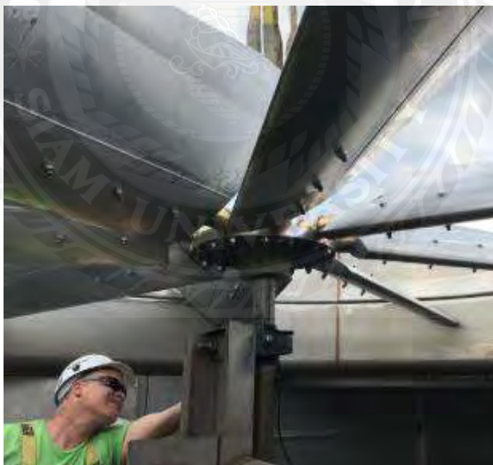
รูปที่ 3.12 การตรวจสอบพัดลม
