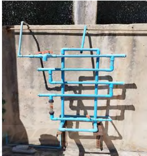
รูปภาคผนวกที่ ข.7 Coupong ตรวจสอบ material ภายในท่อ
