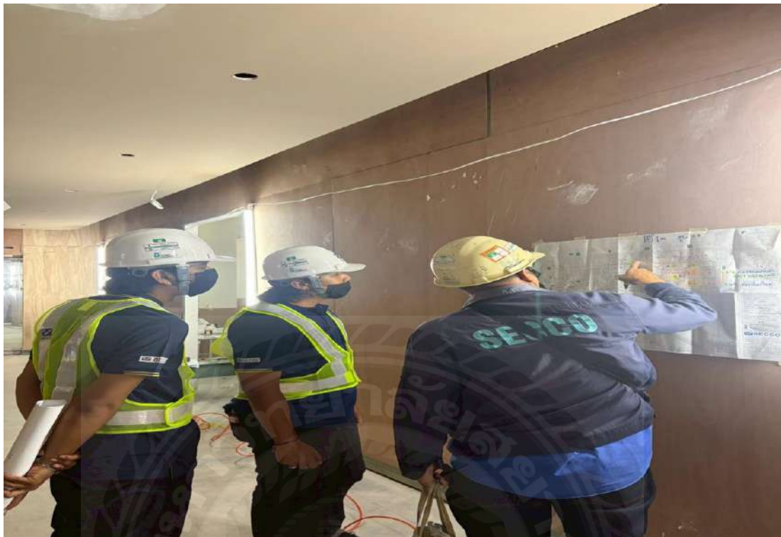
รูปภาคผนวกที่ 6 นักศึกษาฝึกงานตรวจสอบความสอดคล้องกับแบบก่อสร้าง
