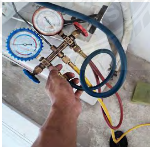
รูปที่ 3.24 อัดก๊าซไนโตรเจนเข้าสู่ระบบ
