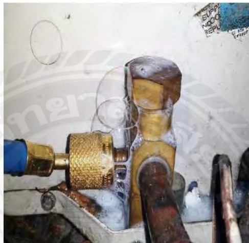
รูปที่ 3.23 ตรวจสอบทุกจุดเชื่อมต่อด้วยน้ำสบู่
