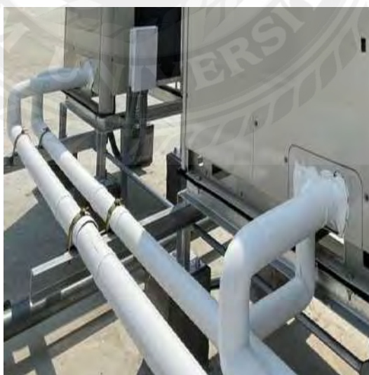
รูปที่ 3.32 การเก็บงานหลังจากงานติดตั้ง
