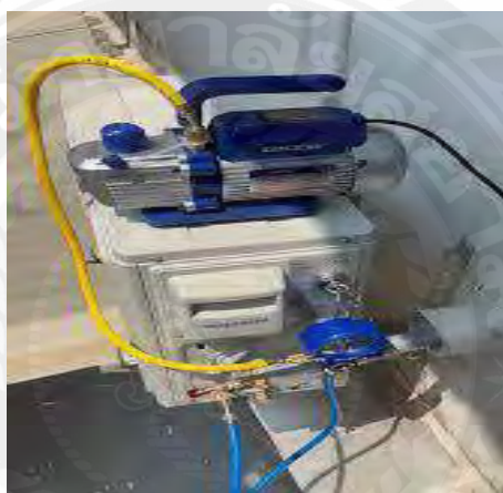
รูปที่ 3.27 การทำสุญญากาศ (Vacuum)
