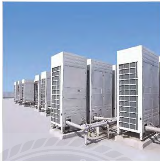
รูปที่ 3.14 Variable Refrigerant Flow
