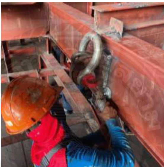
รูปที่ 2.15 การเจียรระไนเพื่อเตรียมพื้นผิวก่อนทำการทดสอบแนวเชื่อมด้วยวิธี PT
