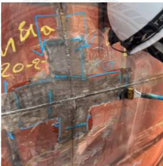
รูปที่ 3.22 ตัวอย่างของผิวงานที่ผ่านการเตรียมพื้นผิว
