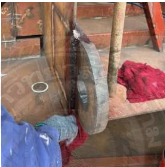
รูปที่ 2.17 ตัวอย่างการทำความสะอาดแนวเชื่อมก่อนทำการทดสอบแนวเชื่อมด้วยวิธี PT
