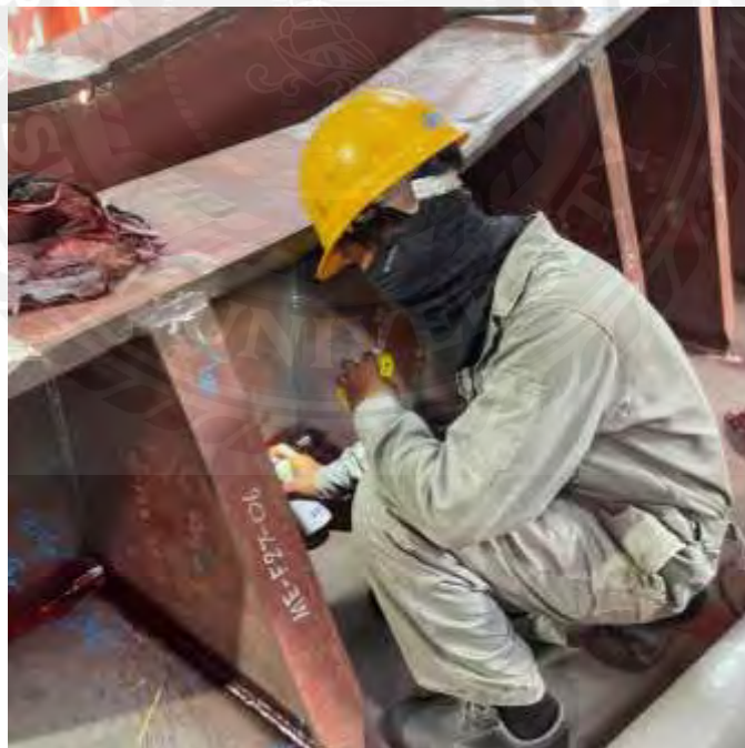
รูปภาคผนวกที่ 7 ขณะพ่นน้ำยาแทรกซึม
