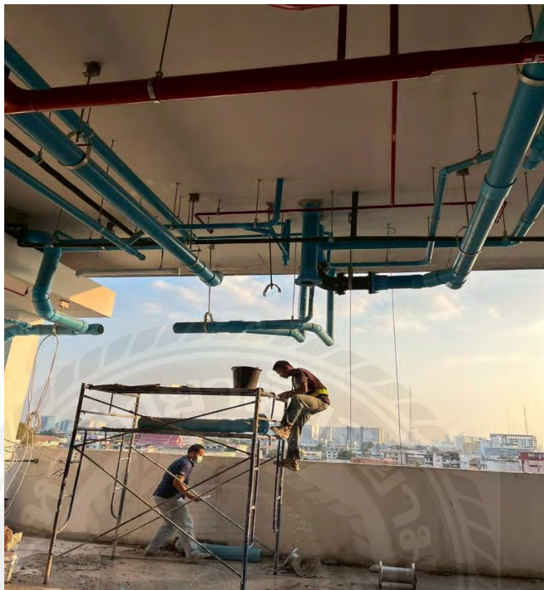
รูปที่ 7 การแก้ไขท่อน้ำทิ้งที่อุดตันตำแหน่งแนวระดับ
