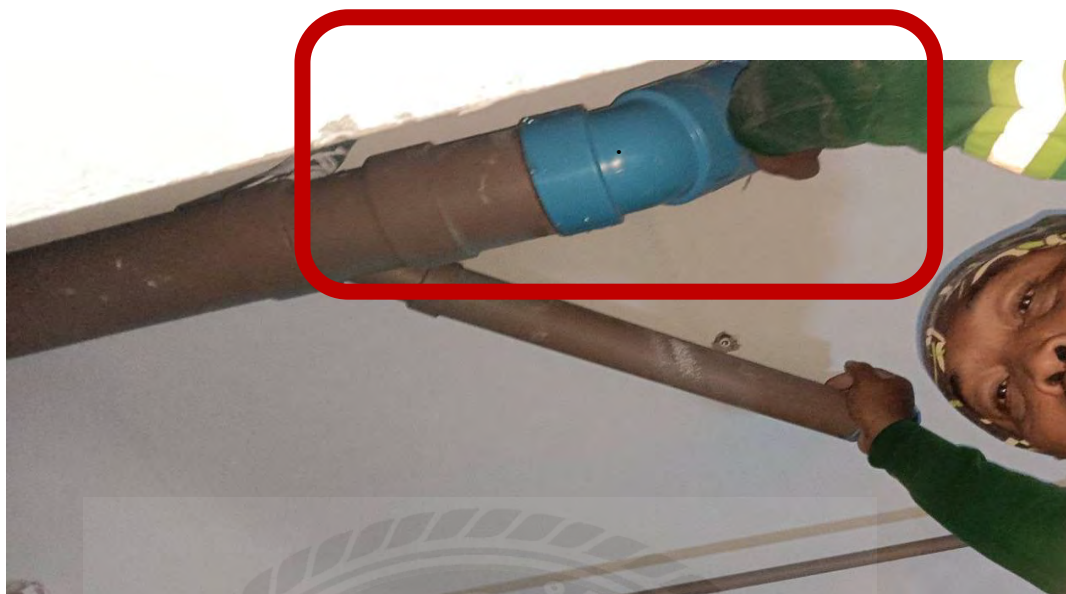
รูปที่ 3.19 การติดตั้งท่อ 45 องศาในระบบท่อน้ำทิ้ง
