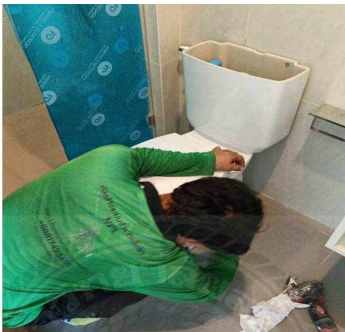
รูปที่ 11 การแก้ไขปัญหาโถสุขภัณฑ์อุดตันตำแหน่งภายในท่อน้ำโครก
