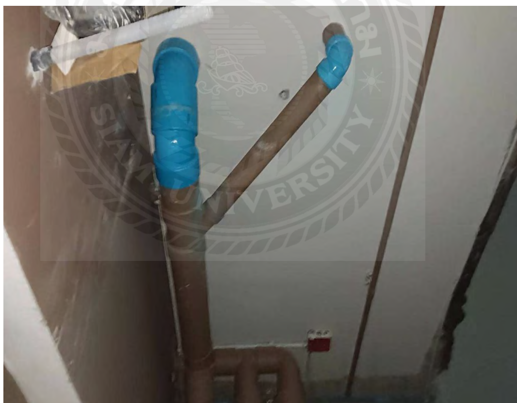
รูปที่ 3.19 การติดตั้งท่อ 45 องศาในระบบท่อน้ำทิ้ง
