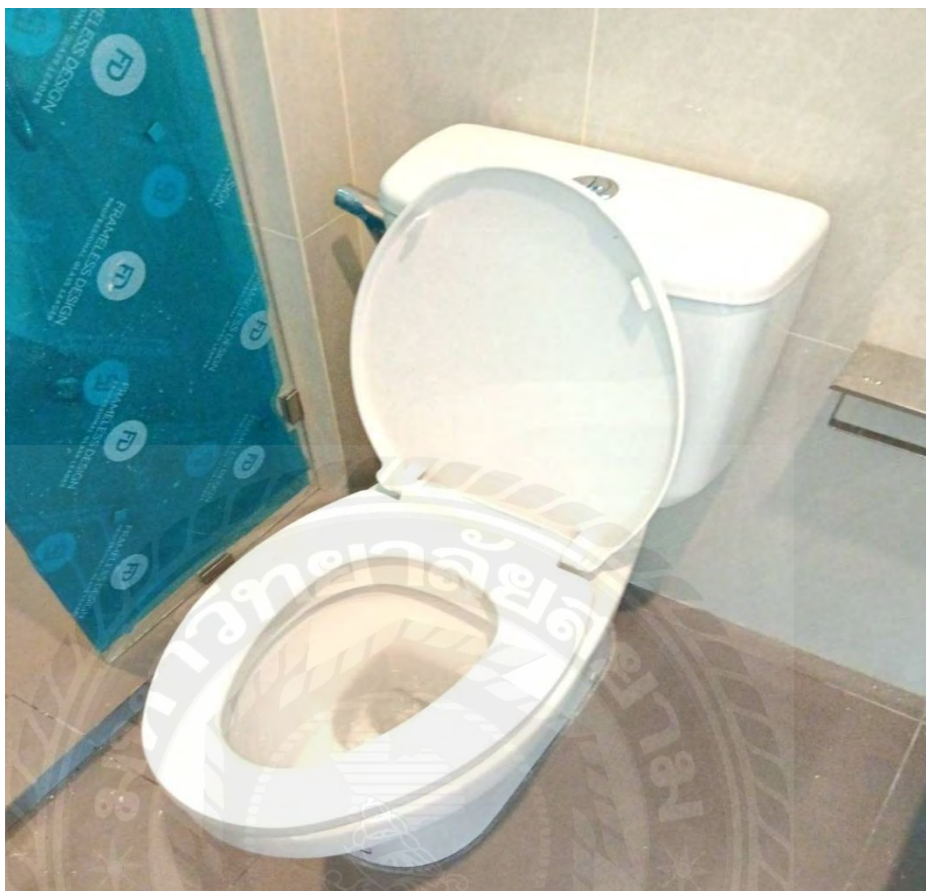
รูปที่ 3.30 ช่อมแซมและแก้ไขโถสุขภัณฑ์เสร็จสมบูรณ์
