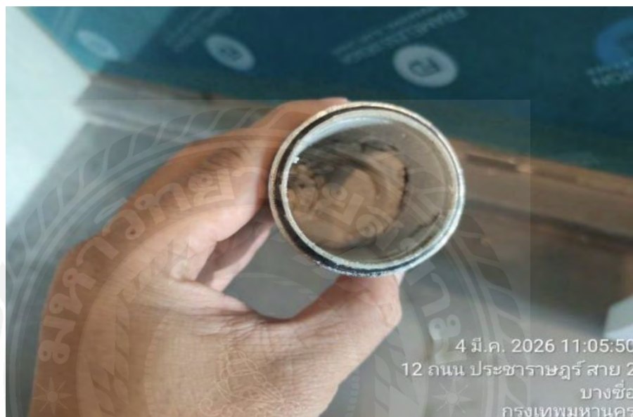
รูปที่ 3.25 ถอดท่อน้ำทิ้งอ่างล้างหน้าแก้ไขปัญหาการอุดตัน
