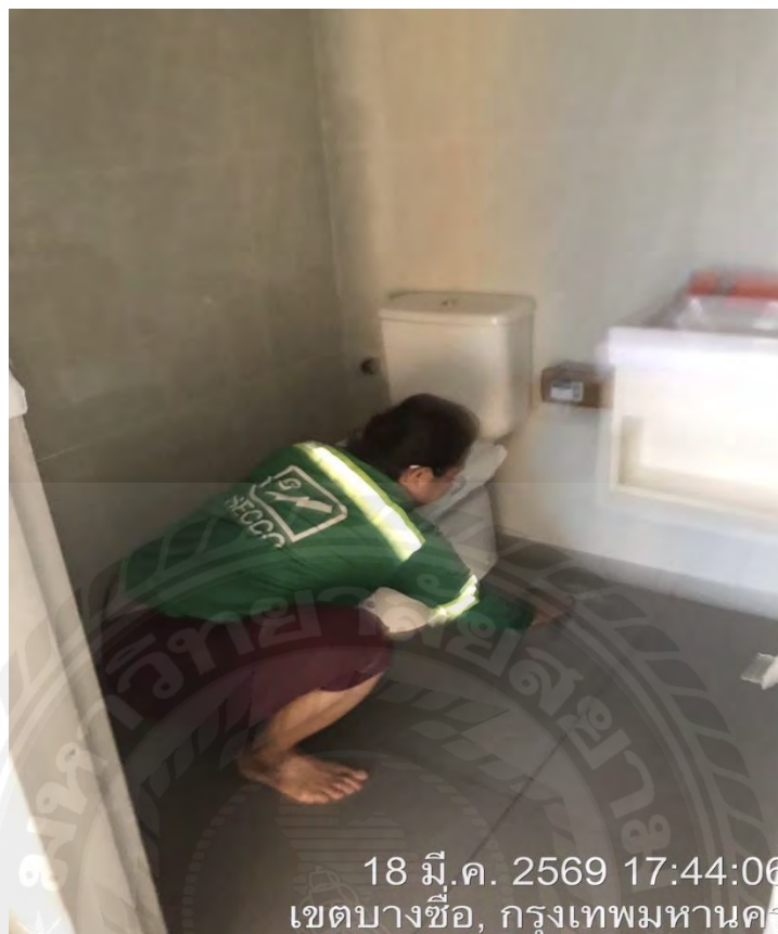
รูปที่ 9 การแก้ไขปัญหาโถสุขภัณฑ์อุดตันตำแหน่งที่เชื่อมต่อสุขภัณฑ์กับท่อโสโครก
