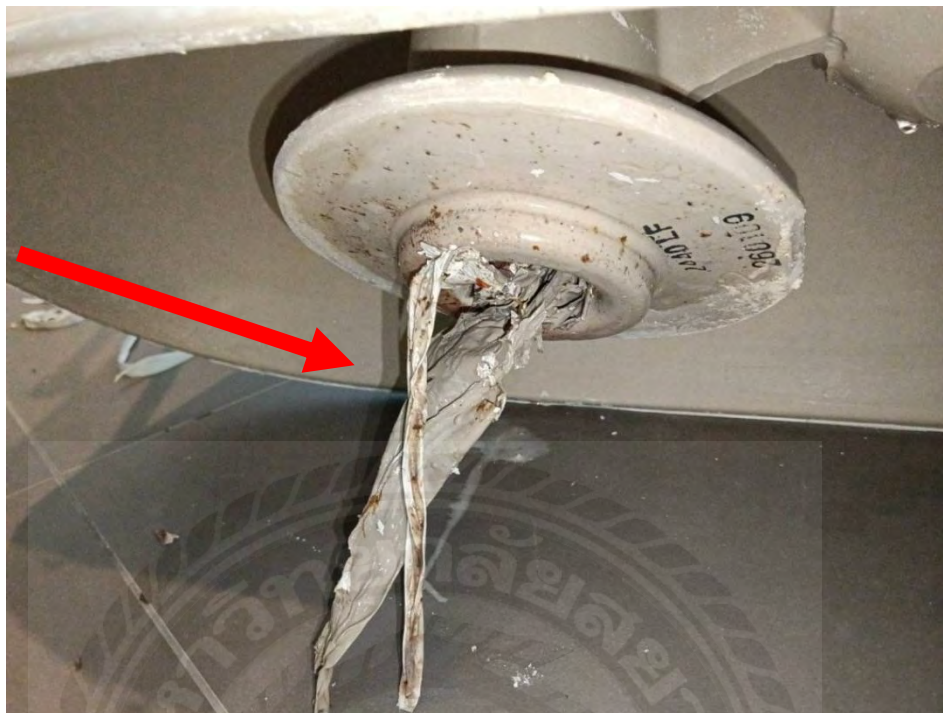
รูปที่ 3.29 ตรวจสอบและแก้ไขปัญหาโถสุขภัณฑ์อุดตันจากเศษพลาสติก
