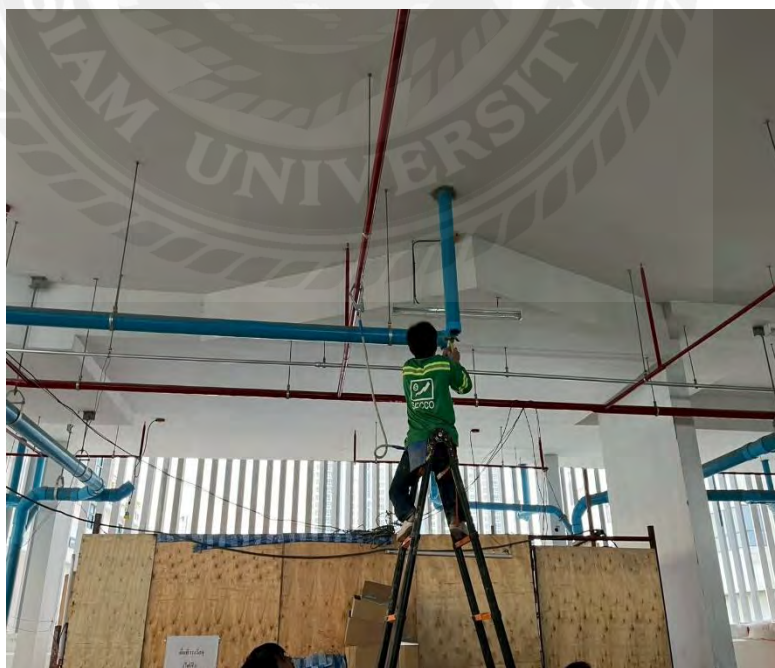
รูปที่ 8 การแก้ตันท่อน้ำทิ้งตำแหน่งข้องอ 90 องศา
