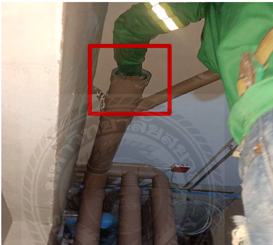
รูปที่ 3.17 การนำเศษปูนภายในท่อออก
