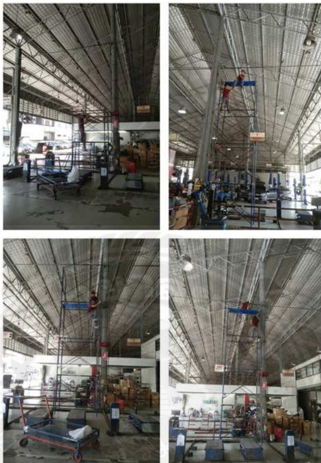
รูปที่ 4.24 ดำเนินงานติดตั้งอุปกรณ์ สาขาดาวคะนอง
