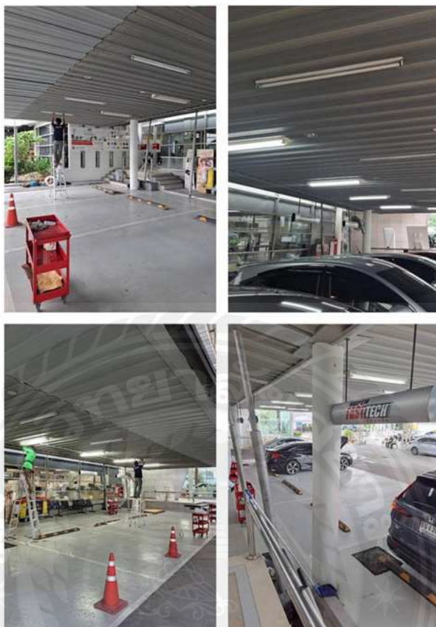
รูปที่ 4.13 เตรียมพื้นที่ดำเนินงานปิดพื้นที่กันกรวยป้องกัน สาขาสาธิตประดิษฐ์
