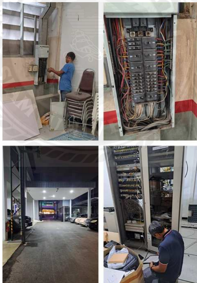
รูปที่ 4.27 ดำเนินงานจากทีมงานเข้าร่วมทดสอบตรวจงานให้ตรงตามการออกแบบ
