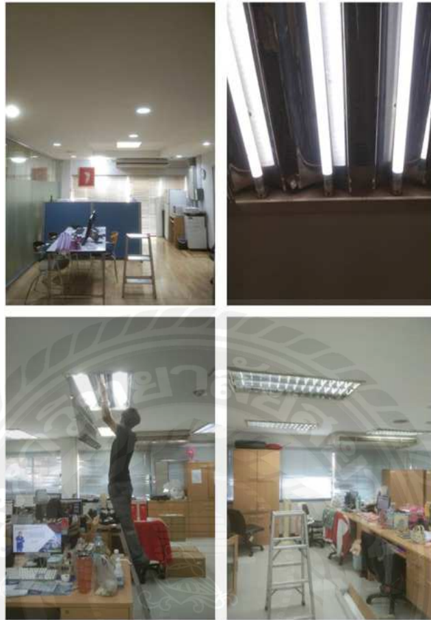
รูปที่ 4.22 ดำเนินงานติดตั้งอุปกรณ์ สาขาดาวคะนอง
